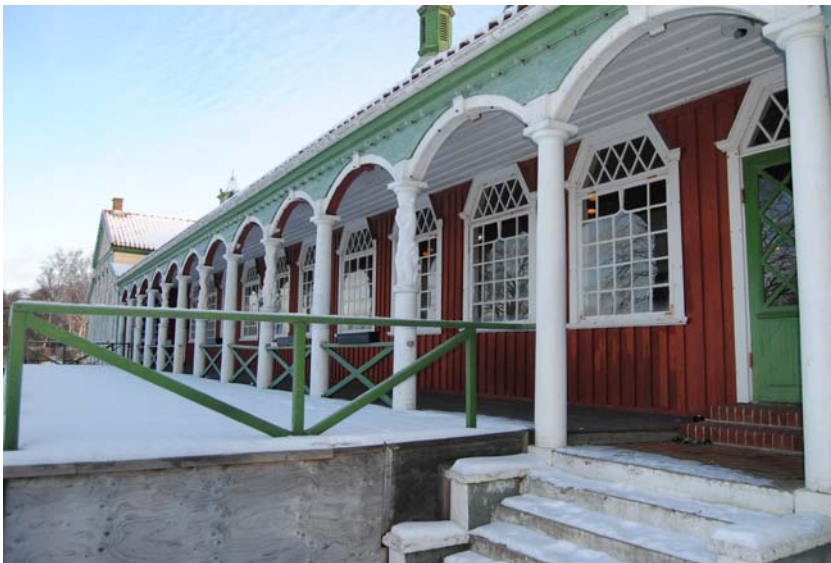
Loggian. Den påbyggda verandadäcket framför ska rivas.
