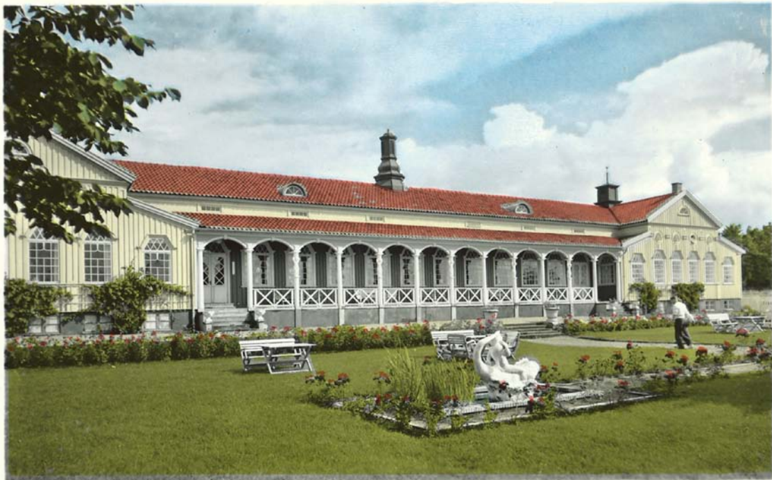
Strandhotellet efter renoveringen i början av 1950-talet. (Foto Föreningen Gamla Laholms arkiv).
