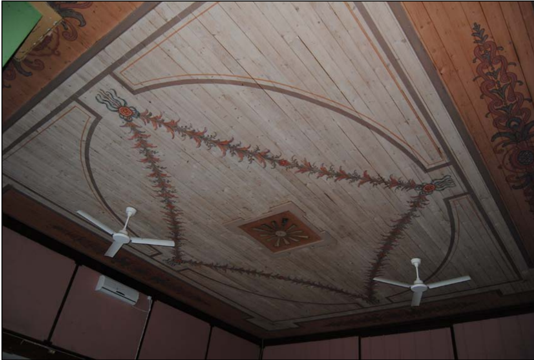
Tak med dekormålning. Notera brädtaket som tydligt framträder genom de tunna färglagren.
