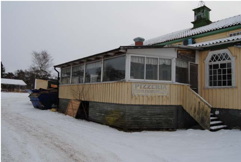
Den tillbyggda delen i norra änden som ska rivas.
