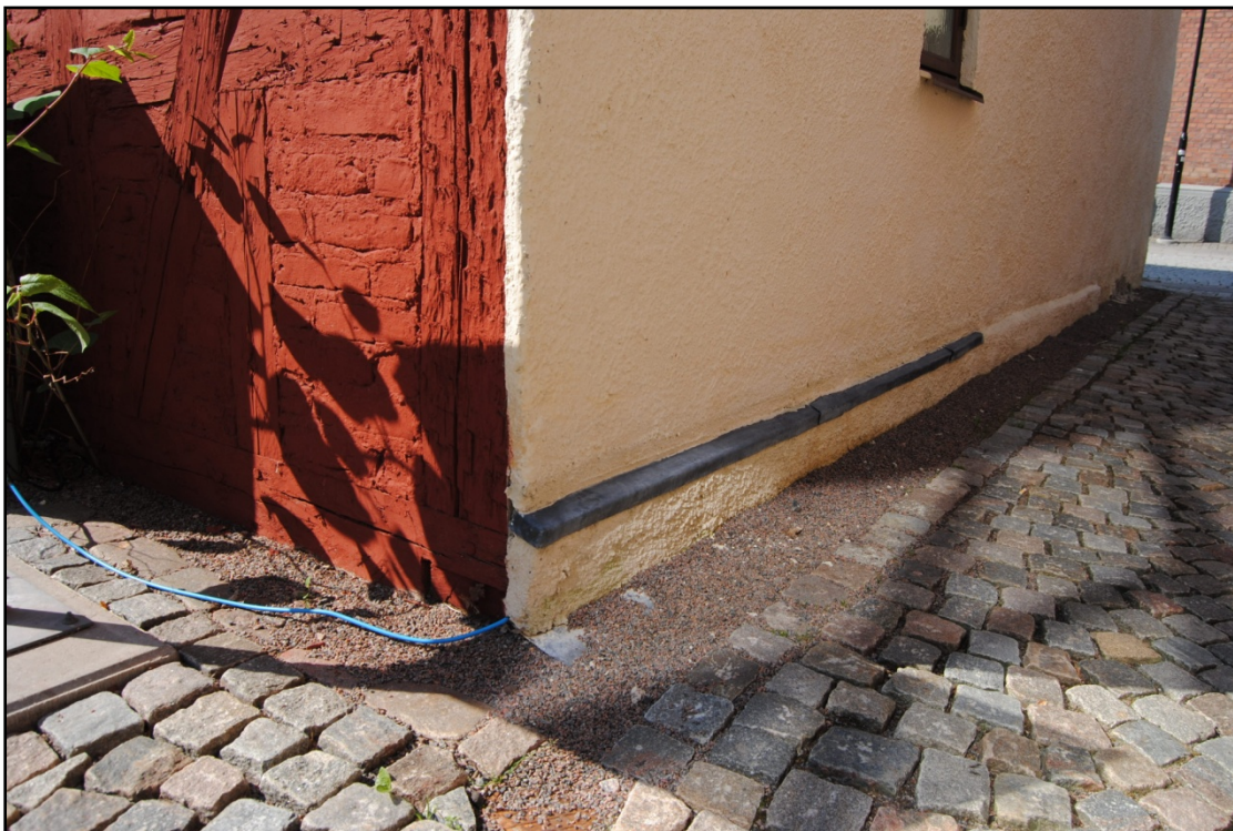
Provyta på del av den norra fasaden.
