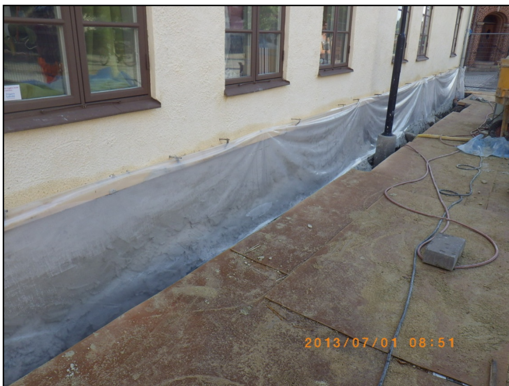
Bruket täcks in för att inte torka för fort när solen ligger på (foto Bröderna Bergström AB).
