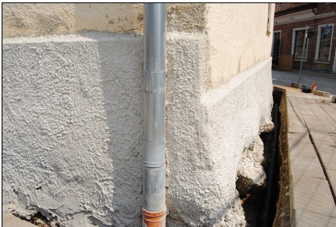
Hörnet Östertullsgatan/Trädgårdsgatan. Här syns också nytt dräneringsrör.
