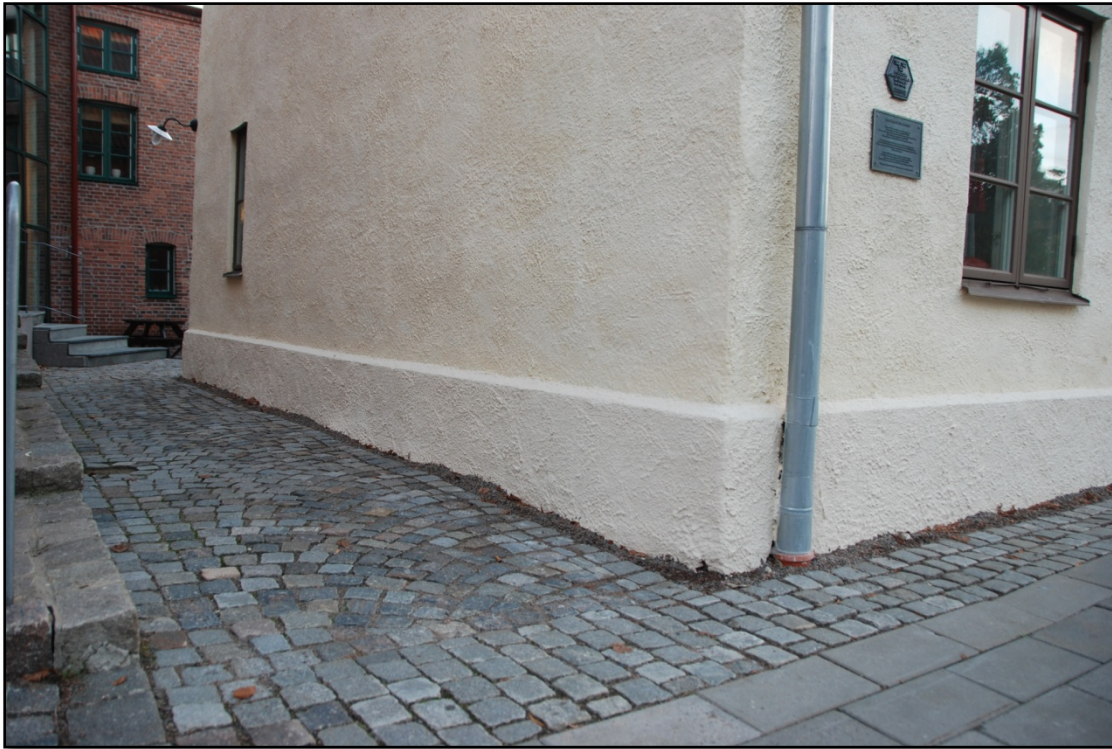
Norra gavelfasaden och del av västfasaden färdig. Markytan återställd.
