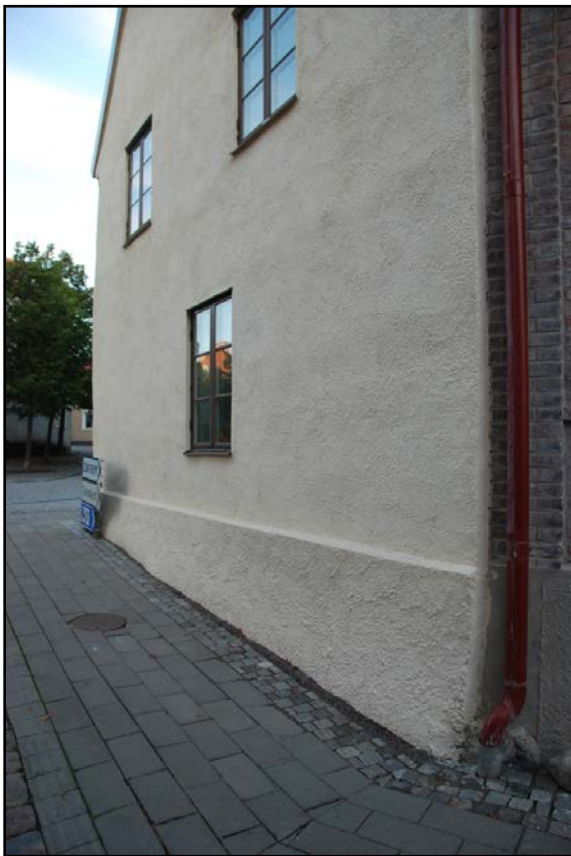
Södra gavelfasaden färdig.
