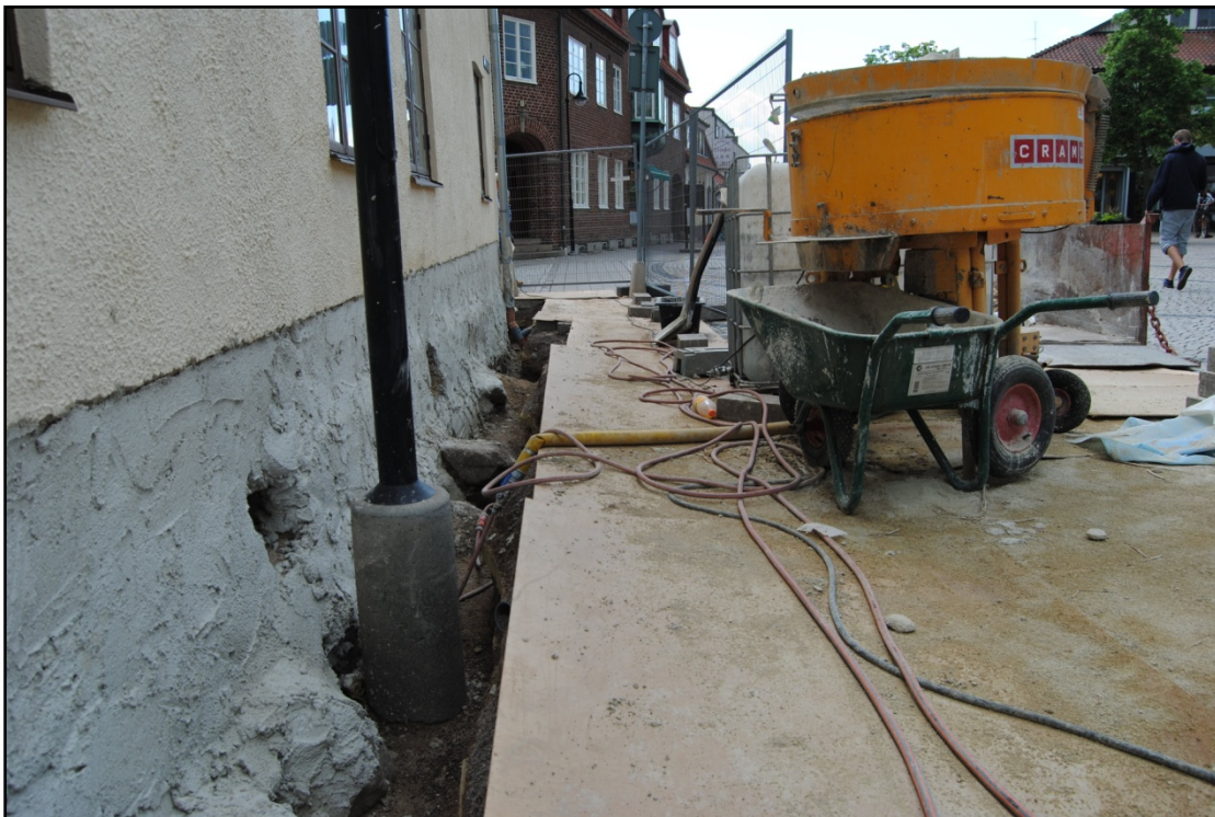
Del av fasaden längs Östertullsgatan.
