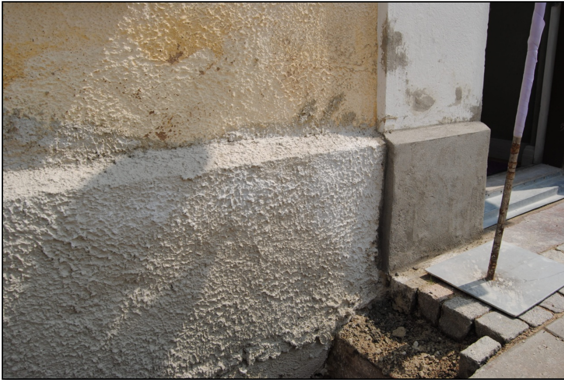
Nederdelen av dörromfattningen gjordes också om och slätputsades.
