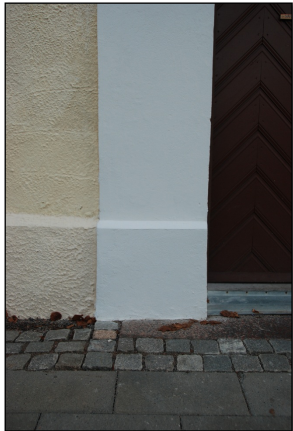
Dörromfattningen putsad och målad.
