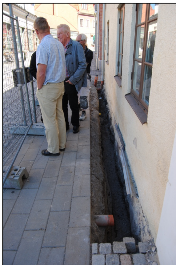
Norra delen av västra fasaden.
