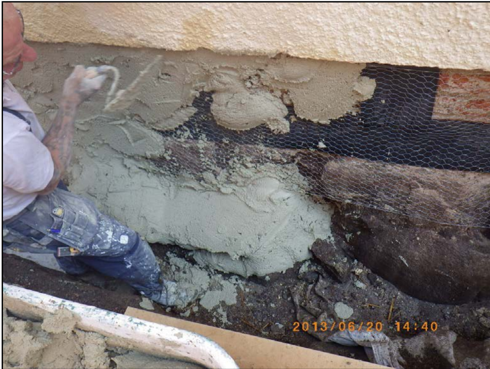
Första utstockningslagret på norra gavelfasaden (foto Bröderna Bergström AB).
