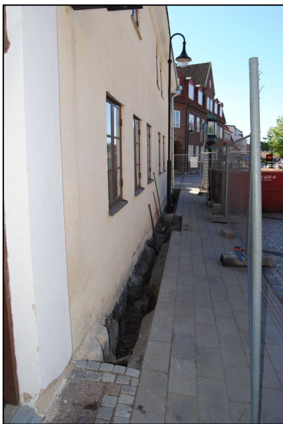
Schaktning påbörjad, södra delen av västra fasaden.
