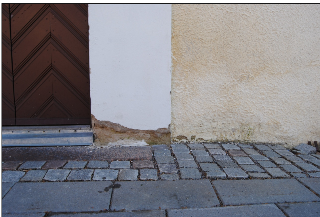
Ovan: Skador och påväxt mot mark på putsen på norra gaveln. Nedan: Skada västra fasaden vid port.
