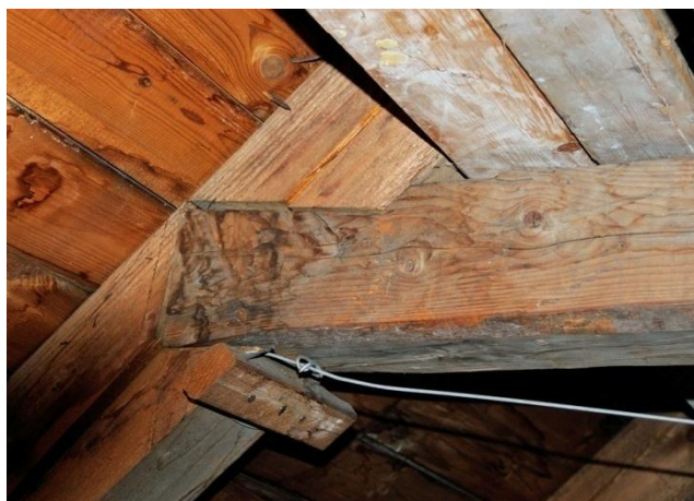
Detalj av takstol på Rudan 3. Bladning med halv laxstjärt.
