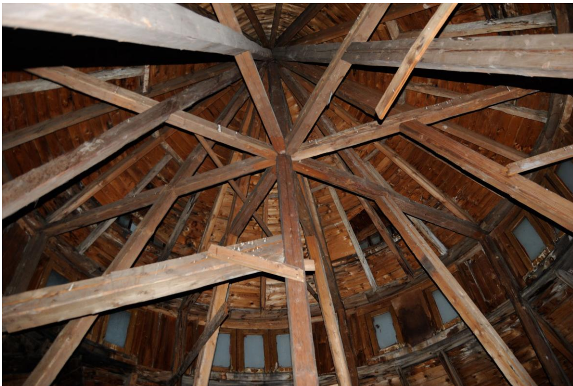
Den bärande stommen i kupolkonstruktionen är ett intrikat system, helt i trä.
