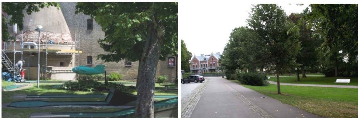
T.v. Hamnmagasinen bildar en tydlig gräns mot norr. T.h. mot Sjöallén saknas inhägnad.
