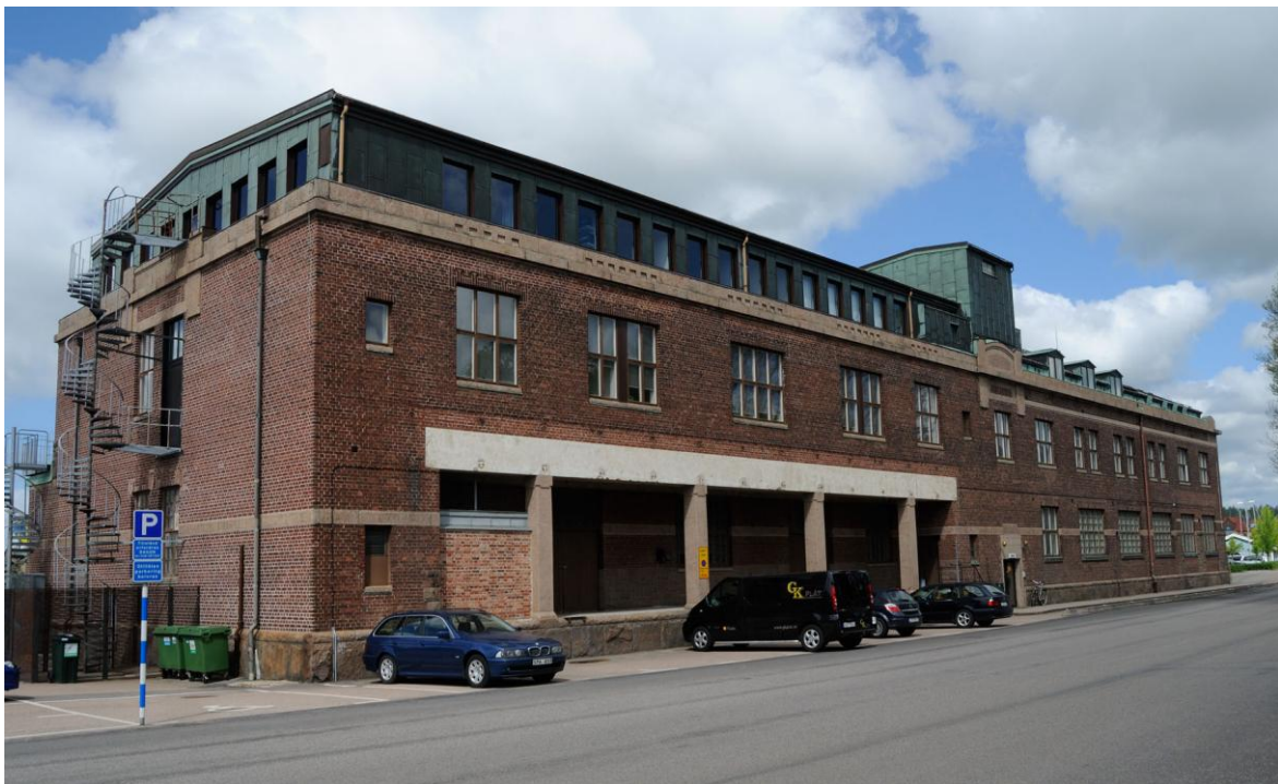
Västra fasaden. I södra delen har det påbyggda takpartiet delvis förändrat byggandens karaktär. Kopparplåten sammanlänkar i viss mån byggnadens olika takutformningar. Den indragna plattformen med sina granitkolonner och toärgående betongbalk ger här särskild karaktär åt byggnaden.
