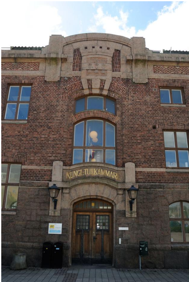
Entrén mot norr.
