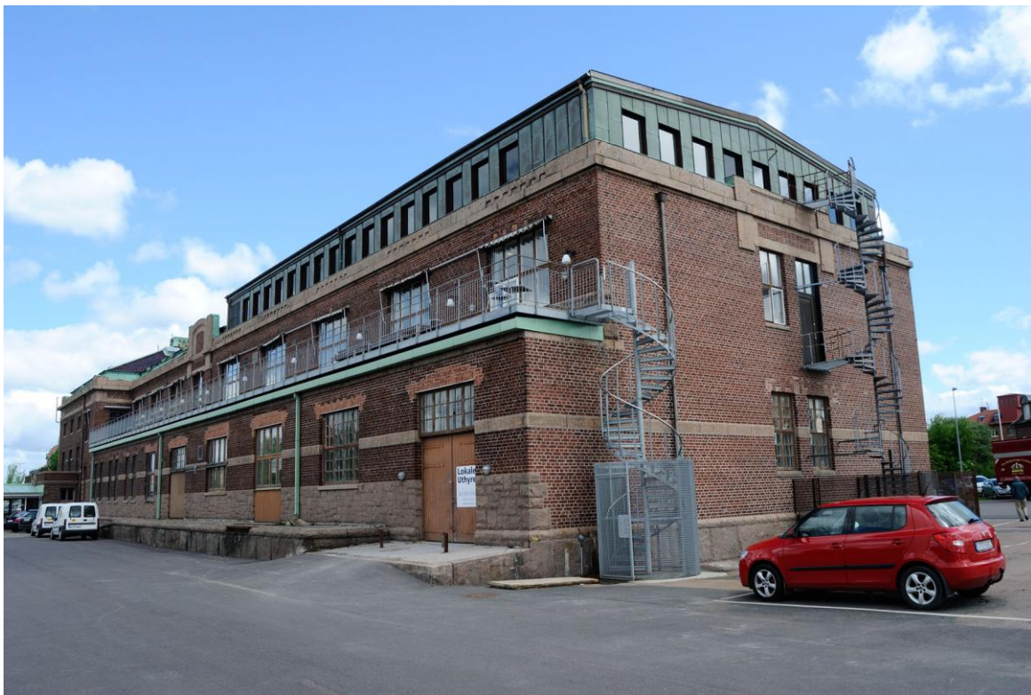
Södra och västra fasaden. Den lägre utskjutande delens tak var liksom hela södra delens tak ursprungligen plattformar varifrån i och urlastning av gods som skulle förtullas skedde.
