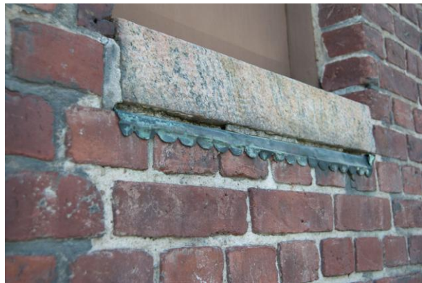
Detalj av fönster på östra fasaden. Sentida klumpiga plåtbeslag (t v) döljer fönsterbänken (solbänken) i granit och det ursprungliga nätta plåtblecket därunder (ovan).
