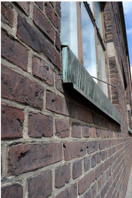
Detalj av fönster på östra fasaden. Sentida klumpiga plåtbeslag (t v) döljer fönsterbänken (solbänken) i granit och det ursprungliga nätta plåtblecket därunder (ovan).
