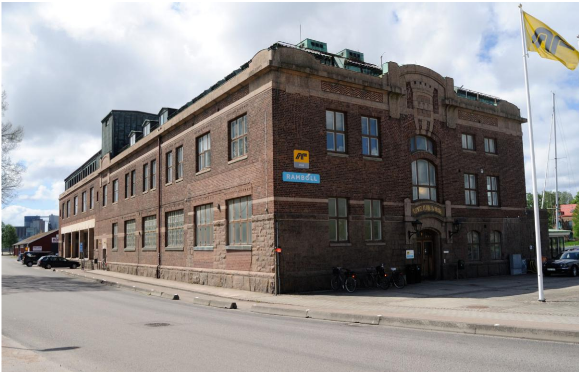
Vy från nordost. Notera bl a hur taket i norra delen till stora delar döljs av den kraftiga taklisten.
