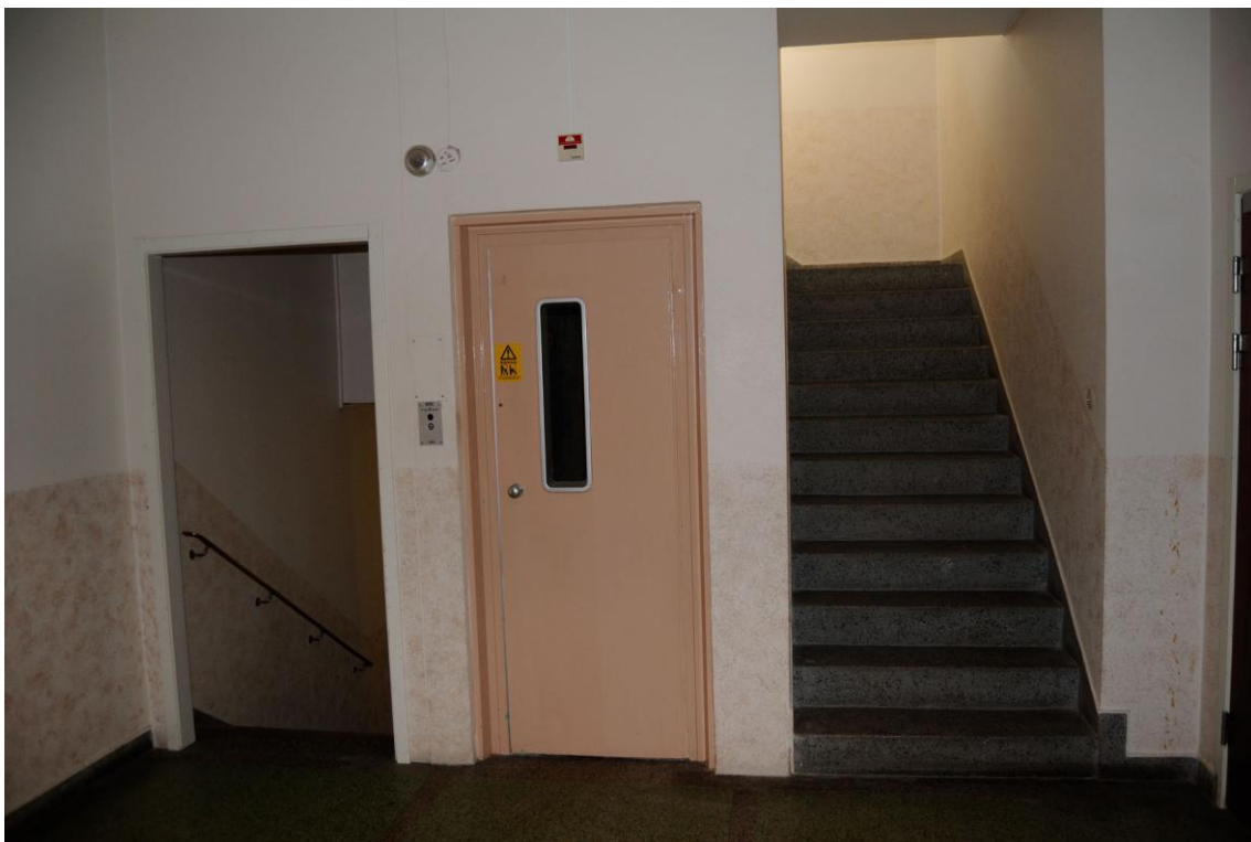
Det på 1950-talet ombyggda östra trapphuset.
