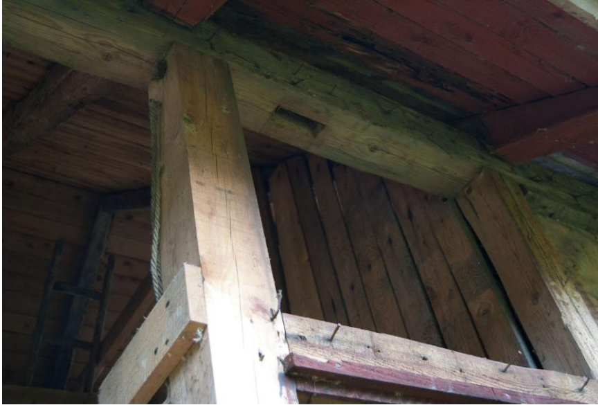
Håltagning i remstycke som tyder på att begagnat virke användes vid uppförandet.
