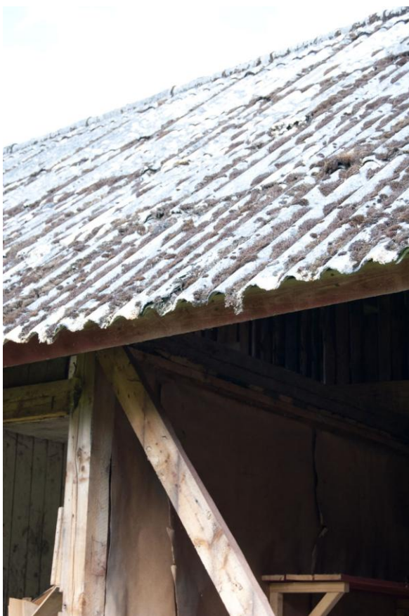
Yttertaket av korrugerad eternit är senare tillkommet. Ursprungligen var det troligen täckt av tjärpapp.
