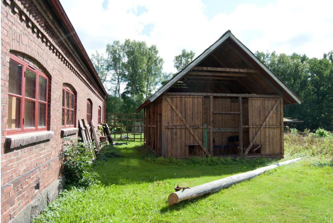
Byggnaden ligger endast ett par meter ifrån brandstationsbyggnaden.
