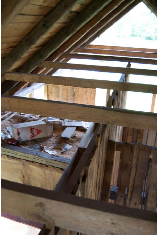
En enkel hjärtvägg avdelar byggnaden invändigt.
