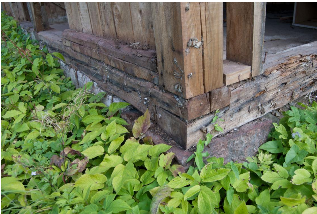
Hörnet på syllen med halot i halot-förbindning vilande på en släthuggen sten.
