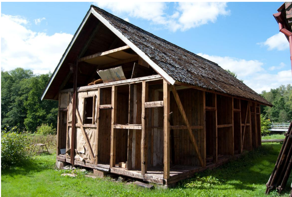
Vy från sydost. Väggspanelen var nedtagen vid besiktningstillfället.
