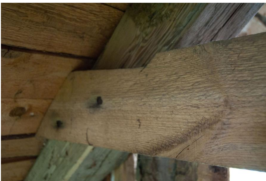
Hansbjälke infälld med laxhak mot taksparre.
