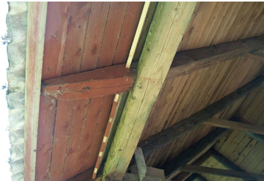
Taksparrar och takskägg. Sparren har ett hak för remstycket. Vid takskägget är den avfasad och rödmålad.
