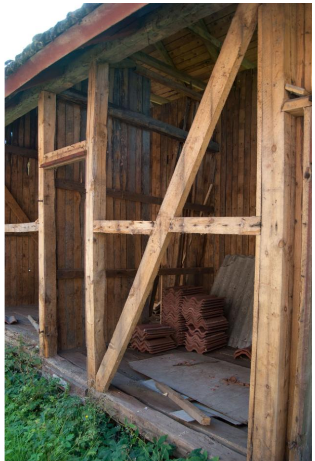
Den frilagda väggstommen av regler och stolpar påminner om korsvirke fast utan fyllningar i facken.
