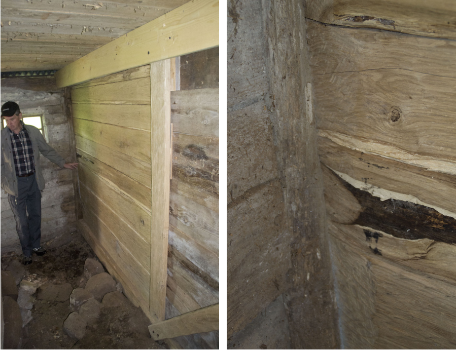
Den nybyggda delen av mellanväggen från stallsidan. Bålarerna är handhuggna för att passas in i gåten.
