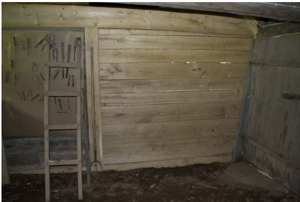
Mellanväggen i verkstaden är återskapad, byggd i skiftesverksteknik i ekvirke.
