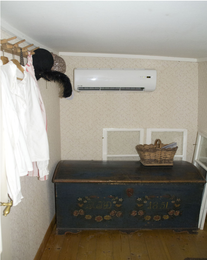
Tillägg till rapport 2012-27 Innerdelen till luftvärmepumpen är nu monterad i farstun i bostadsdelen.
