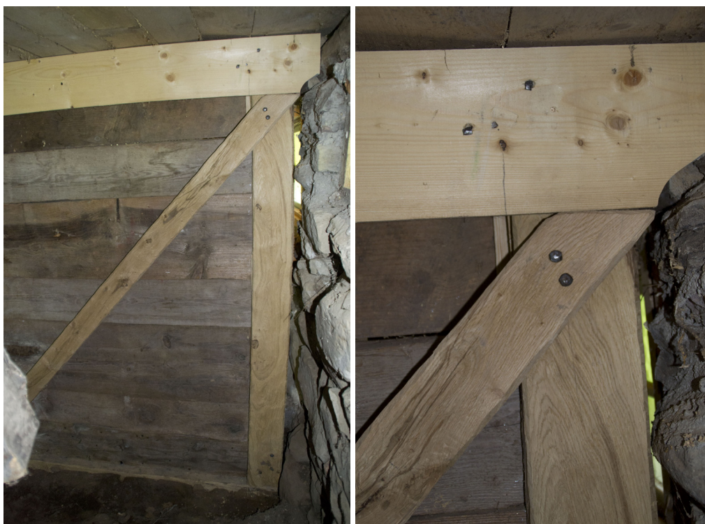
En ny ständare fick tillverkas och monteras även vid den bakre ytterväggen, i den äldre bevarade delen av mellanväggen. En snedstötta stadgar upp den äldre delen av väggen på stallsidan. Stöttan är fäst med handsmidd spik. Virket har handbilats för att smälta in i den ålderdomliga miljön
