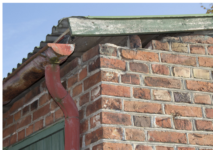
Nedan: Huset har ett enkelt brädtak täckt med korrugerad plåt.
