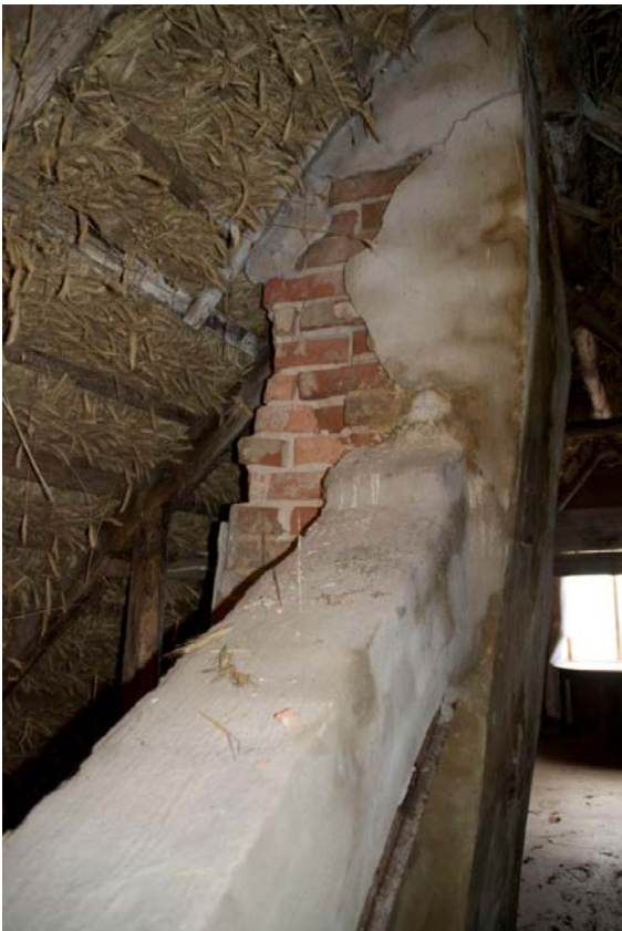
Skorstensstockens puts vittrade liksom tegelstenen. Även taknocken och anslutande takstolsdelar var fuktskadade pga inträngande regn.
