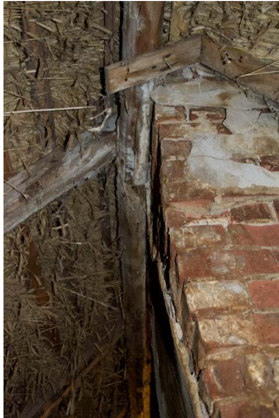
Skorstensstockens puts vittrade liksom tegelstenen. Även taknocken och anslutande takstolsdelar var fuktskadade pga inträngande regn.
