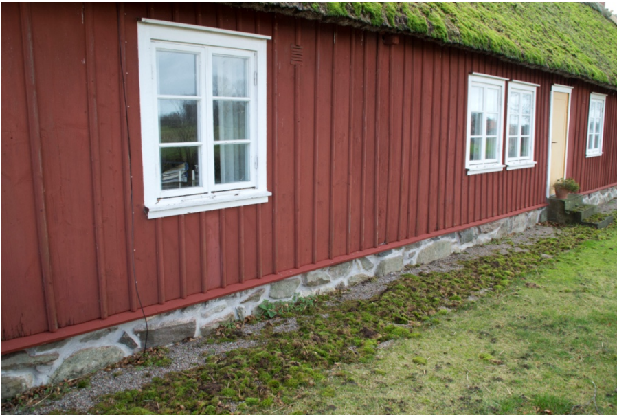
Dropplist i panelens nederkant på bostadshusets norra sida.
