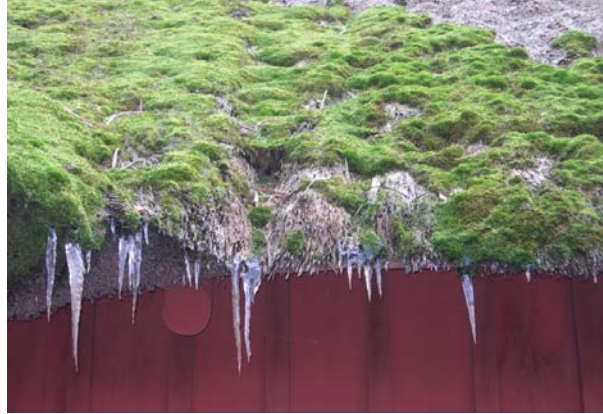
Halmtaket innan omläggning. Halmen var mossbeväxt och höll mycket fukt.
