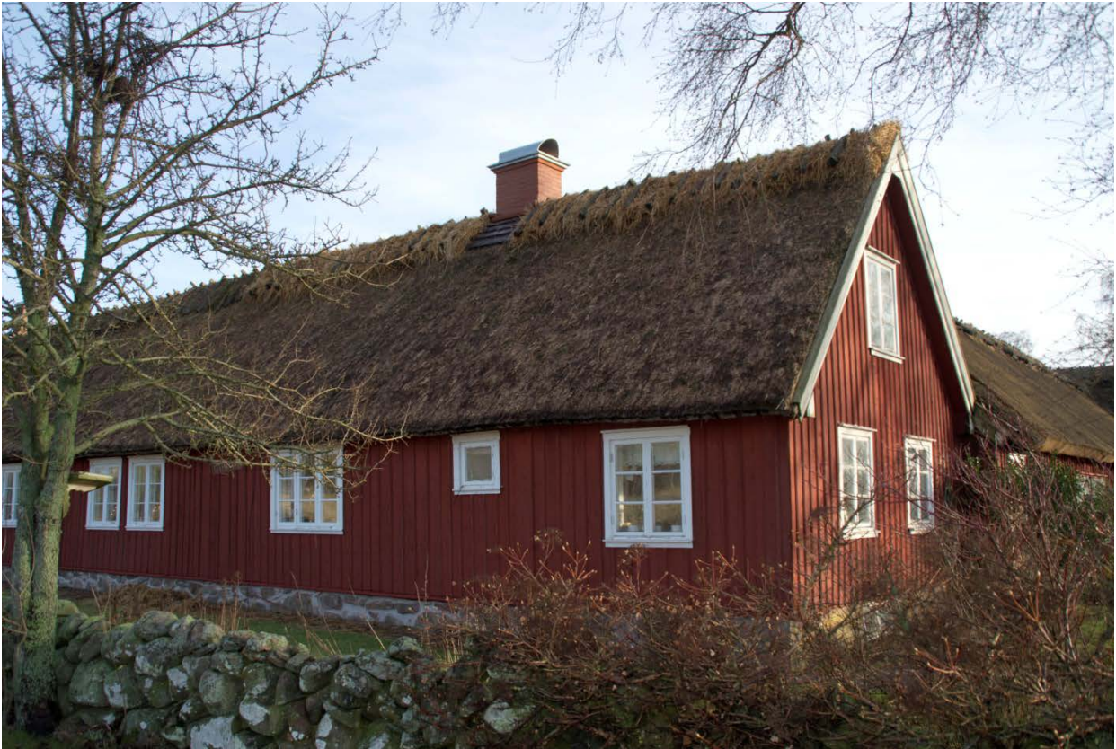
Skorstenen sedd från utsidan av gården.
