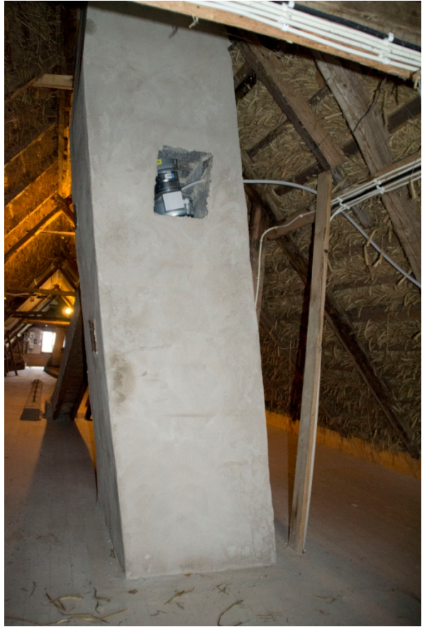
Skorstenstocken på vinden. Galten från spisen i stugan är återansluten, de små ventilluckorna i gjutjärn är återinmurade och en ny pump är installerad. Öppningen till pumpen ska förses med någon typ av lucka.
