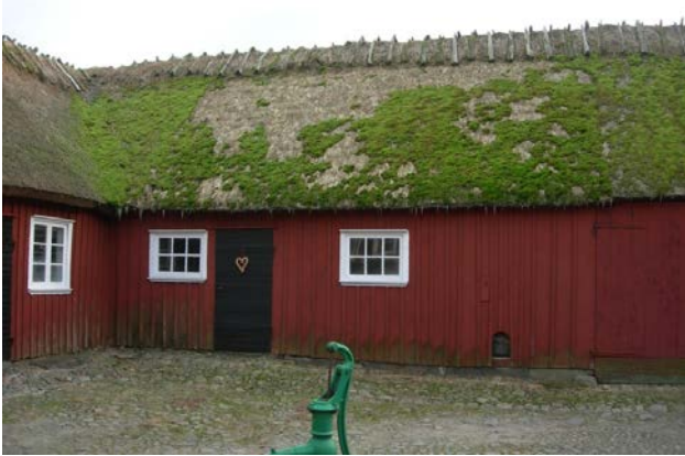
Halmtaket innan omläggning. Halmen var mossbeväxt och höll mycket fukt.
