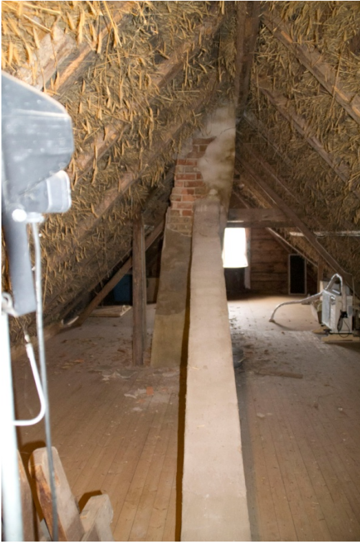
Galten från kakelugnen i stugan anslöt till murstocken på vinden.
