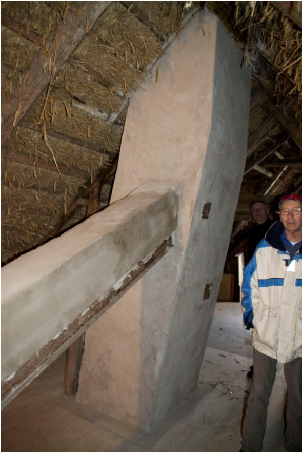
Skorstenstocken på vinden. Galten från spisen i stugan är återansluten, de små ventilluckorna i gjutjärn är återinmurade och en ny pump är installerad. Öppningen till pumpen ska förses med någon typ av lucka.
