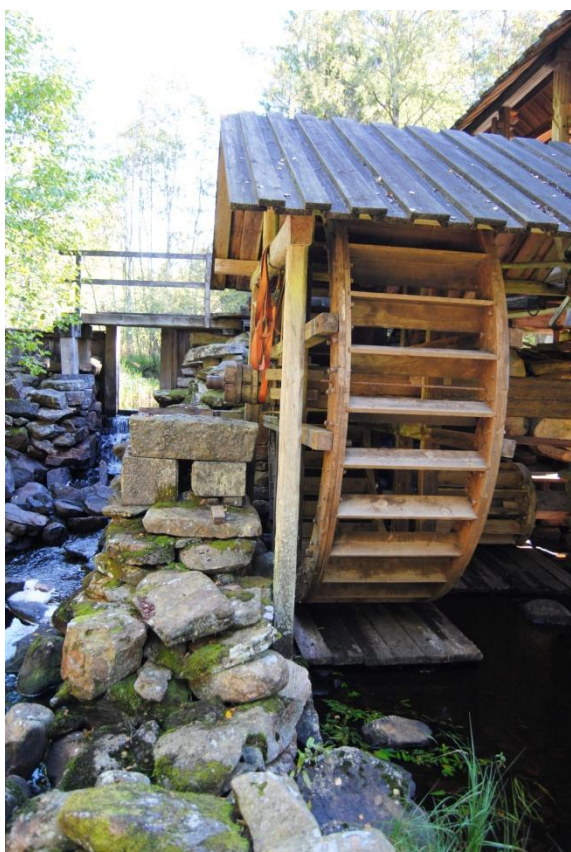
Det stora vattenhjulet under renoveringen.
