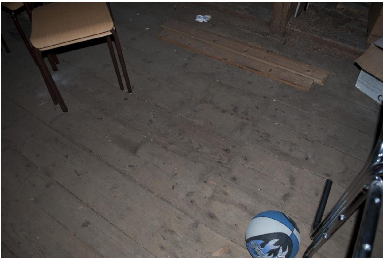
Golvet är täckt med breda plank sammanfogade med handsmidd spik.
