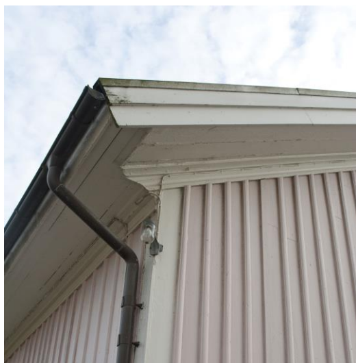
Längs takfoten finns ännu profilerade lister. Här syns också att taket någon gång förstörats med några decimeter.
