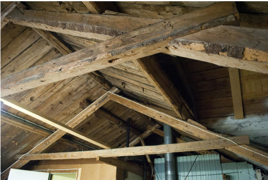
Taket över den äldsta byggnadsdelen är ett åstak med en längsgående takbjälke som vilar på gavelröstenas högsta spets.
