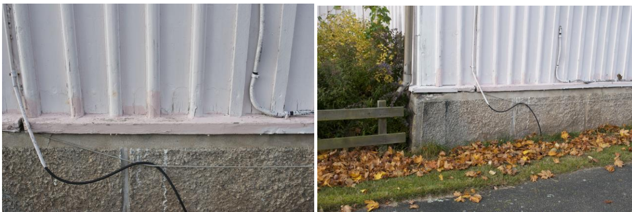
Den äldre panelen består av en relativt kraftig profilerad locklistpanel. Den har senare bytts ut mot smalare i oprofilerad locklist, vilket syns till höger på den vänstra bilden. Stengrunden har putsats för att efterlikna en huggen kvaderstensgrund.
