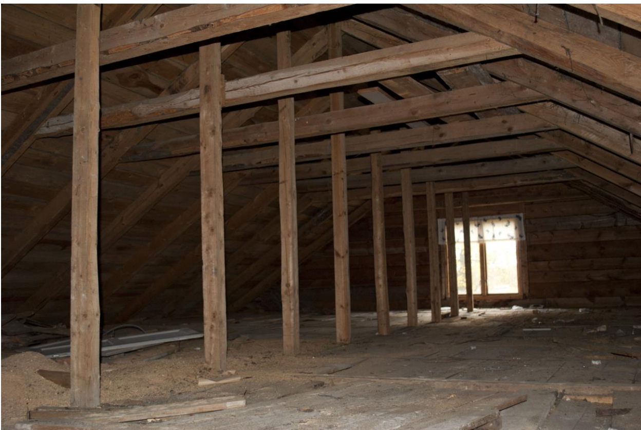
Den yngre delen har en takstolskonstruktion.
