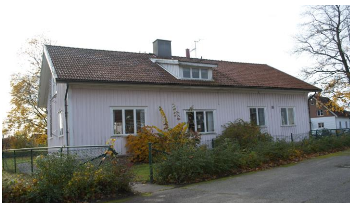
Längs takfoten finns ännu profilerade lister. Här syns också att taket någon gång förstörats med några decimeter.
