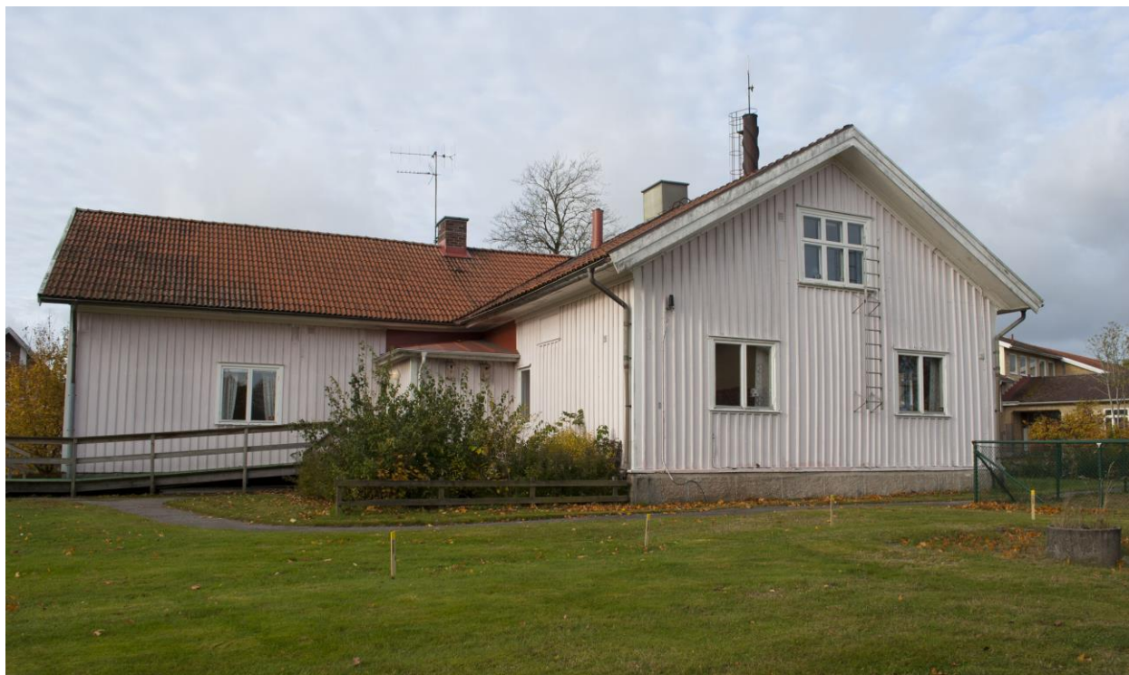
Byggnaden från öster. Utbyggnaden i vinkeln var en gång en glasveranda. Sadeltaket är täckt med rött lertegel. Skorstenen på den södra delen är av tegel med den andra är plåtinklädd.
