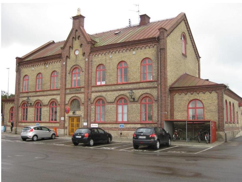
Tullhuset före den senaste fasadrenoveringen. Tullver- kets skylt sitter kvar vid en- trén. Foto Byggnadsinven- teringen 2009.
