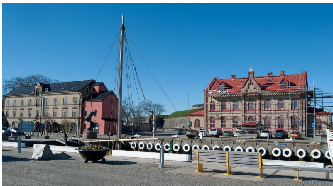
Vy från nordost med hamnbassängen närmast och Börjessonska magasinet t v. I bakgrunden skymtar fästningen på höjden. April 2017
