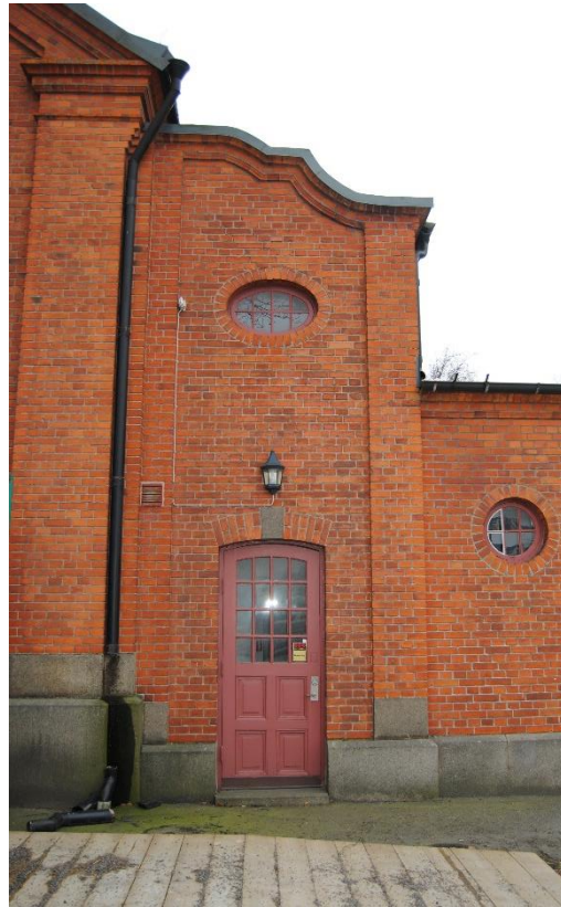
Entré till trapphuset. Ovanför entrén sitter ett ovalt oxöga och takfoten ansluter till entrépartiernas form.
