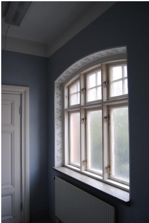
Del av interiör, omklädningsrum. I fönsternischen syns målade växtornament.
