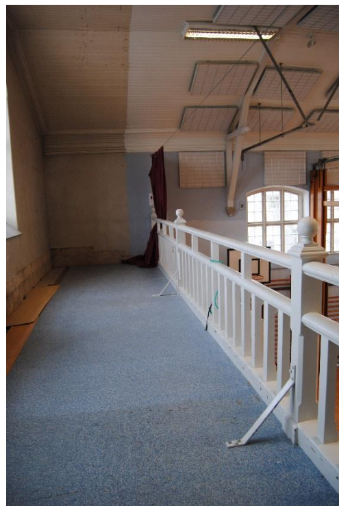
Läktaren med vitmålat räcke. Längst bort syns en av takets konsoler.
