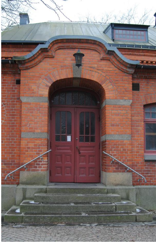
Entréernas organiskt formade överstycken har drag av jugend. Byggnadens ursprungliga pardörrar är bevarade och i gott skick.
