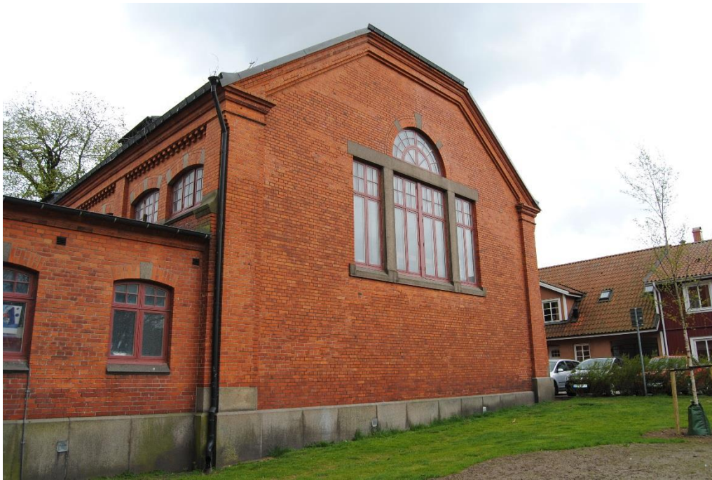
Gymnastiksalens västra gavel. Notera takfotens dekorativa fris.
