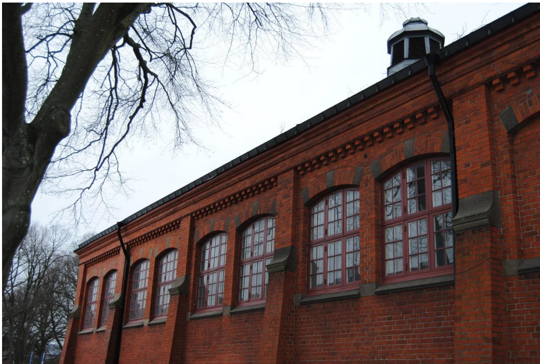
Södra fasadens småspröjsade fönster. Här syns även strävpelarna samt tandsnittsfrisen och takfotens dekorativa profil.
