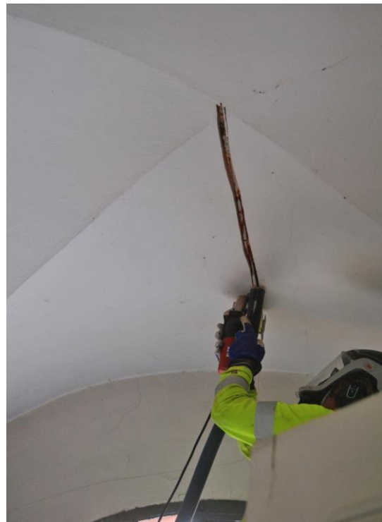
Ovan och t v: Puts fräses ur för elkabel i tak och vägg vid entrédörr och spåret putsas igen.
