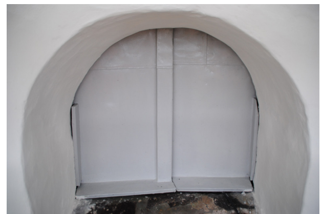
Ljudluckorna har rengjorts från löst sittande färg, slipats och målats om med linoljefärg i ljusgrå kulör från Ottossons färgmakeri AB. Ljudluckan på södra sidan, fotografiet upp till höger, har nyttilverkats.
