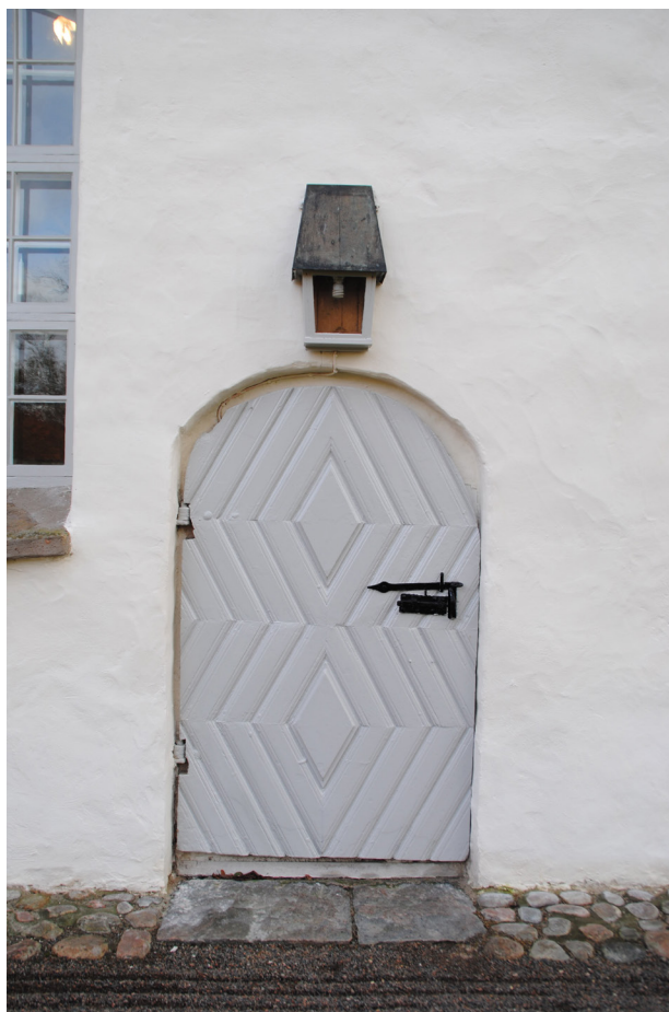
Kordörren på norra sidan efter ommålning med ljusgrå linoljafärg från Ottossons färgmakeri AB.
