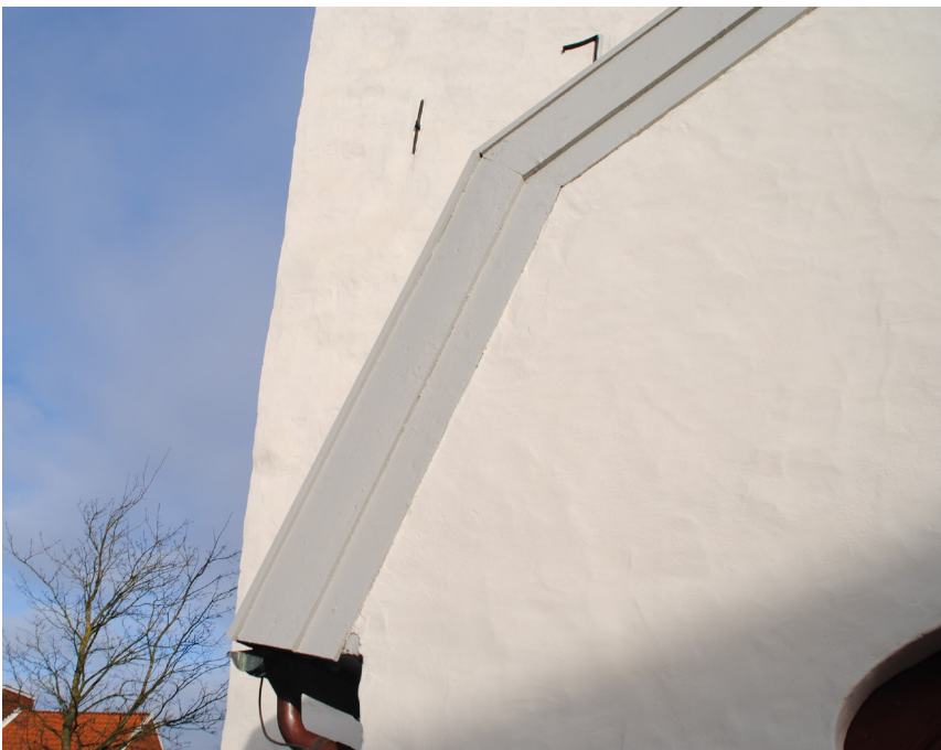
Vindskivan på vapenhuset har rengjorts från löst sittande färg och målats om med ljusgrå linoljefärg från Ottossons färgmakeri AB.
