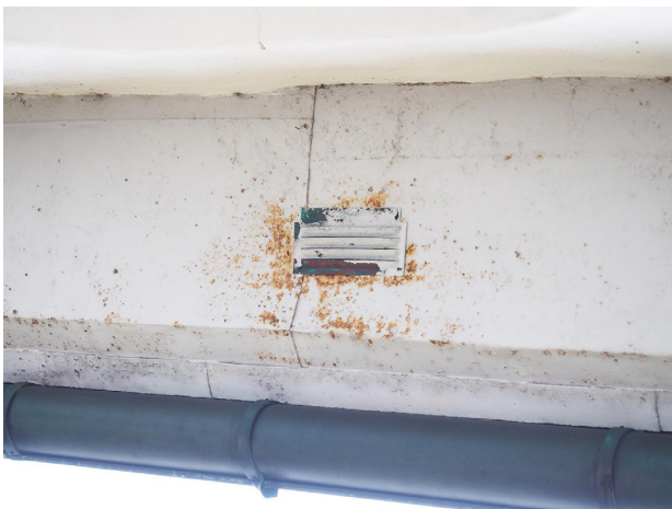
Järnplåten som klär in underslaget i takfoten på långhuset var målade i en grå kulör liknande den på fönstren.
