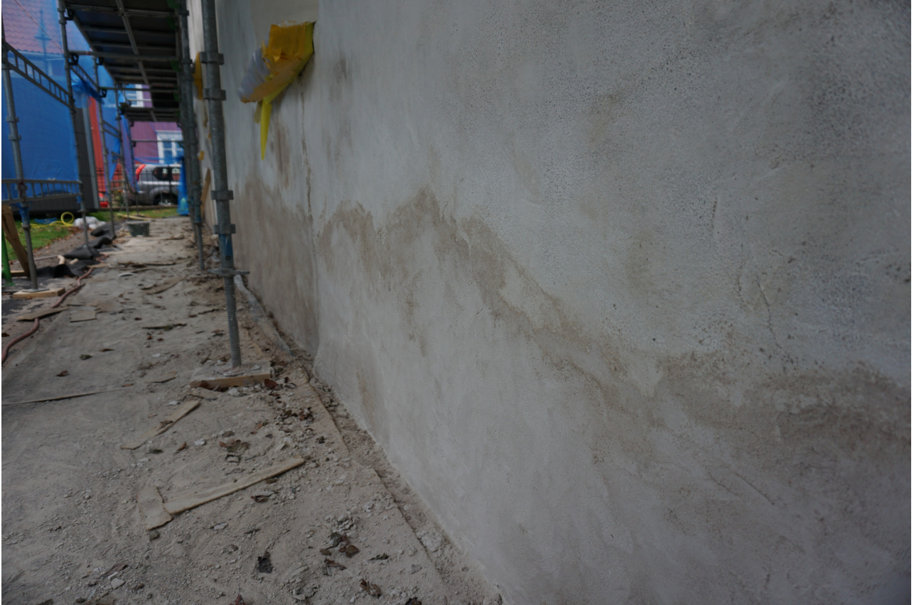
Ovan. Fasaden på norra sidan håller på att putsas om nedtill med hydrauliskt kalkbruk från STO AB.
