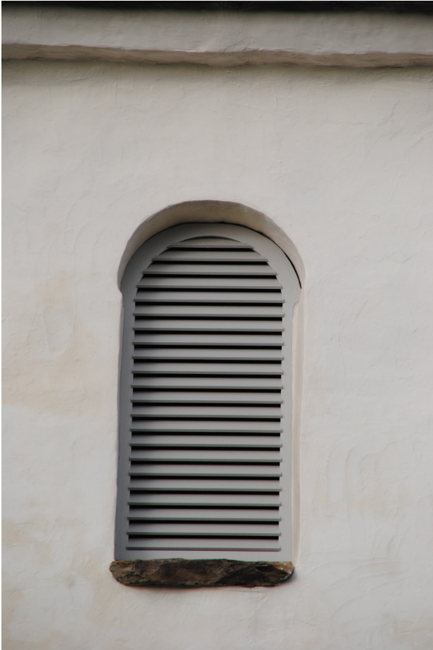
Ljudluckorna har rengjorts från löst sittande färg, slipats och målats om med linoljefärg i ljusgrå kulör från Ottossons färgmakeri AB. Ljudluckan på södra sidan, fotografiet upp till höger, har nyttilverkats.
