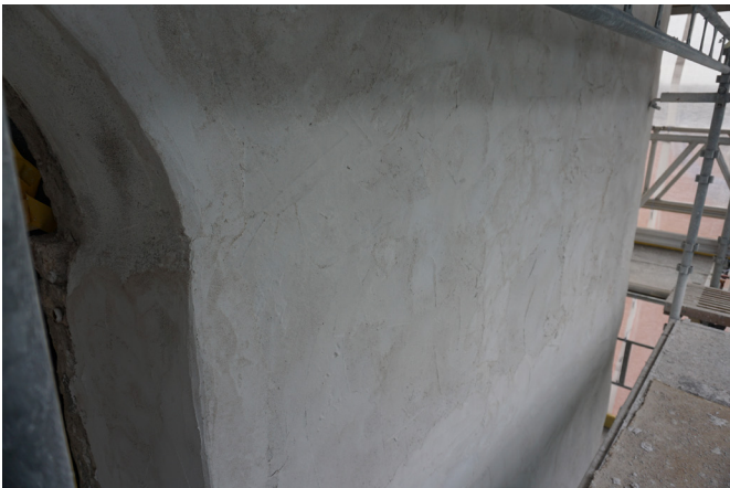
Ovan. Fasaden på norra sidan håller på att putsas om nedtill med hydrauliskt kalkbruk från STO AB.
