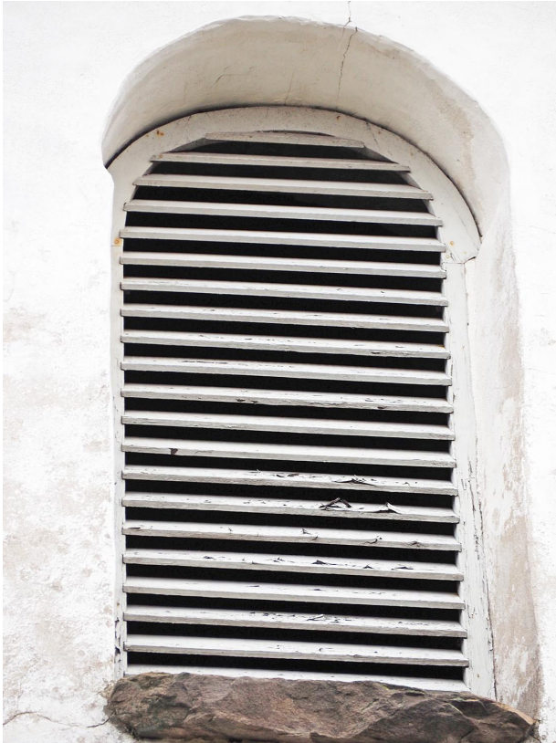
Ljudluckorna var i behov av ommålning och ljudluckan på södra sidan var i så dåligt skick att den behövde nyttillverkas.
