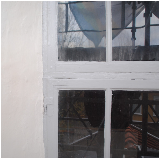
På fönstren finns en del äldre hörngångjärn som rengjorts från rost, mönjats och målats med linoljafärg.
