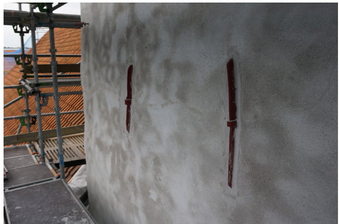
Till vänster. Putsen på kyrkan är slevdragen. På tornet blev ytan från början lite för grov jämfört med putsen på övriga kyrkan, men justerades sedan till en lite slätare struktur. Den nya putsen har fortfarande lite skarpare slevdrag än den gamla som är rengjord och ommålad ett antal gånger sedan den var nyputsad.
