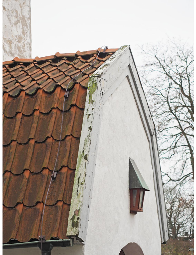
Vindskivan på vapenhuset var i behov av ommålning.
