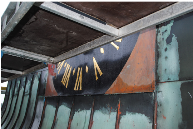
Ovan. Urtavla efter att siffrorna monterats bort.
