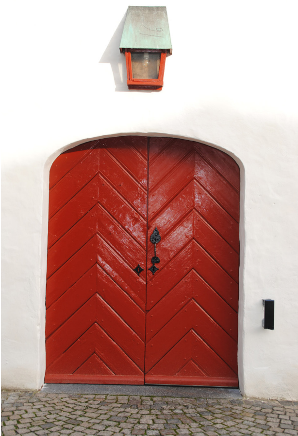
Entrédörren i väster efter ommålning med engelskt röd linoljafärg från Engwall o, Claesson AB.
