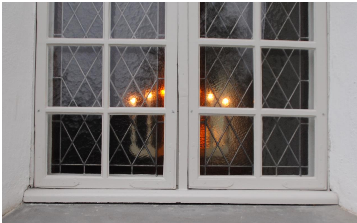
Fönstren har hörnbeslag i järn som har rengjorts och målats.
