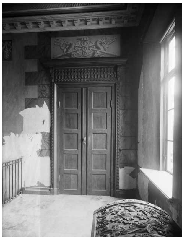
Väggpartiet i övre trapphallen före dess borttagning. Foto: Malmgren 1937, Nordiska museet
