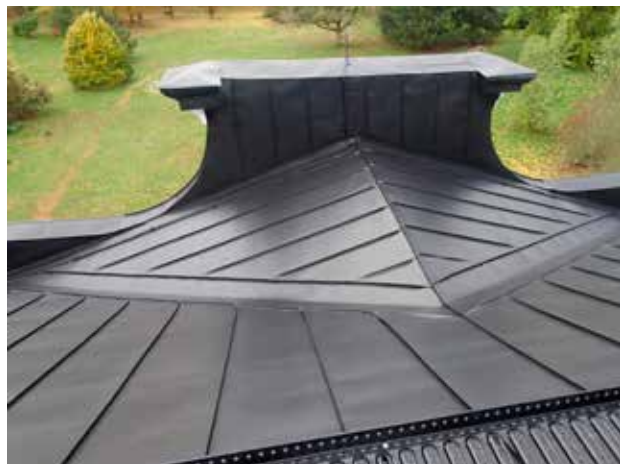
Ovan: Plåtlagningar vid tornets takfot. Nedan: Takfall mot skärmfasaden mot parken.
