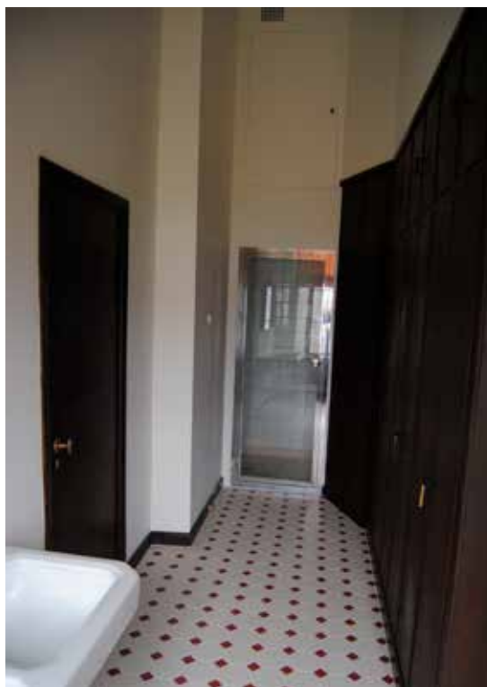
Dressingroom på plan 2, före respektive efter renovering. Rummet skapades i samband med ombyggnaden 1938.
