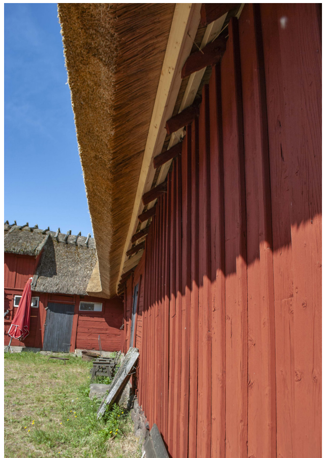
Ovan: Hörnet mellan norra och östra längan. Det är här tydligt hur mycket det befintliga taket sjunkit ihop. Till höger: Enstaka taksparrar har kompletterats.
