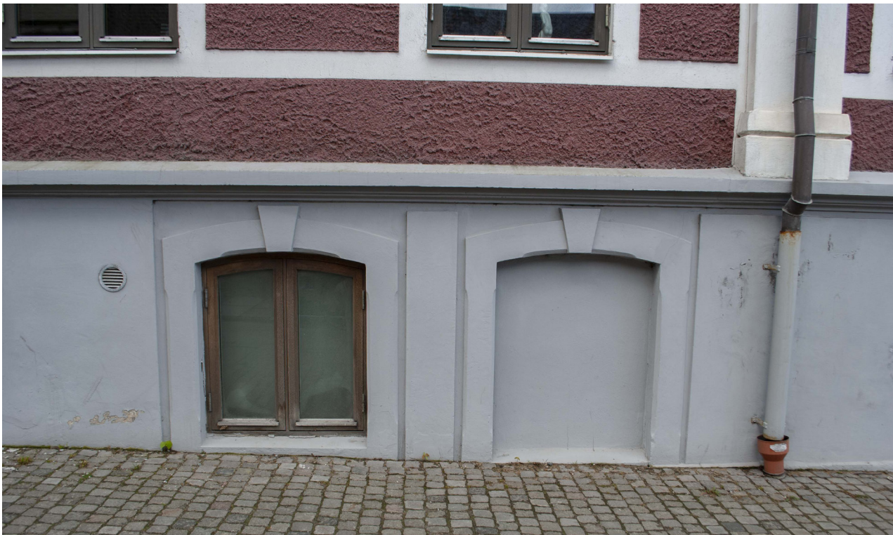
Källarfönster och blinderat källarfönster, här mot Norrgatan.
