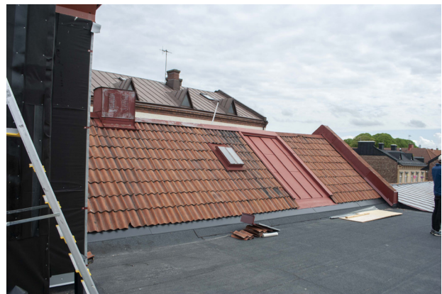
Längan mot Borgmästaregatan, trapphusets tälttak och det nedre takfallet på Torellska huset har rödmålat plåttak, medan de andra takfallen har tegeltak.
