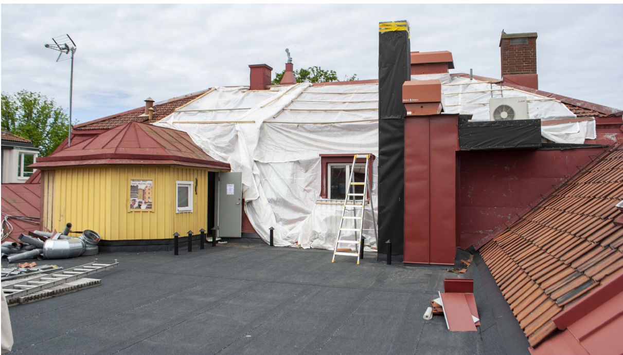
Hotell Gästis gård är nästan helt igenbyggd. Just nu pågår en takrenovering.
