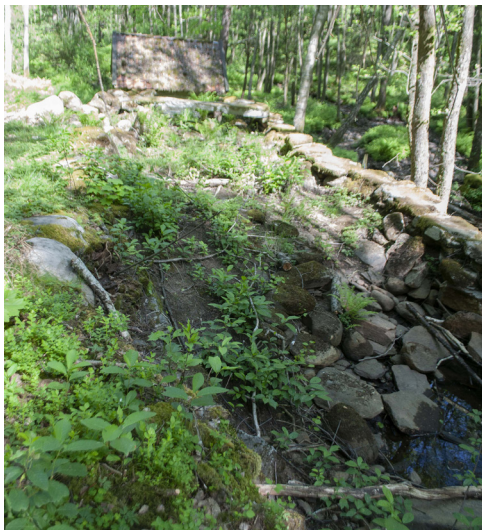
Stenkanalen är överväxt och något raserad, sedan länge.
