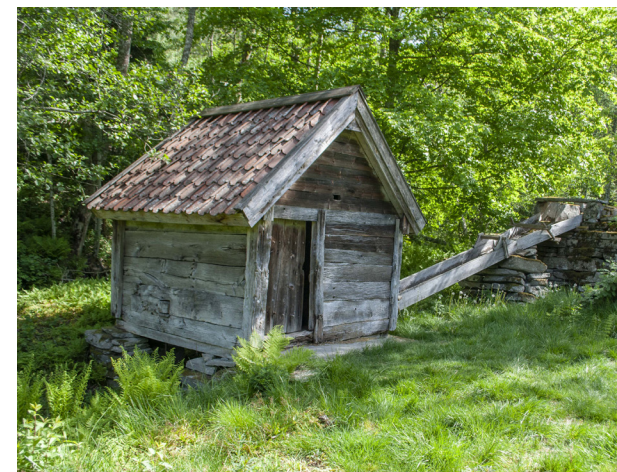
Kvarn 11 med träkanal och murverk.
