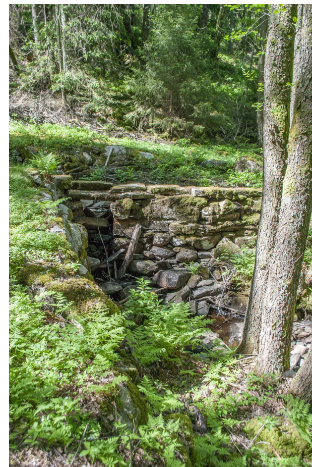
Mur till stenkanalen och dammlucka vid kvarn 9.
