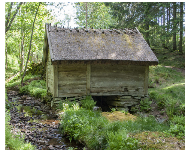
Kvarn 12 är den största kvarnbyggnaden och har stråtak.
