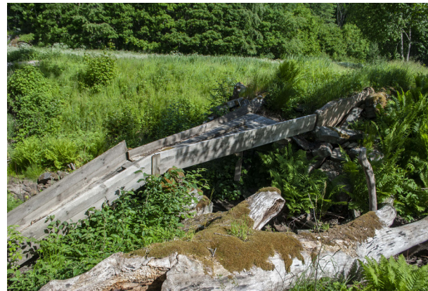
I en storm föll en stor del av en av askarna ned på trärännan och mureverket vid kvarn 15.
