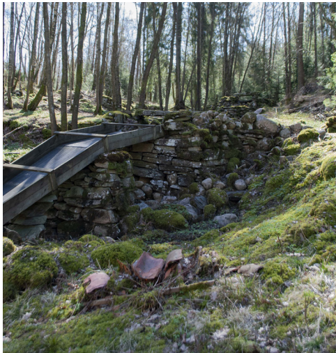
Murarna som bär upp trärännan är i bra skick.
