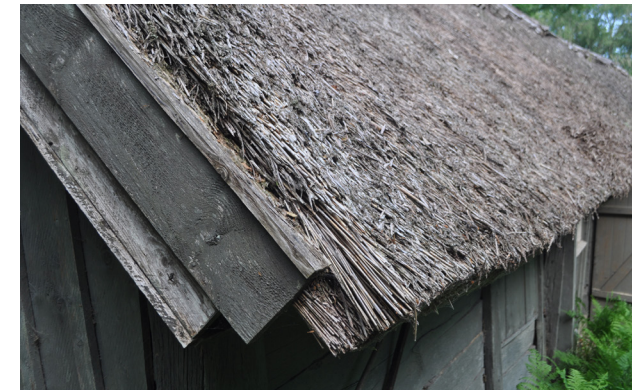
Överst: Takfoten bör täckas av nät från insidan. Nederst: Skorstenen är i behov av målning/kalkning och brädorna bör tjäras.
