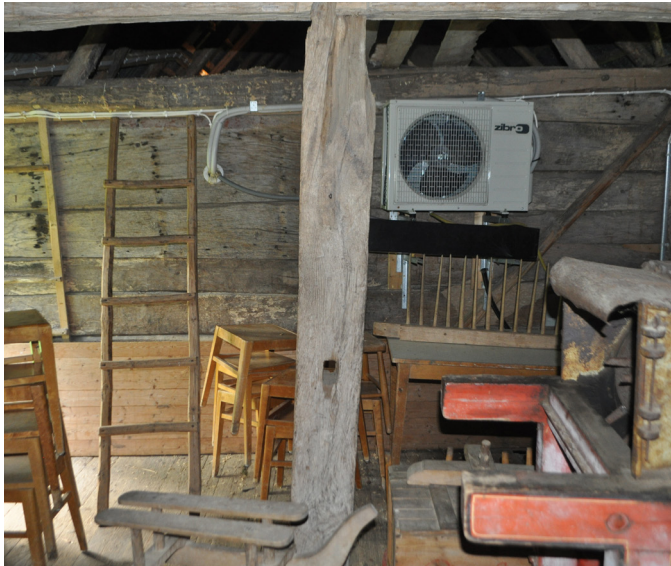
Logen. På skiftesverksväggen mot bostadsdelen syns luftvärmepumpen.
