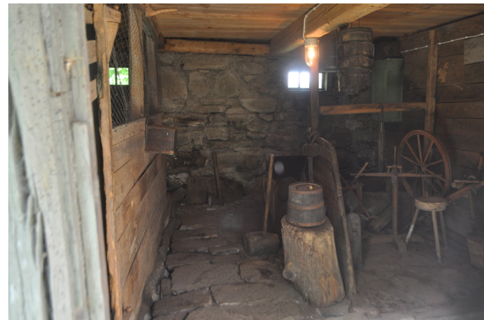
Snickeriet med hyvelbänk och verktyg. Mot golvet syns de klackar av betong som gjutits för att stabilisera väggen.
