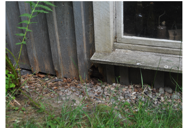
Nederst: På den södra gaveln ligger grus upp mot panelens ändträ. Intill fönsterbrädan syns rötskador.
