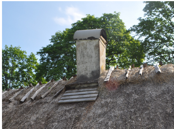
Överst: Takfoten bör täckas av nät från insidan. Nederst: Skorstenen är i behov av målning/kalkning och brädorna bör tjäras.
