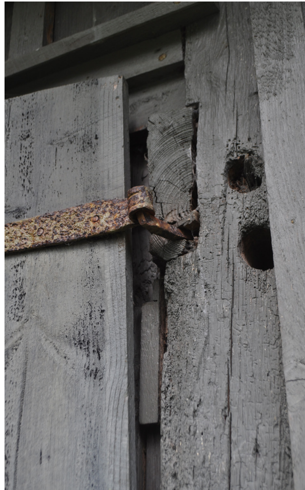
Gångjärnet till ladans högra portblad är fäst i ändträ och sitter löst.
