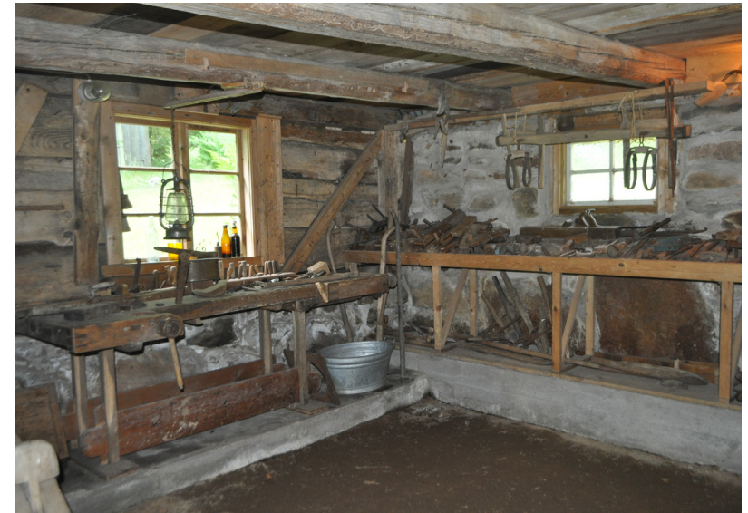
Snickeriet med hyvelbänk och verktyg. Mot golvet syns de klackar av betong som gjutits för att stabilisera väggen.
