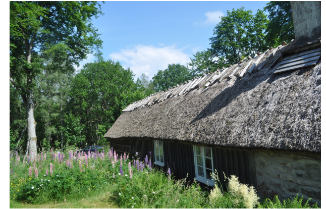
Taket är idag täckt med vass, ett taktäckningsmaterial som förekom där tillgången till detta var stor t.e.x nära vattendrag.
