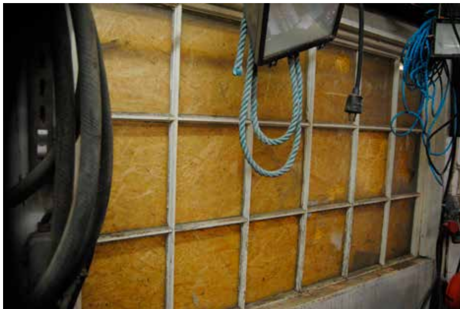
De stora spröjsade fönstren sitter kvar bakom träfiberskivorna.
