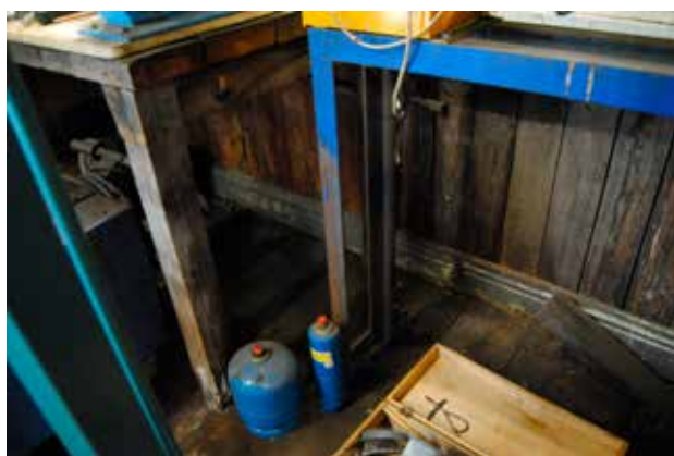
Profilerade golvlister i södra delen.
