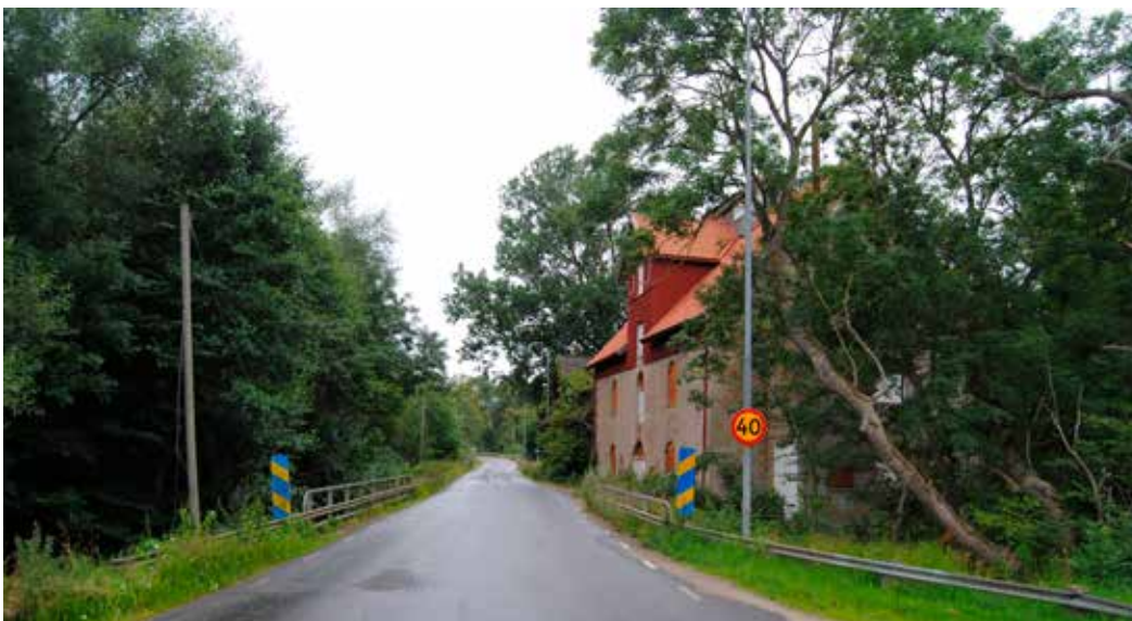
Vy mot väster. Kvarnbyggnaden närmast ligger på en ö med Himleån på båda sidor.
