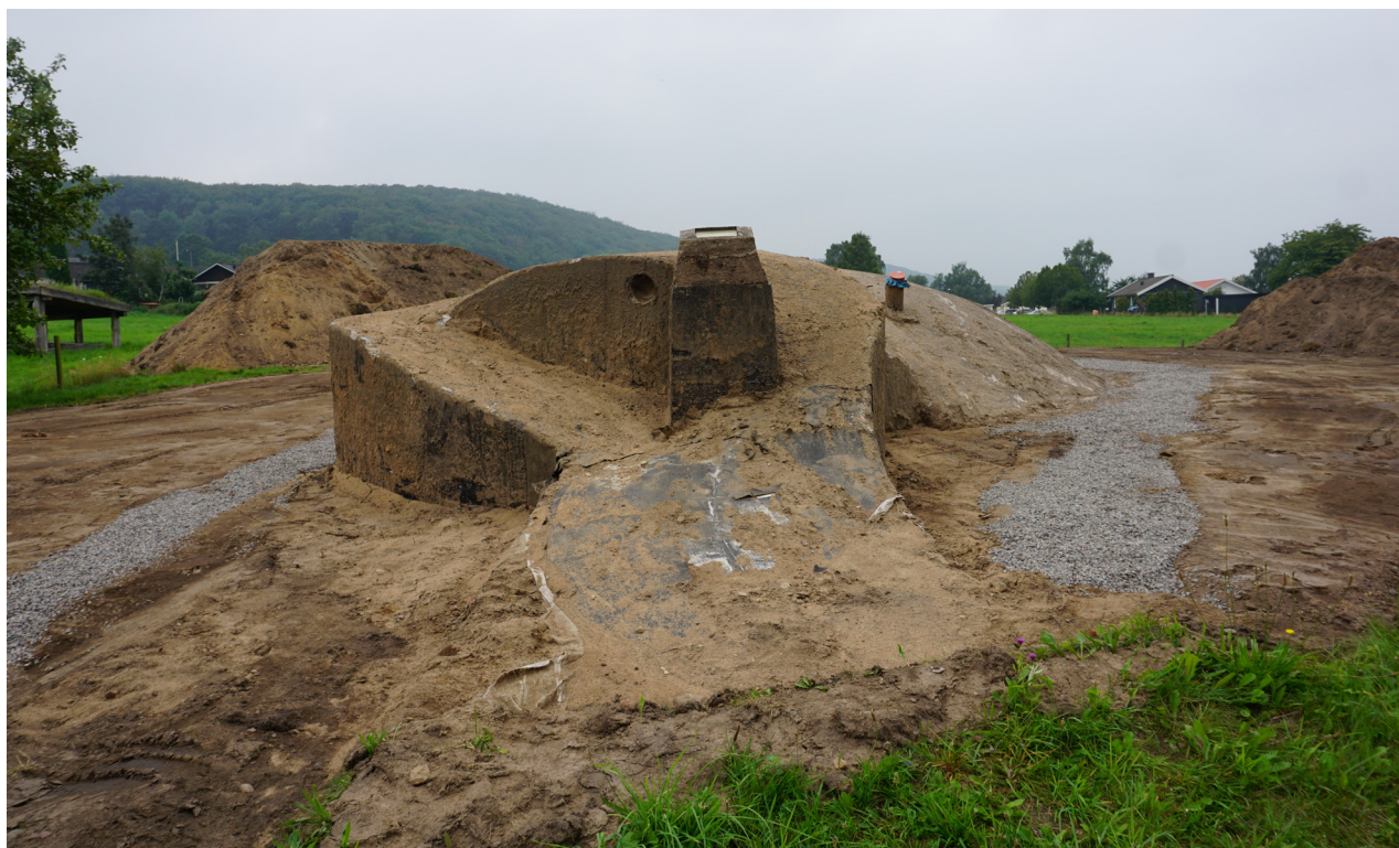
Högen har avtorvats så att betongkonstruktionen har kommit i dagen och dränering har grävts runt konstruktionen
