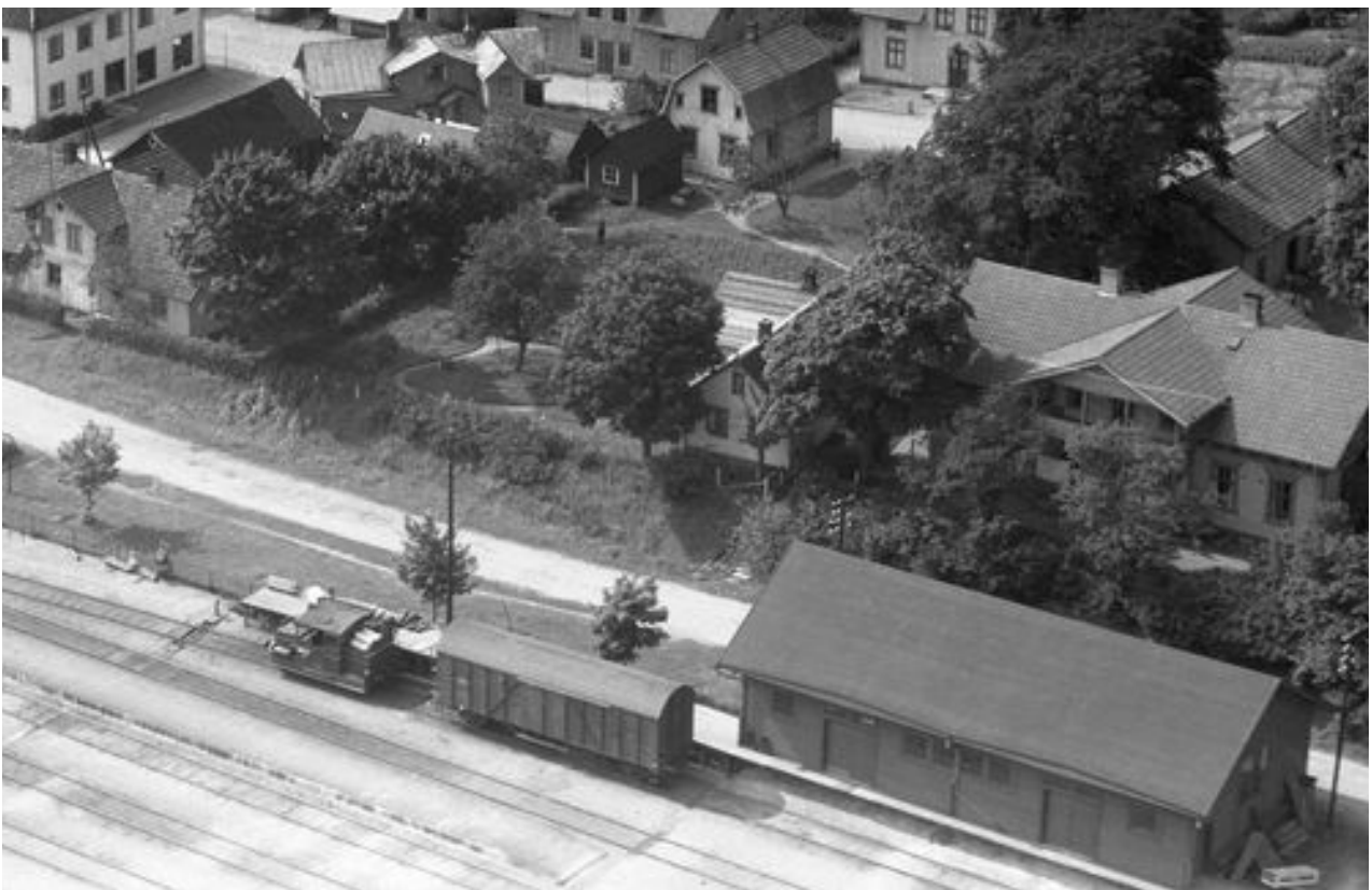
Godsmagasinet på äldre flygfoto. Här syns det slättäckta papptaket med fotränna i nederkant.
