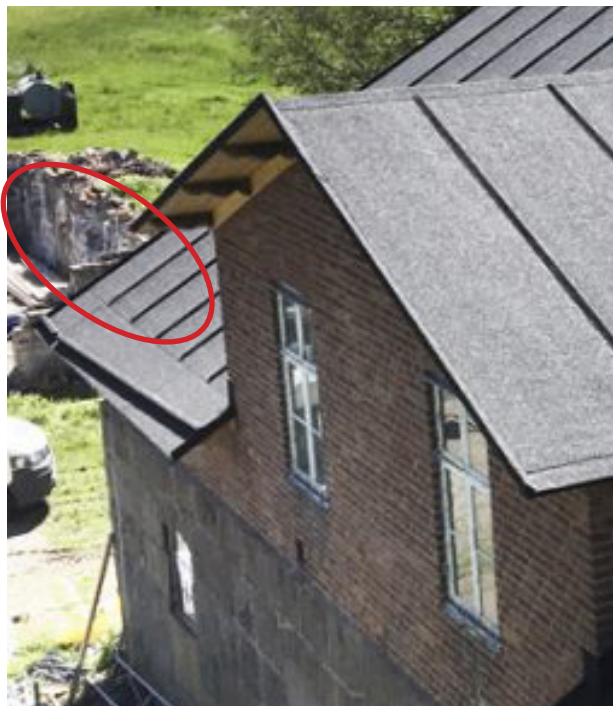
Exempel på ståndränna vid papptak, se röd markering.
