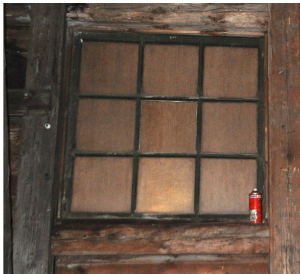
Fönsterbågarna är bevarade längs byggnadens långsidor.
