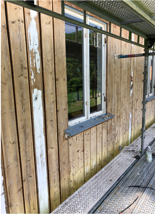
Panelen har skrapats ren från färg. I samband med fasadrenoveringen har även taket av enkupigt lertegel lagts om.
