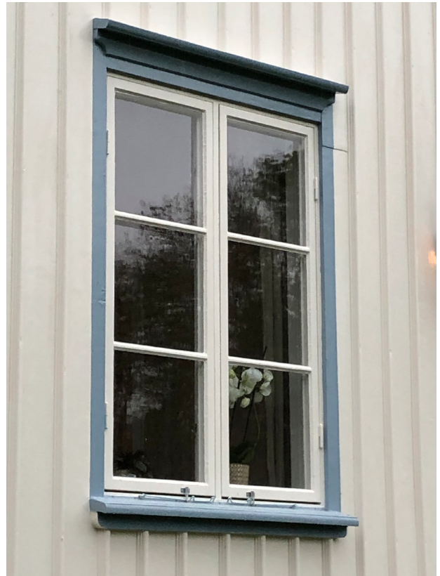
Fönster efter renovering. Notera den profilerade vattbrädan som frilagts från plåt.
