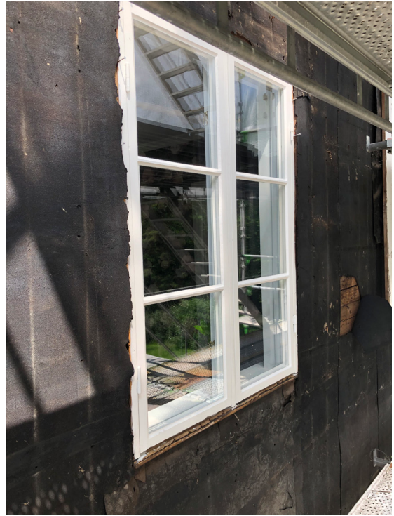
Här syns ett fönster som skrapats, kittats om och målats.
