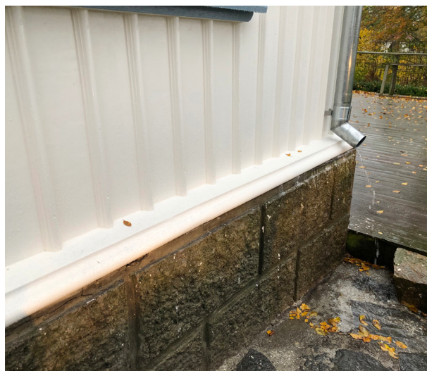
Ovan: Här har den profilerade vattbrädan lagats i med nytt virke i samma profil som originalet.
