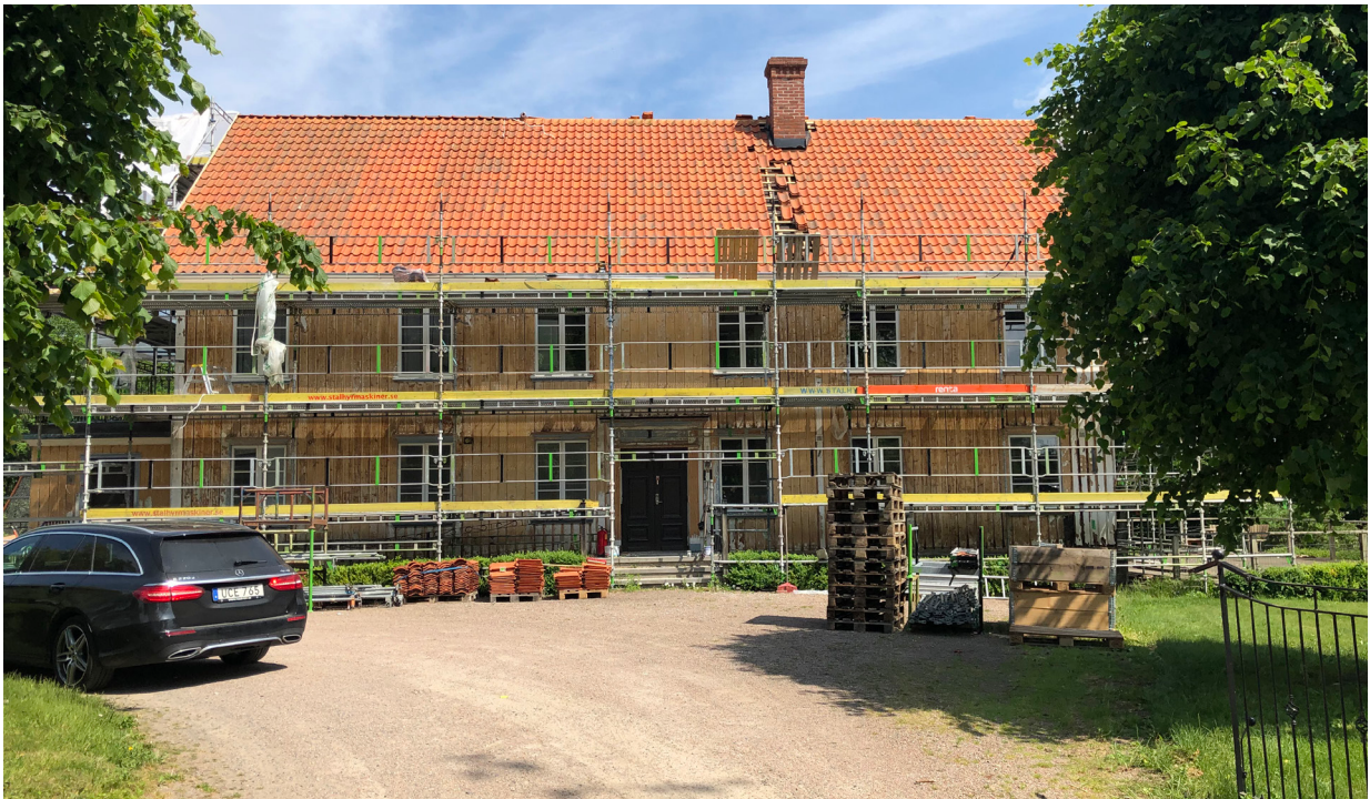
Panelen har skrapats ren från färg. I samband med fasadrenoveringen har även taket av enkupigt lertegel lagts om.
