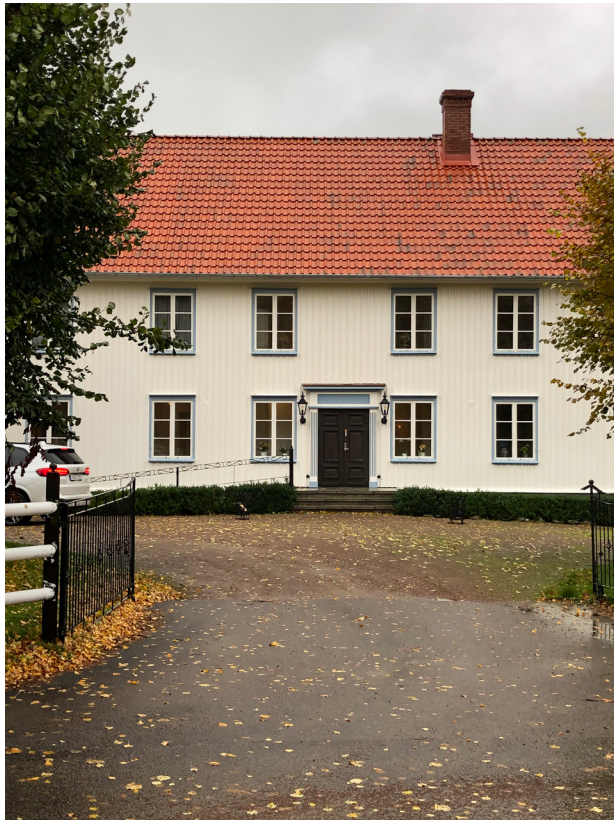
Västra fasaden efter renovering.
