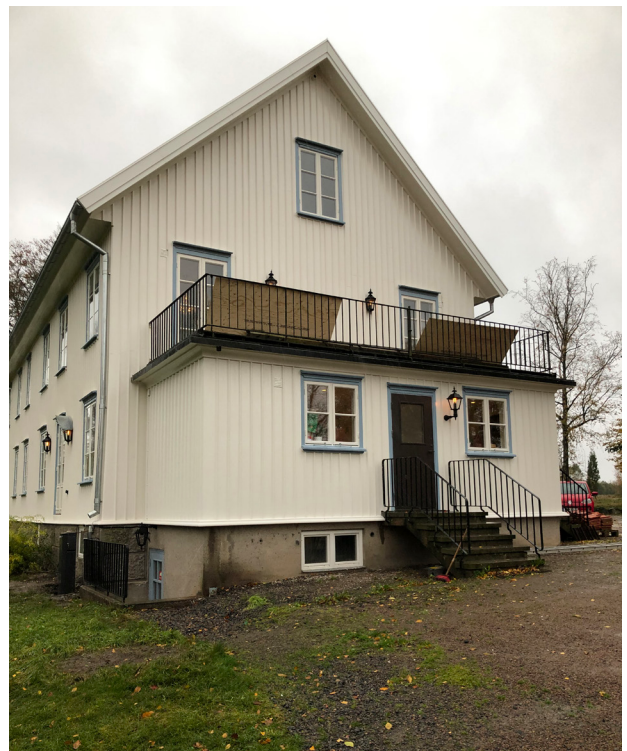
Den senare utförda tillbyggnaden har fått en vattbräda i nederkant likt resten av byggnaden.
