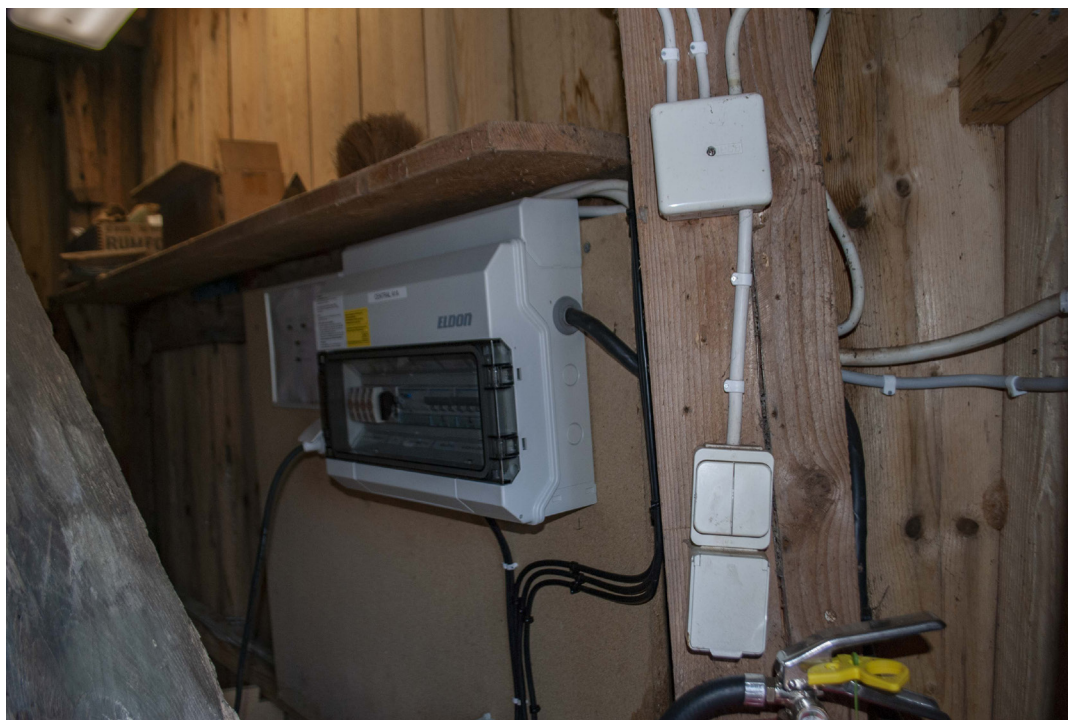
En ny elcentral med säkringar har placerats innanför dörren i klocktornet.
