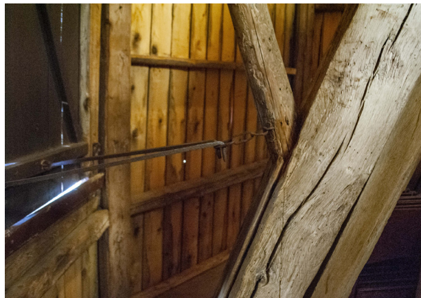
De öppnas manuellt och stängs med enkla hakar som fästs i ringar.
