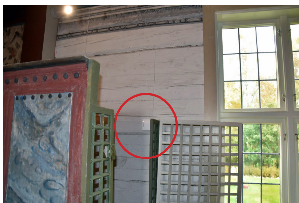
En ny givare har ersatt den gamla, på samma plats vid gallret upp till predikstolen. Foto: Svensk Klimatstyrning AB.
