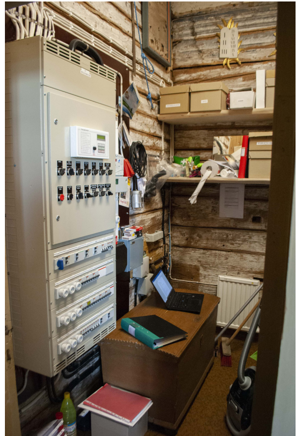
I förrådet mellan långhuset och vapenhuset fanns elcentral och förvaring av diverse bruksföremål och städmaterial. På elskåpet satt den lilla styrcentralen för mätning av luftfuktighet.
