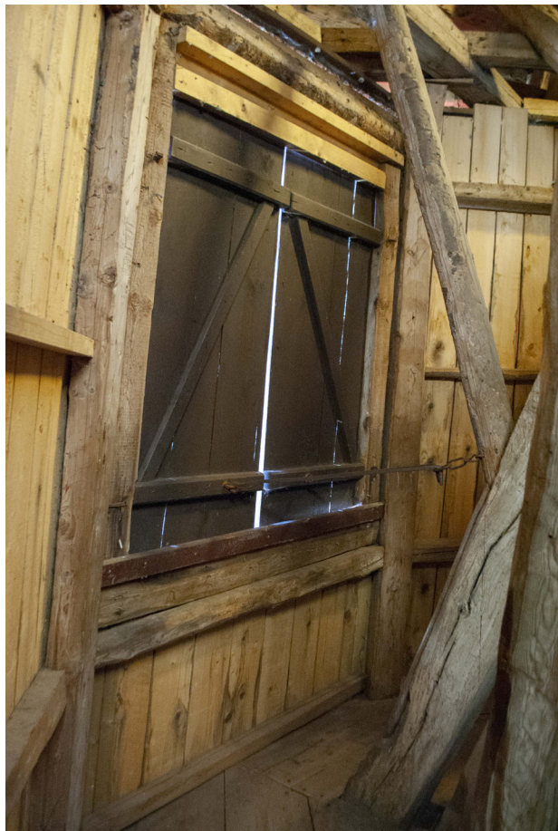
I klocktornet finns tre par ljudluckor av detta slag.
