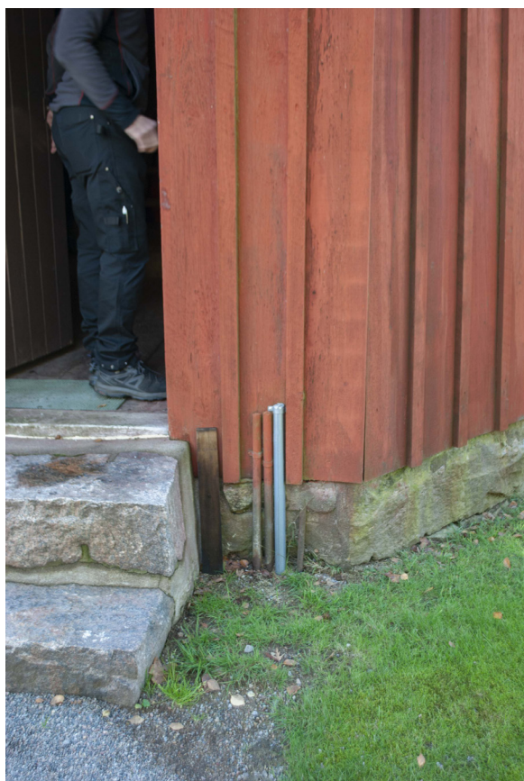
Åskskyddet har kompletterats i klocktornet med överspänningsskydd vid elcentralen innanför dörren. Ledningarna leds ned i marken utanför dörren.
