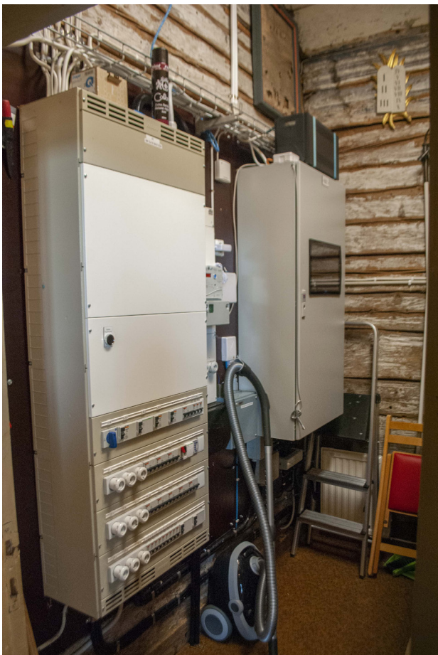
Det gamla elskåpet har byggts om och en del funktioner har tagits bort och flyttats till det nya skåpet, DUC, som sitter längre in,
