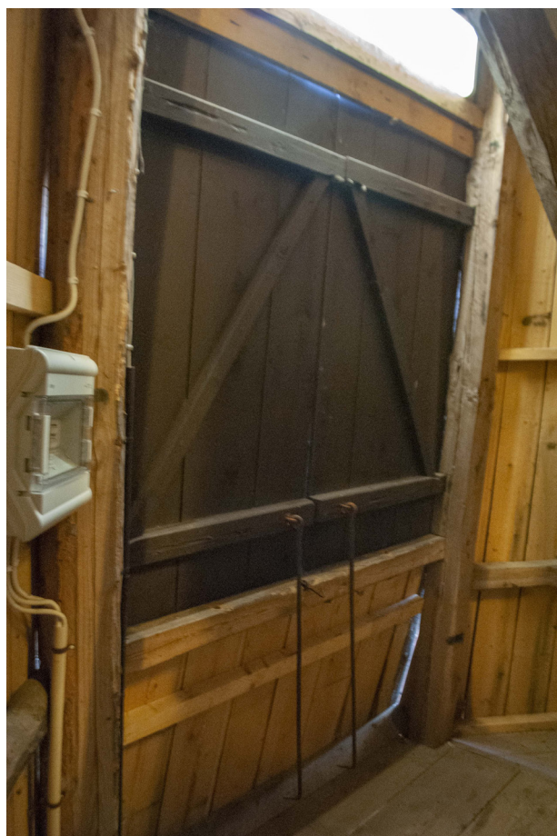
De öppnas manuellt och stängs med enkla hakar som fästs i ringar.
