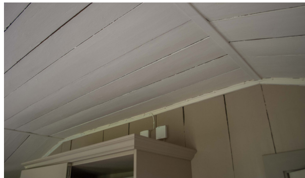
En givare och en maxtermostat har placerats över ett skåp i sakristian.
