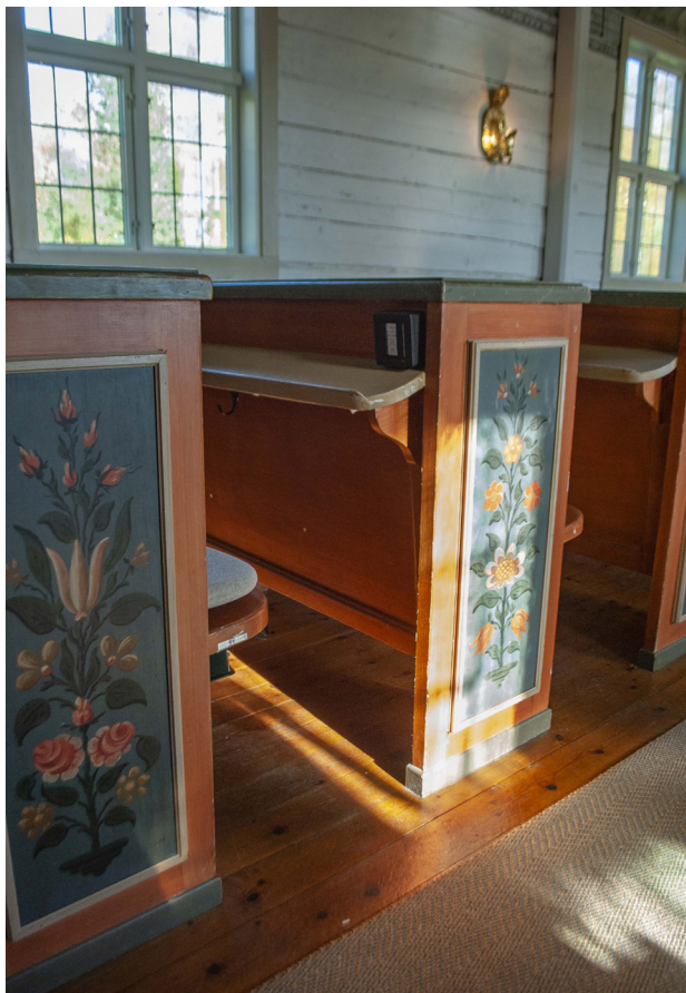
I den lilla svarta dosan ovanför psalmbokshyllan i den bakersta bänken i norra kvarteret sitter styrfunktioner för ljus och klockringning,
