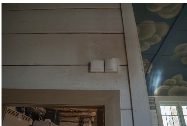
En givare och en maxtermostat har placerats över dörren till förrådet. Den givare som satt runt hörnet har tagits bort.
