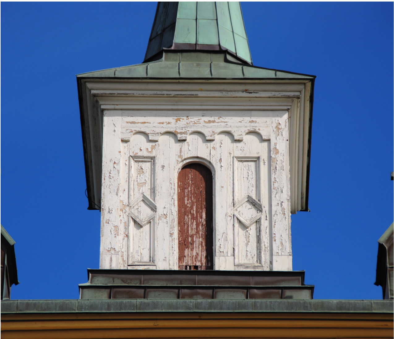
På lanterninen flagade färgskiktet och det fanns både rötskador och breda sprickor i panelen.
