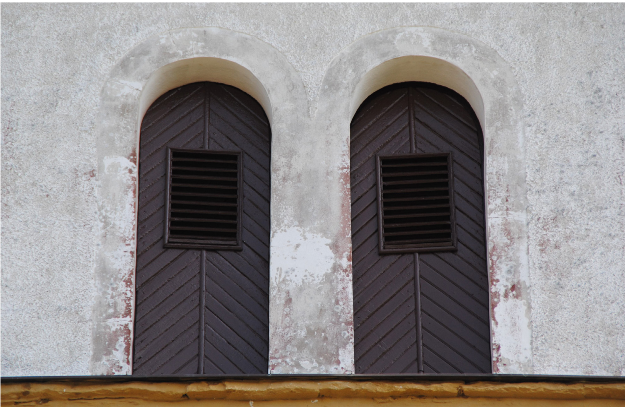
Ljudluckorna på tornet efter rengöring av lösa färgskikt och omålning med linoljefärg.
