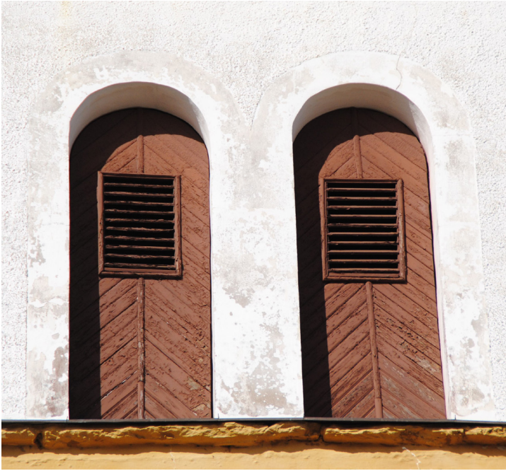
Färgskiktet på ljudluckorna flagar kraftigt, särskilt åt väster och söder.
