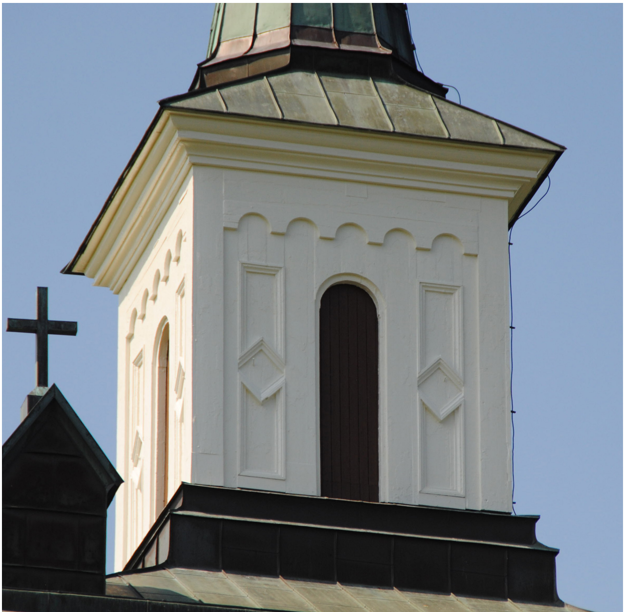
Lanterninen efter att fasaden och luckorna målats om med linoljefärg från Engwall o. Claesson AB.
