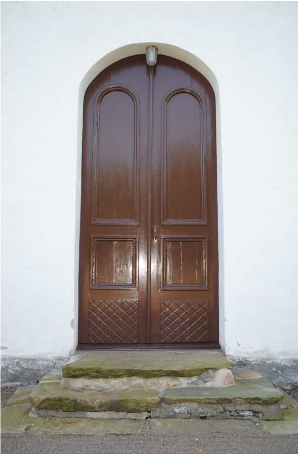
Norra entréns portar och sakristians portar efter ommålning. Norra entréns portar var i bättre skick än övriga äldre portar med mindre sprickor i speglarna.
