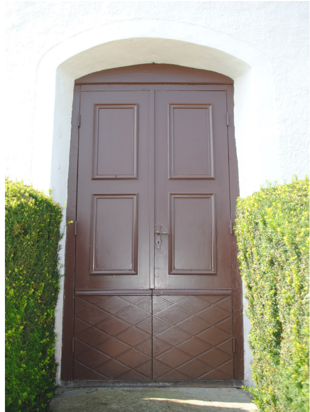
Norra entréns portar och sakristians portar efter ommålning. Norra entréns portar var i bättre skick än övriga äldre portar med mindre sprickor i speglarna.
