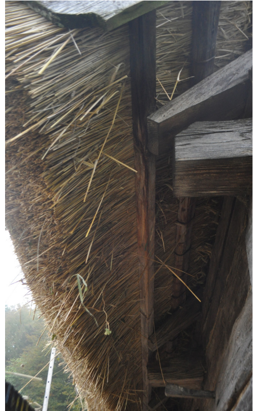
Ovan: Taktäckningen utförs. Taktäckaren jämnar ut halmen med en s.k. täckevraga. Till höger syns takfoten underifrån och de läkt som halmen vilar mot. Dessa var i gott skick och behövde inte bytas ut.
