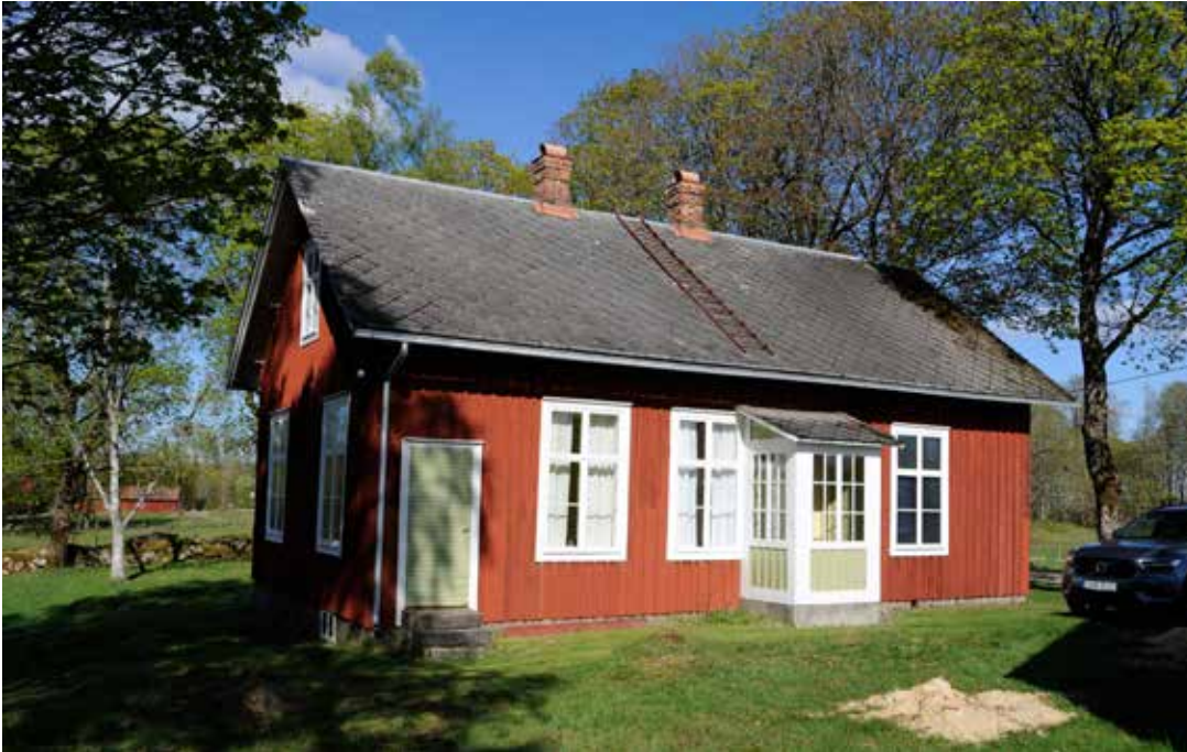
Skolbyggnaden, vy från väster.
