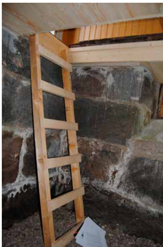
Parti av källaren efter renovering.
