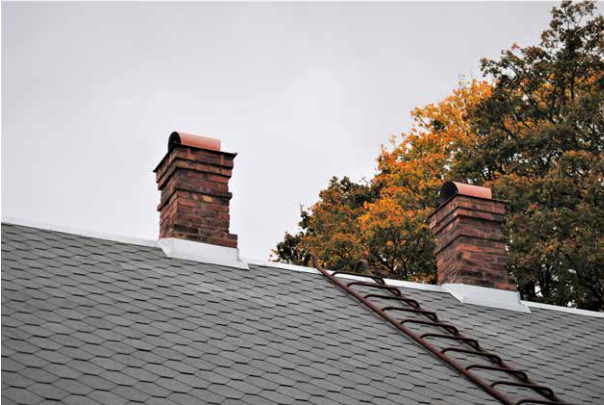
Ny takbeläggning av shingel, ny plåtbeslagning runt de omfogade skorstenarna.
