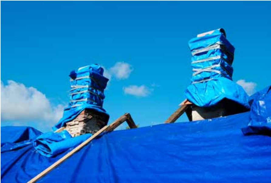
Takstommen runt skorstenarna frilades och plastades in under reparationsarbetet.
