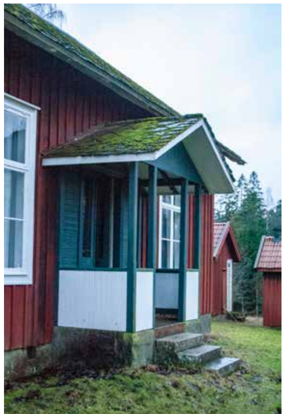
Förstukvisten vid nordösta fasaden.
