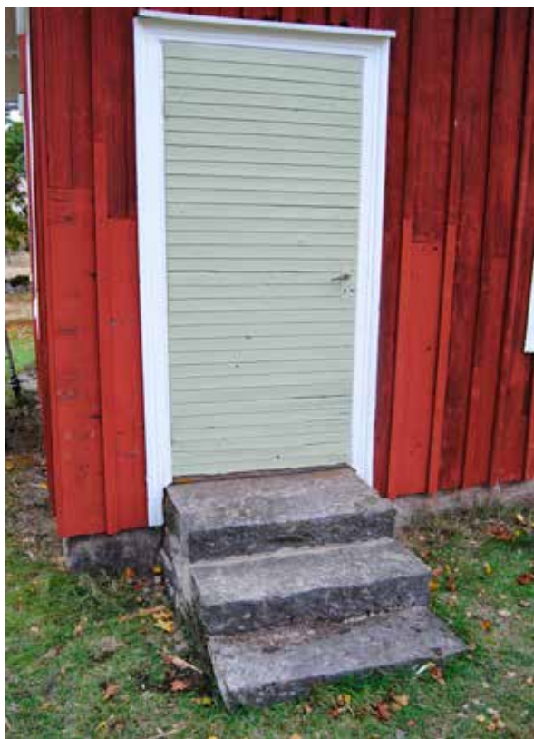
Köksingång och trappa efter renovering.
