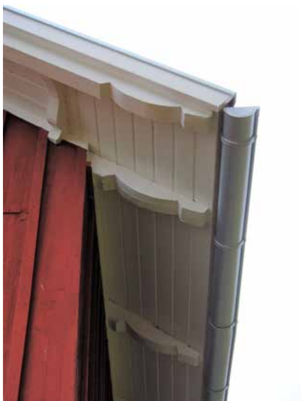
Taskäggspanel och taktassar efter renovering.
