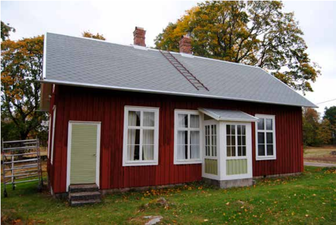
Slätteryds byskola, vy från väst. Oktober 2020. Det nya takmaterialet ansluter väl till det tidigare utseendet.
