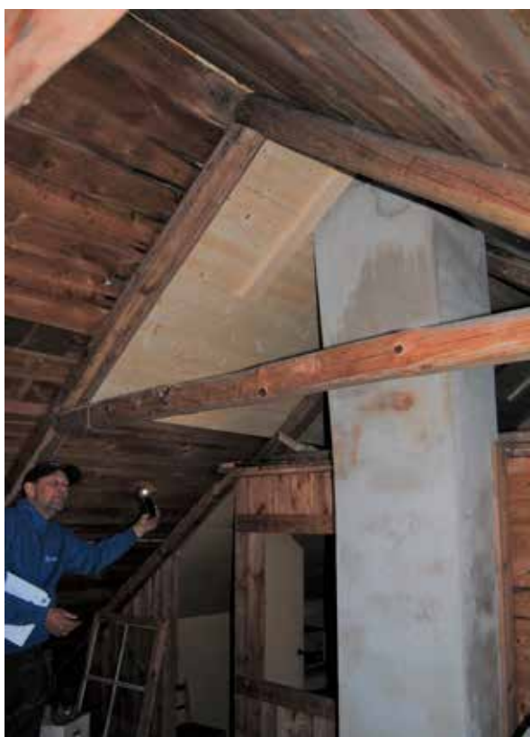
Ny spontad undertakspanel vid södra murstocken.
