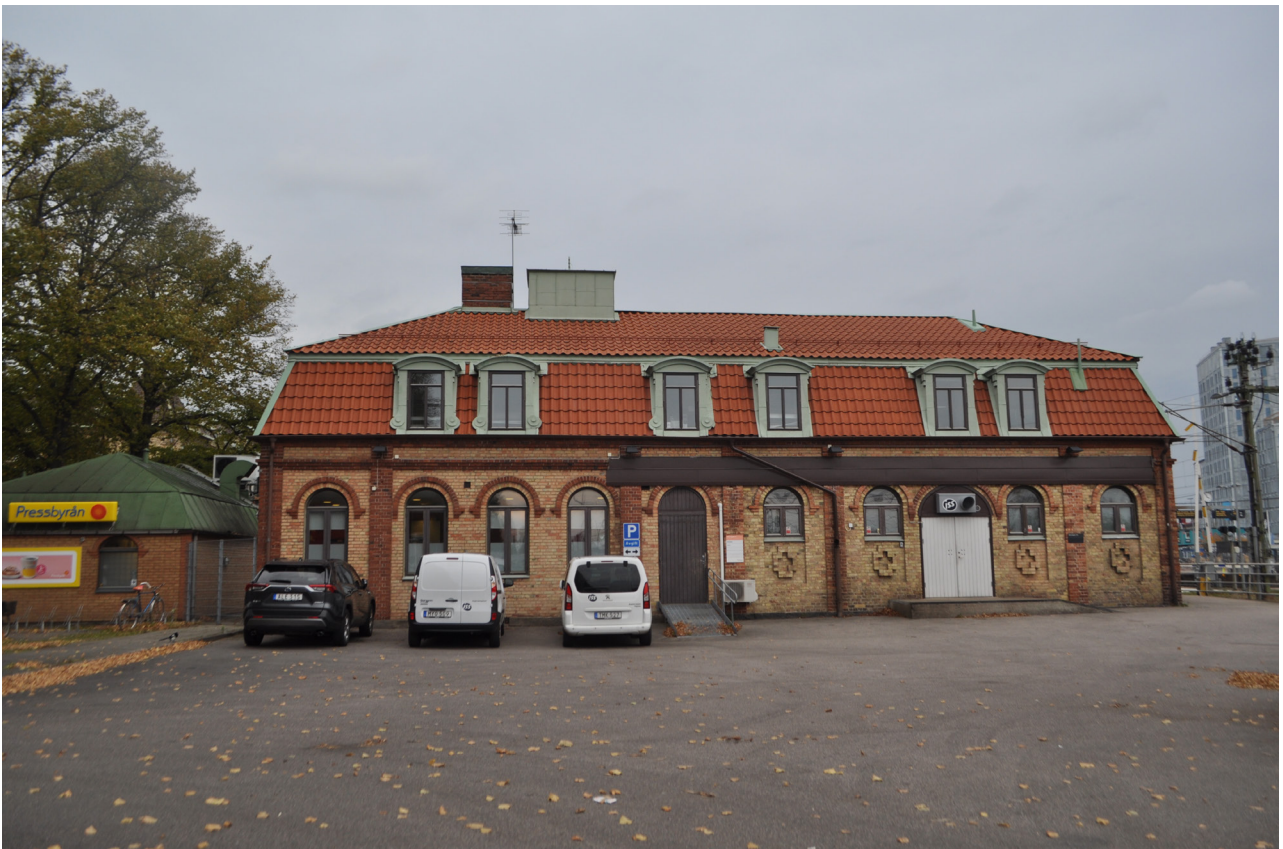
Ilgodsmagasinet, fasad mot söder. Notera den misspyrdande bruna plåten som monterats på fasadens högra sida.
