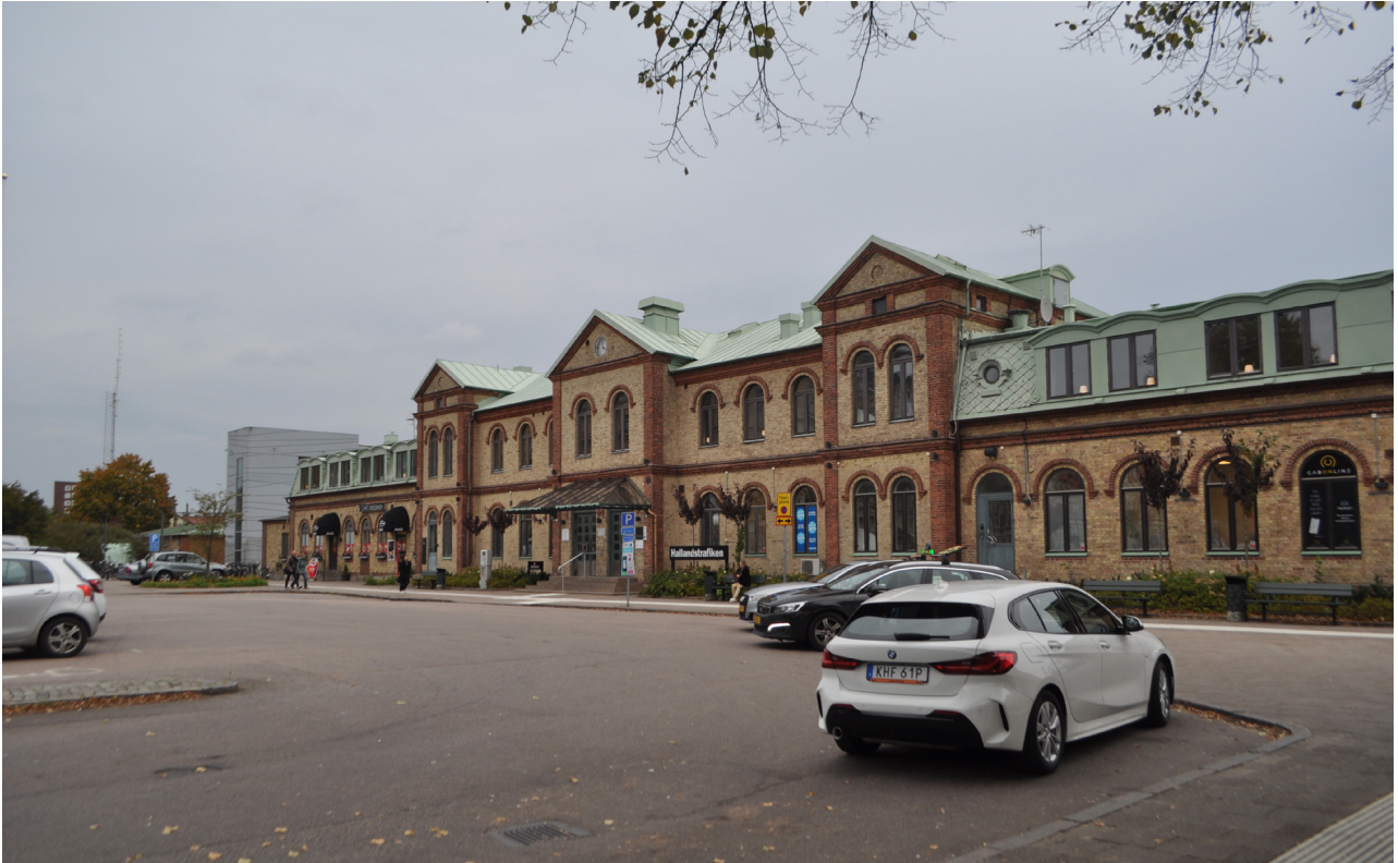
Stationsbyggnaden, fasad mot Stationsgatan med huvudentrén placerad centralt på byggnaden.
