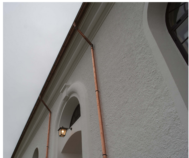
Takfoten är målad och nya hängrännor och stuprör i koppar har satts upp.
