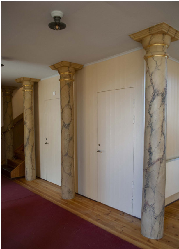
Pelarna som bär upp läktaren har kvar sin äldre marmorrering.
