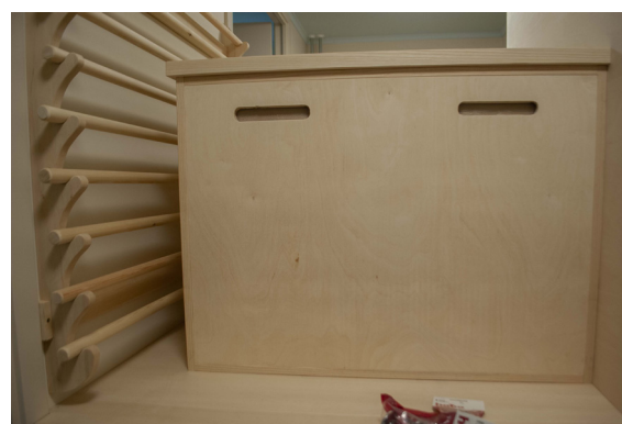
Ventilationshålen på hurtsarnas baksidor är försedda med insektsnät.
