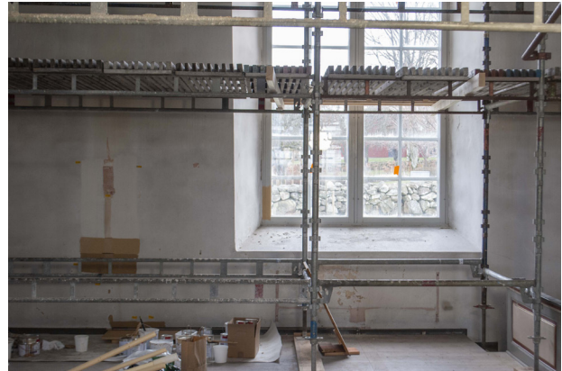
Omfattande arbete skedde med att ta fram kulörer som funnits i kyrkan tidigare och som skulle kunna återanvändas.
