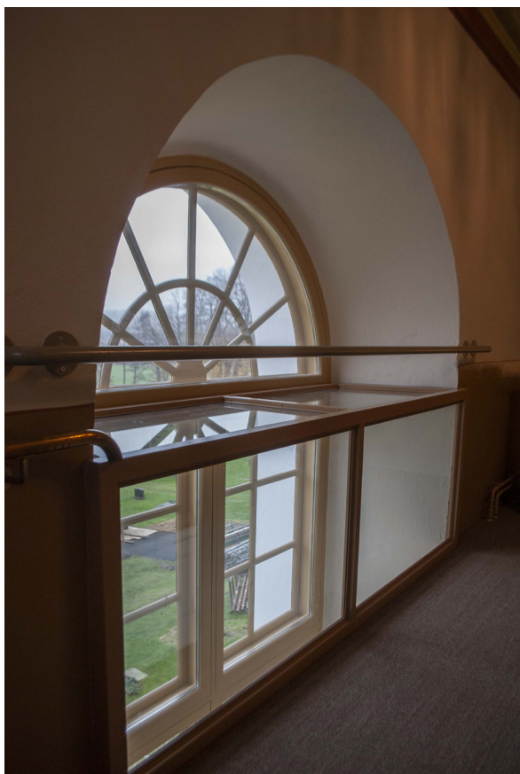
Fönstren på läktaren har byggts in med extra glas
