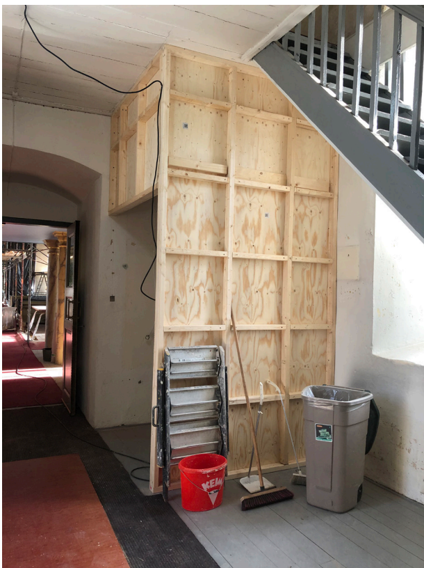
Förråd i vapenhuset under uppbyggnad.
