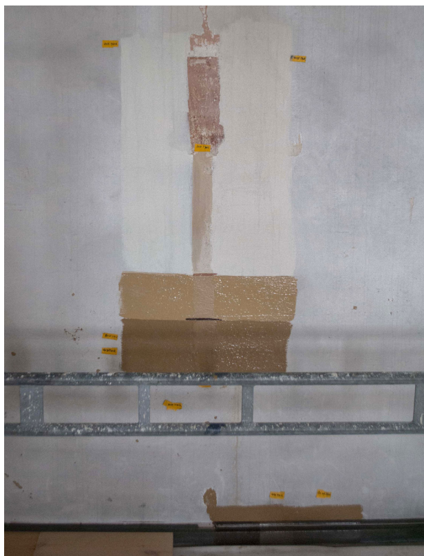
Färgsättningen av väggarna från 1904 har skrapats fram och provmålats. Nere vid golvet syns provmålning av olika sockelkulörer.
