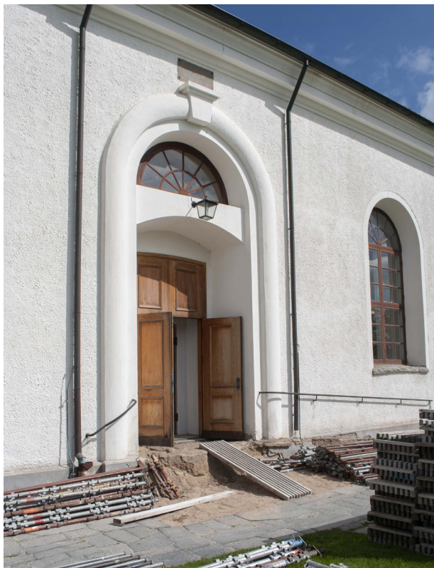
Den befintliga rampen vid södra porten revs och den gamla stentrappan från västtornet flyttades hit, se foto föregående sida.
