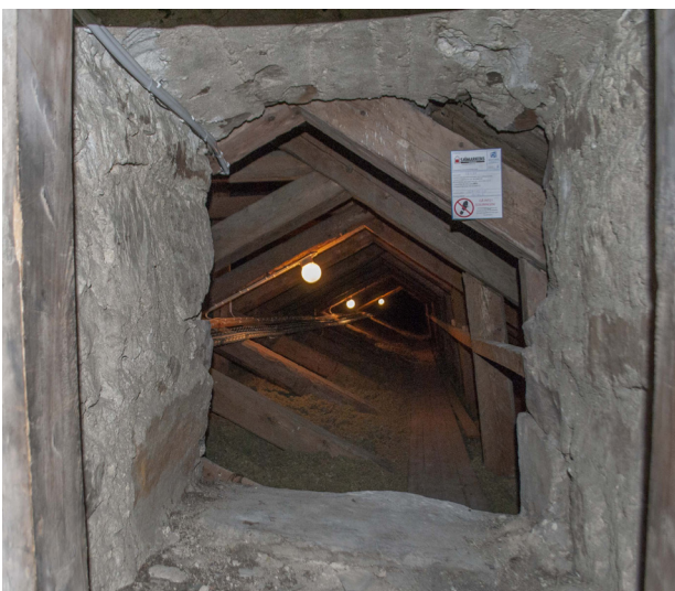
Vinden har isolerats.
