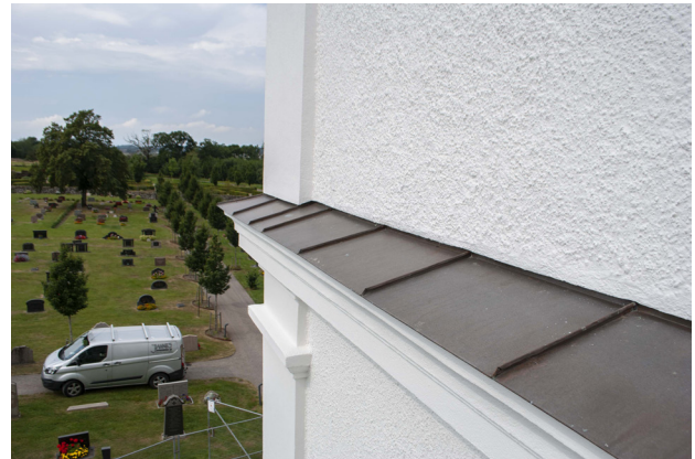
Gördelgesimsen har lagats med nytt friskt trä och klätts med ny kopparplåt.
