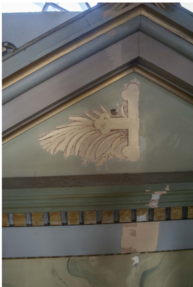
På portalerna mot söder och norr återfanns dekormåleri i tympanonfältet och olika rosa nyanser.
