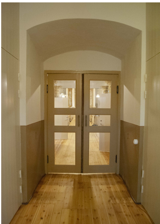
Svängdörrarna mellan vapenhus och kyrkorummet har försetts med glas.
