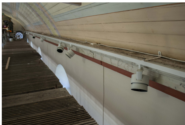
Längs långhusets takfot sitter en vit metallskena med spotlights.
