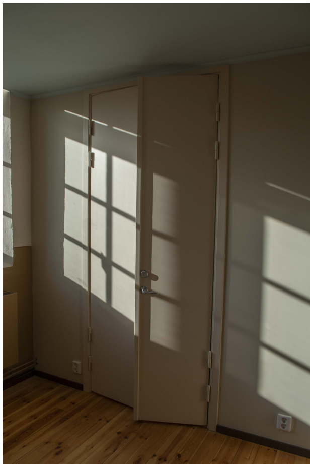
Väggen mot textilförvaringen har ett slätt utförande med två pardörrar.
