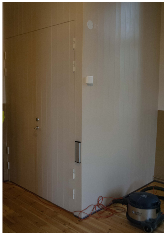
Ett av de nya förråden i vapenhuset.
