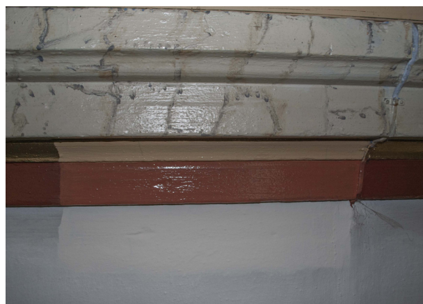
Provmålning av väggfärg och kulörer på takfoten.
