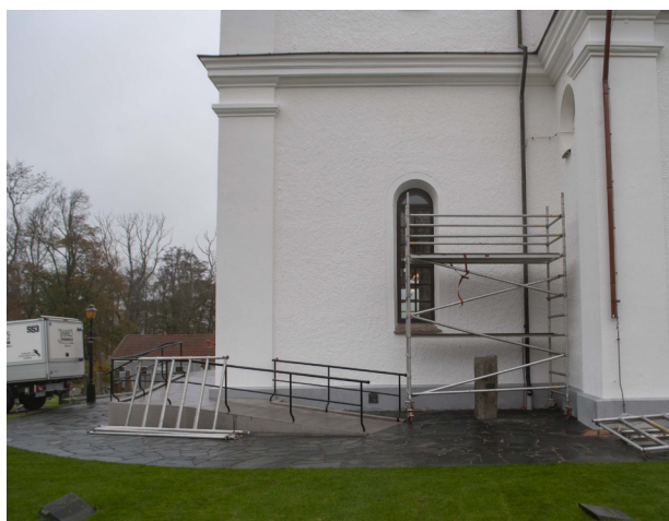
Den nya rampen har byggts vid västporten i tornet. Markbeläggningen av skiffer har kompletterats och återställts efter arbetena.
