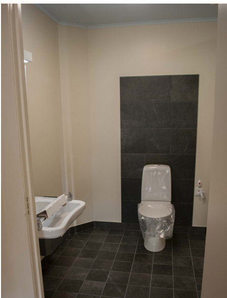
Ett av den nya WC: n under läktaren.
