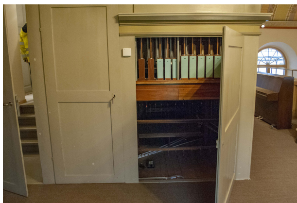
På orgelhusets sydsida sitter en givare som mäter temperatur och luftfuktighet.
