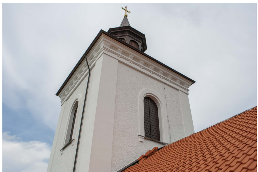
Takfoten är målad och nya hängrännor och stuprör i koppar har satts upp.
