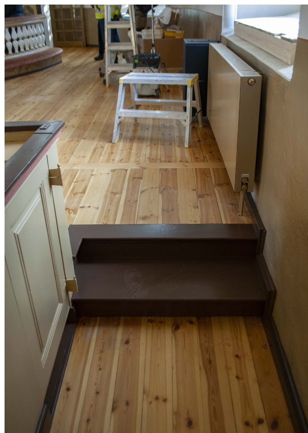
Trapporna till läktaren har kontrastmålats i sockelkulören.
