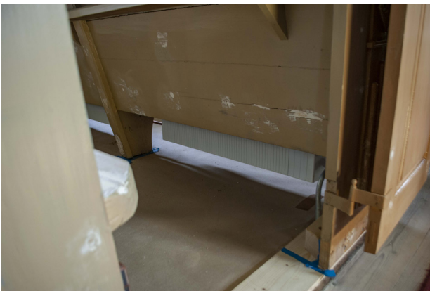
Konvektor under kyrkbänk, som håller på att målas.
