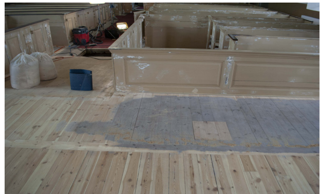
Trägolvet i kyrkan var grånat och slitet. Den slipade ytan gav ett ljust fint trägolv som behandlades med hårdvaxolja för att behålla träets ljusa varma karaktär.
