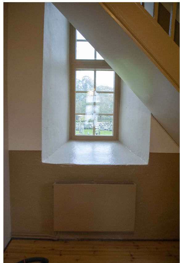
Alla radiatorer i kyrkorummet och vapenhuset har målats i samma färg som väggen bakom.
