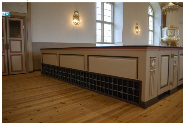
De gamla dekorativa ventilationsgallren på bänkkvarters baksida har täckts på insidan av en mörk skiva.
