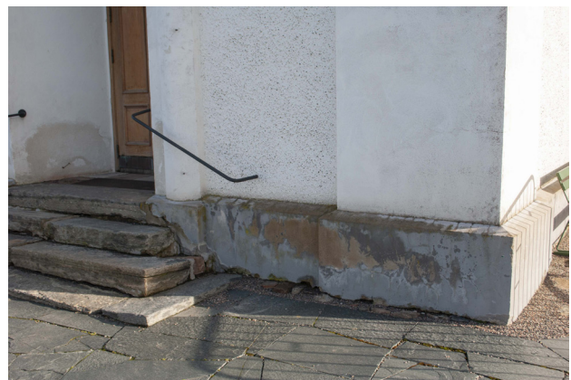
Vid närmare anblick fanns en del skador i putsen men framför allt på grunden.
