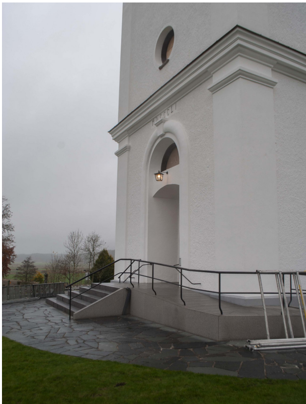
Den nya rampen har byggts vid västporten i tornet. Markbeläggningen av skiffer har kompletterats och återställts efter arbetena.
