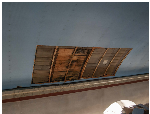
På södra och norra sidan av långhuset stod under en period kaminer med skorstenar. Hålen har lagats med vanliga ohyvlade brädor. Här syns en mörkbrun färg på det spontade bräddtaket, under 1904 års dekormåleri.
