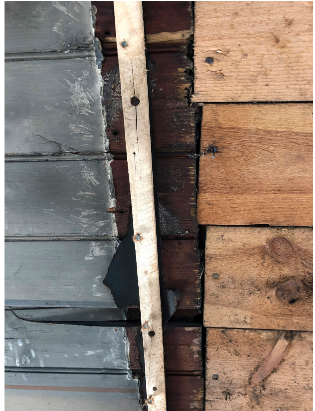
På södra och norra sidan av långhuset stod under en period kaminer med skorstenar. Hålen har lagats med vanliga ohyvlade brädor. Här syns en mörkbrun färg på det spontade bräddtaket, under 1904 års dekormåleri.
