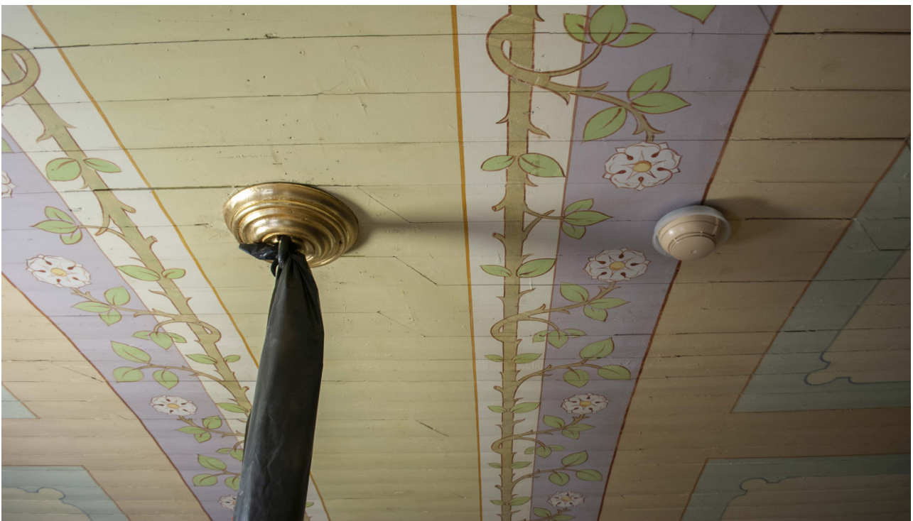
De små rökdetektorerna är inmålade i takets kulörer, här har den rosa valts.
