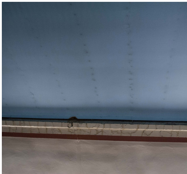
Rader av spikhuvuden lyste igenom den blåmålade glasfiberväven.
