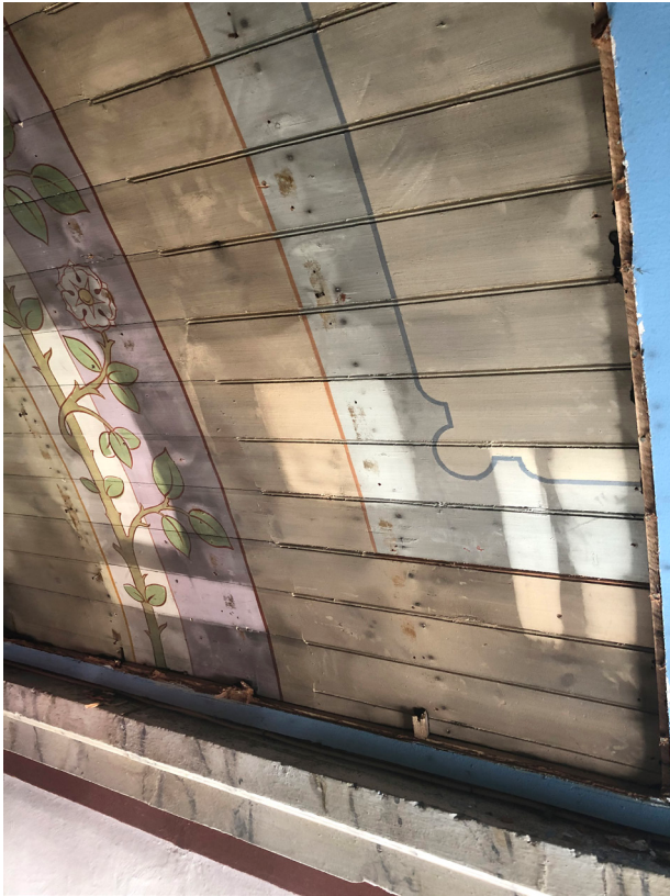
Framtagna stycken av det underliggande bemålade bräddtaket. De ljusa rutorna utgörs av rengjorda partier.
