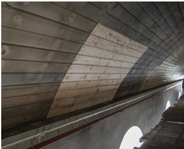
Hålen där skorstenarna suttit har lagats med pärlspont likt övriga taket.
