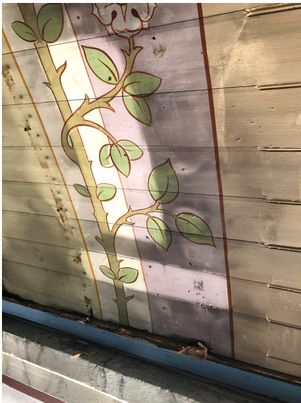
Framtagna stycken av det underliggande bemålade bräddtaket. De ljusa rutorna utgörs av rengjorda partier.
