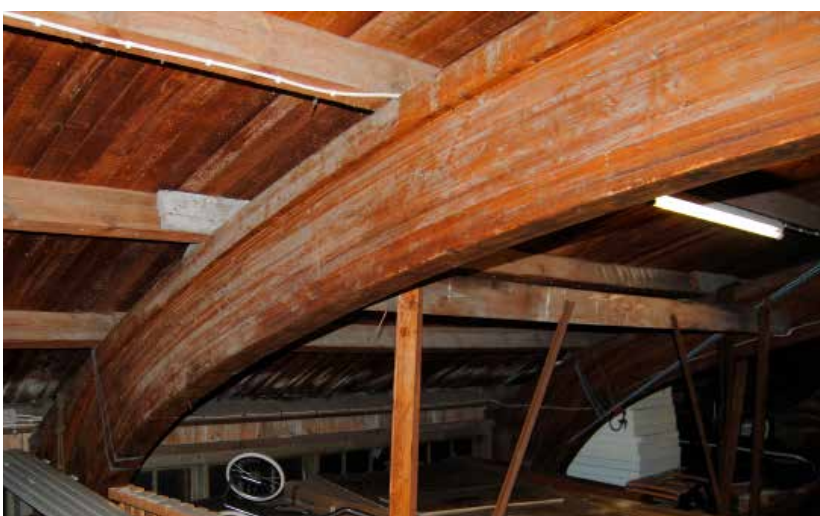
Limträbalkarna består av uppåt 30 lammeller/brädor som limmats ihop och böjts under hårt tryck. Notera att lamellerna på vilka takreglarna vilar är kraftigare än övriga lameller.
