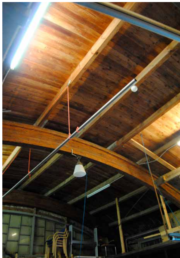
Limträbalkar bär upp regler till det ursprungliga yttertak.
