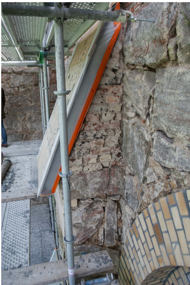
När all puts togs ned framträdde de olika murverken av sten med inslag av tegel som här i övre delen av en kontrefor.
