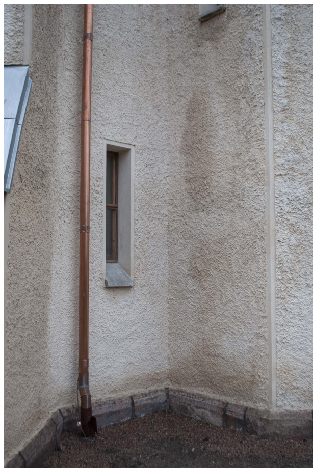
Nya stuprör i koppar har monterats. Lövsilarna kommer också att bytas.
