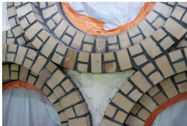
Alla fogar har rensats och fogats om med bruk. Här pågår fogning med det pigmenterade bruket.
