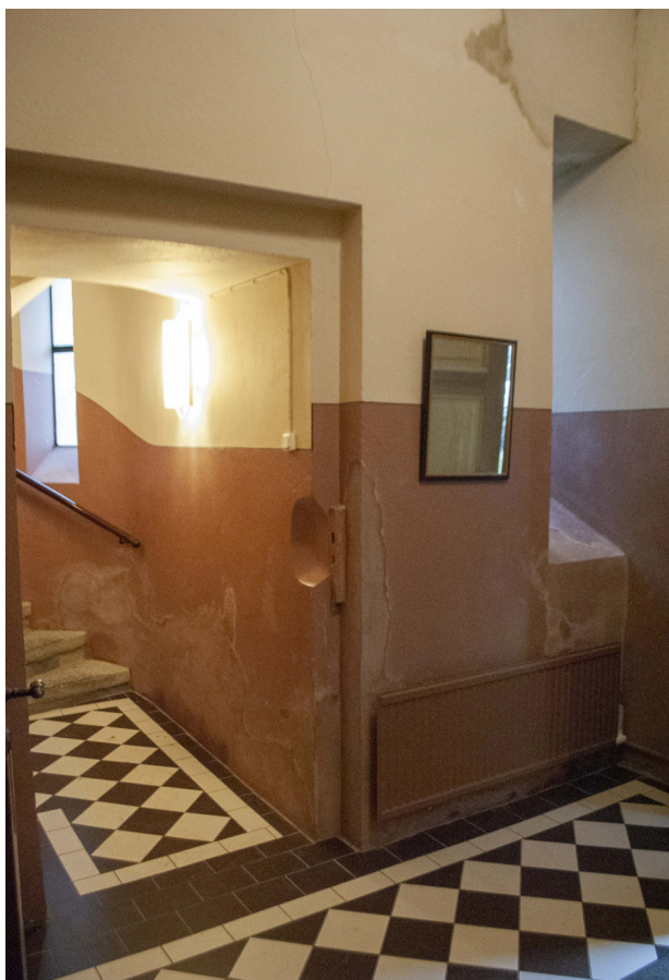
Saltskadorna på väggarna i vapenhuset har lagats med infärgat kalkbruk.
