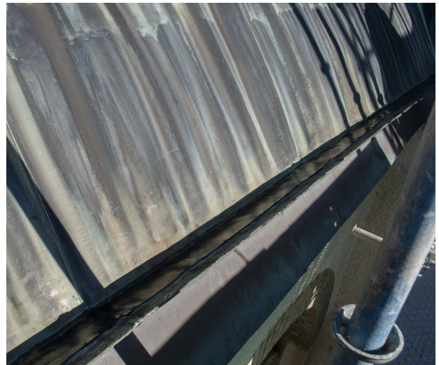
Insidan av ståldrännen skyddas nu med en armerad gummimatta.
