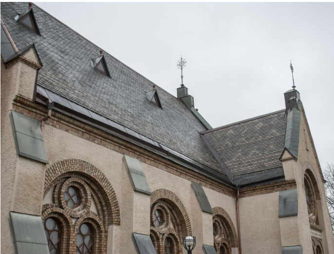
Långhustaket efter renoveringen.
