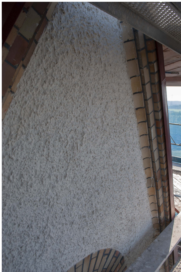
Ett parti av fasaden som spritputsats och slammats med Ölandskalk.
