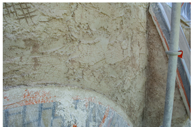
Utstockningsbruket har lagts i tjockare lager och har bearbetats för att ge fäste för spritputsen.
