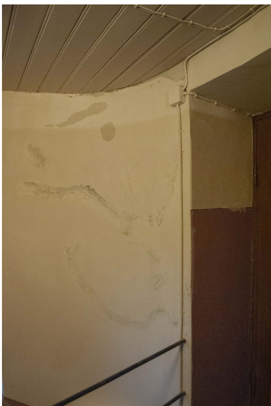
Saltskadorna på väggarna i vapenhuset har lagats med infärgat kalkbruk.
