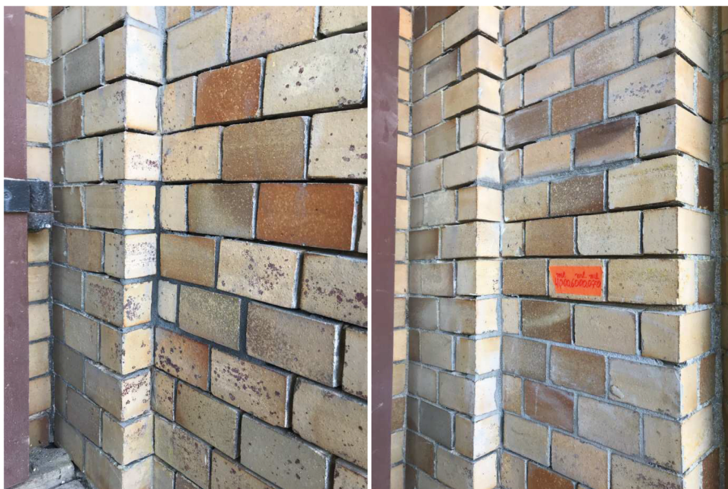
Prov på pigmenterad fog. Första bilden visar det prov som valdes och andra bilden visar ljusare prov.
