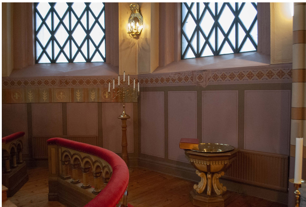
Helhetsintrycket av väggarna i koret är fint även om mönstermålningen inte återskapats över skadorna.
