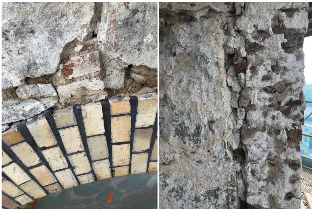
Fogning av tegelmurverket med nytt pigmenterat kalkbruk. Kontrefor med spricka har ett parti med tegel som en kaka ytterst som föranlett spricka. Detta parti är i sig i gott skick och fäst med dubb och nät istället för ommurning.
