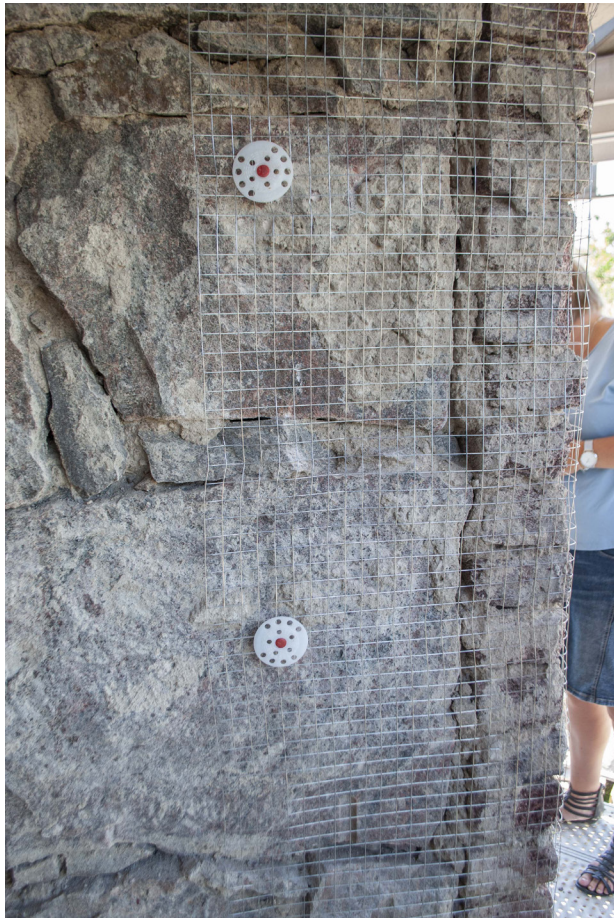
Kontreforen i sydväst har fästs mot muren med ett nät monterat med rostfria gängstänger.
