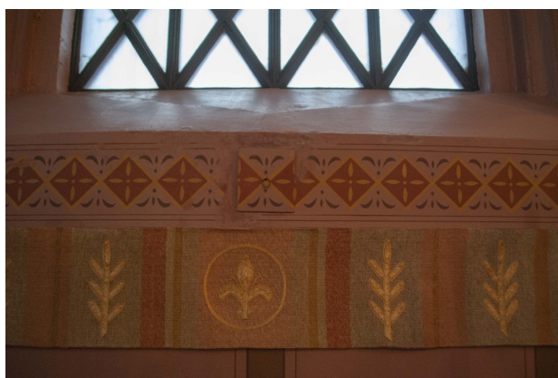
De skadade partierna under fönstren mot söder i koret har lagats med infärgat kalkbruk.
