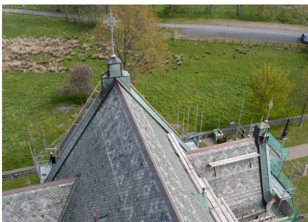
Nockplåten av koppar är utbytt på korsarmarna.
