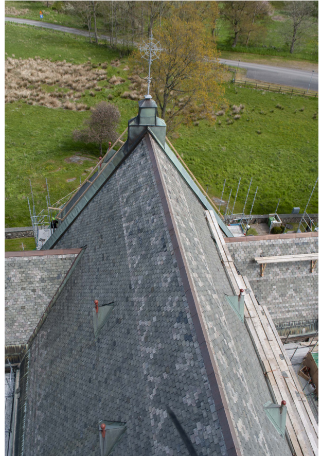
Det mönsterlagda skiffertaket sett från tornet efter renoveringen.
