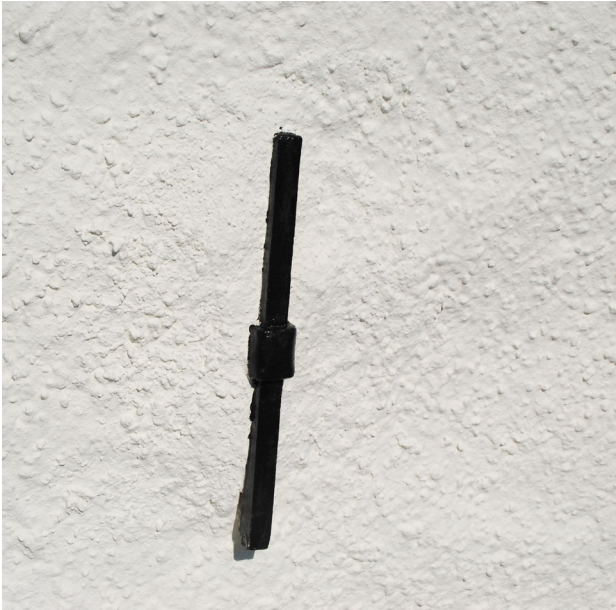
Ankarjärn efter rengöring från rost, rostskyddsbehandling med järnmönja och målning med svart linoljefärg.
