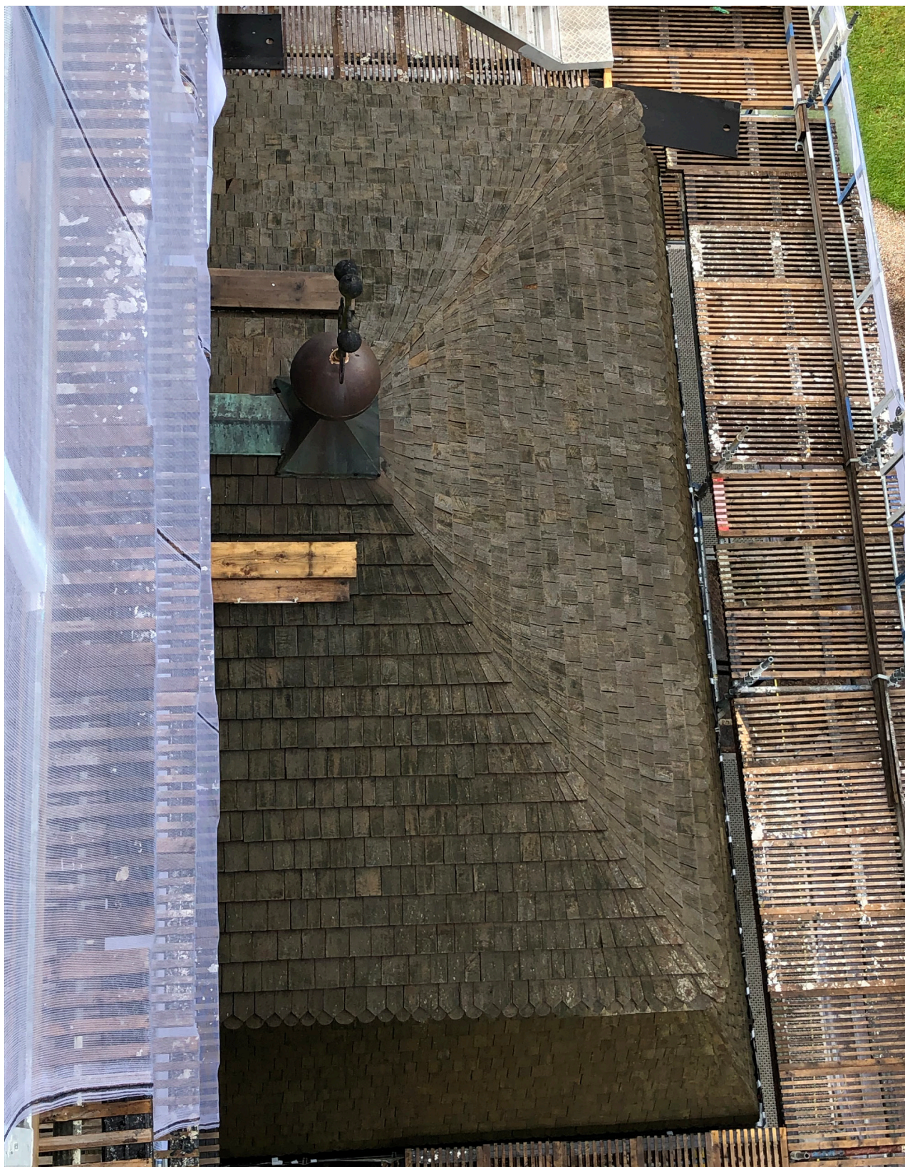
Kyrkan tre spåntak var i behov av rengöring och tjärning. Det fanns en del påväxt av mossa och alger på taken.
