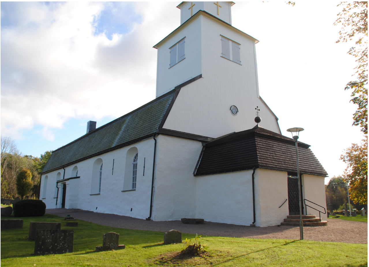
Nedan: Norra fasaden och vapenhuset efter putslagning och avfärgning med silikatfärg.
