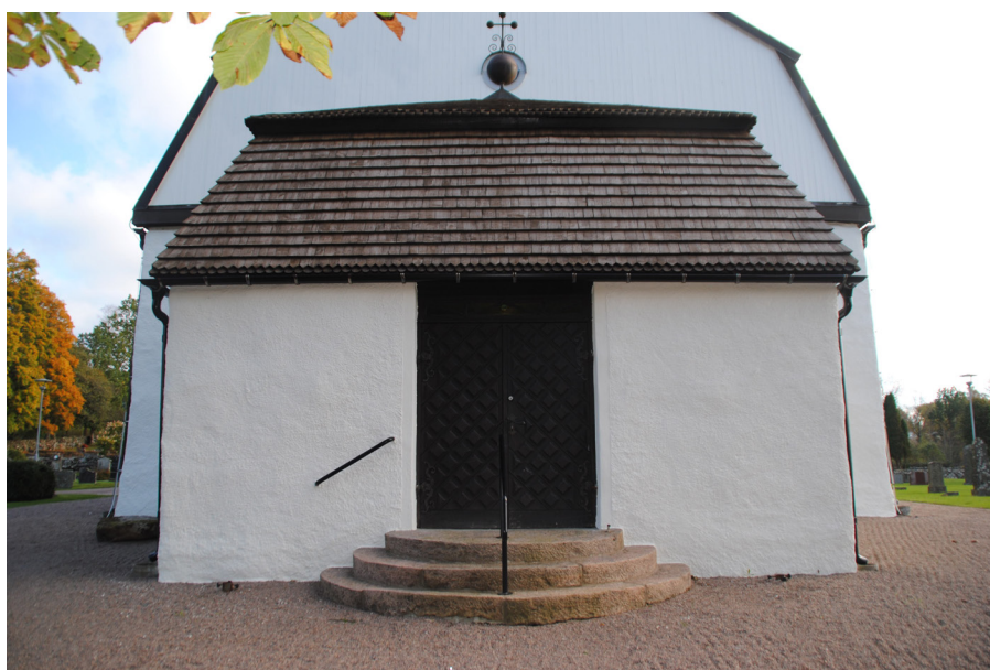
Fasaden på huvudentrén efter putslagning och avfärgning.
