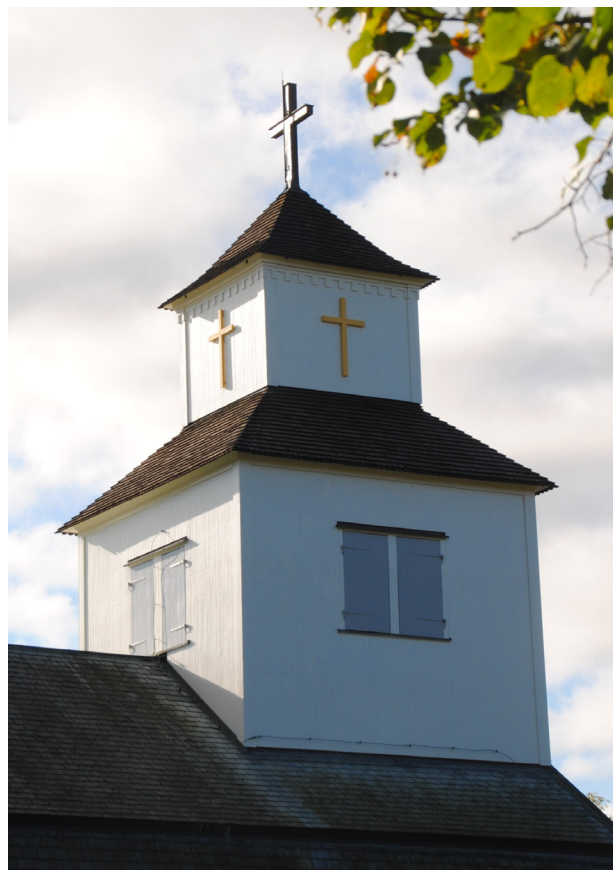
Tornöverbyggnaden efter att fasaden och luckorna målats om med linoljefärg från Engwall o. Claesson AB.
