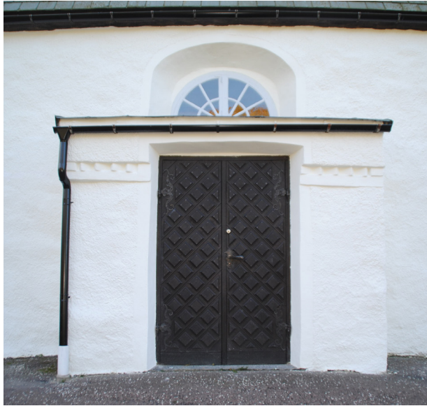
Till vänster: Norra sidoentrén efter renovering.
