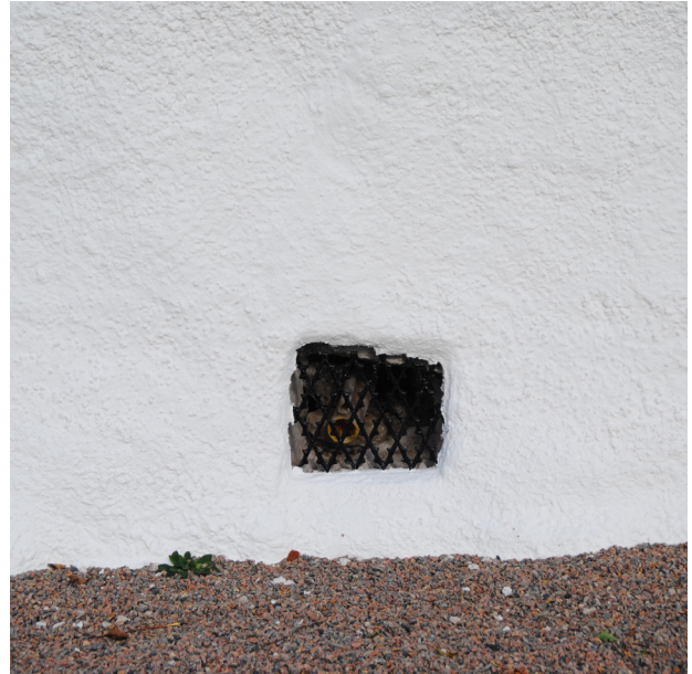
Nedtill på fasaderna finns ett antal ventiler med galler i gjutjärn. Dessa har behandlats på samma sätt som ankarjärnen, se text till vänster.
