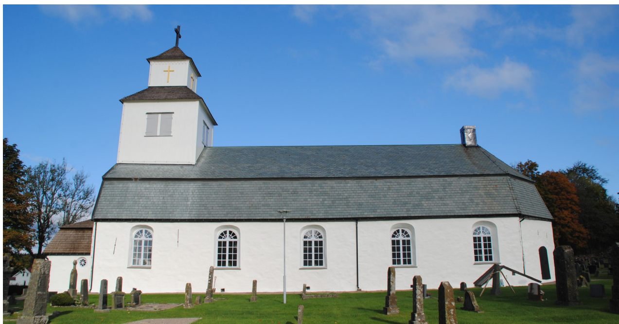
Nedan: Södra fasaden efter putslagning och ommålning.
