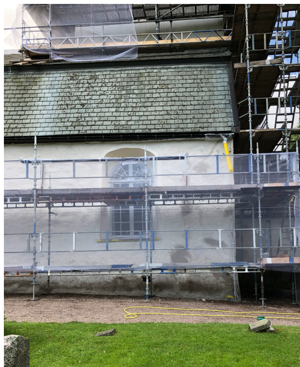
Mindre fläckvis uppkomna putsador håller på att lagas på långhuset norra sida.
