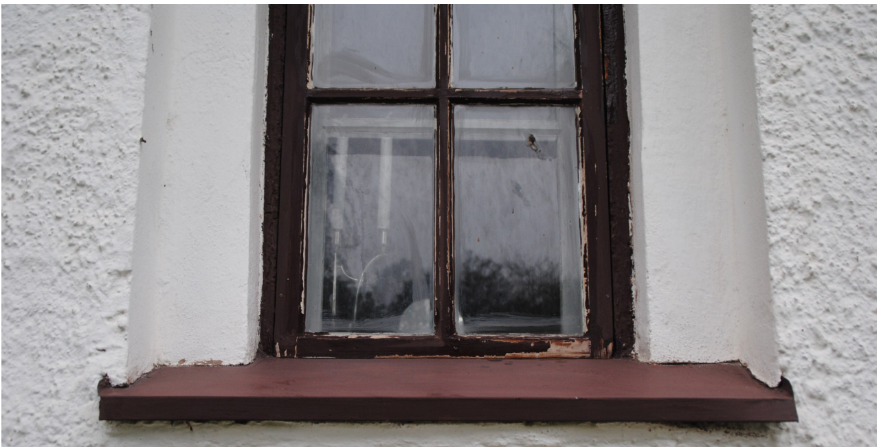
Fönstren på sakristian hade en del färgsläpp och kittningen behövde kompletteras. Fönstren renoverades på plats.
