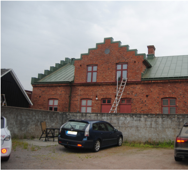
Byggnadens västra sida efter att takrenoveringen färdigställts.
