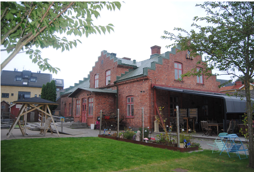
Byggnadens entrésida. I samband med takomläggningen har balkongen på entrédelen tagits bort vilket återställt det ursprungliga uttrycket.
