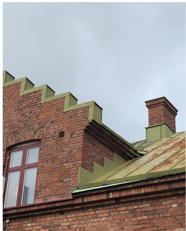
Närbild på anslutningen mellan tak och frontespis. Den gröna kulören hade blekts kraftigt och det var svårt att identifiera hur den sett ut från början.
