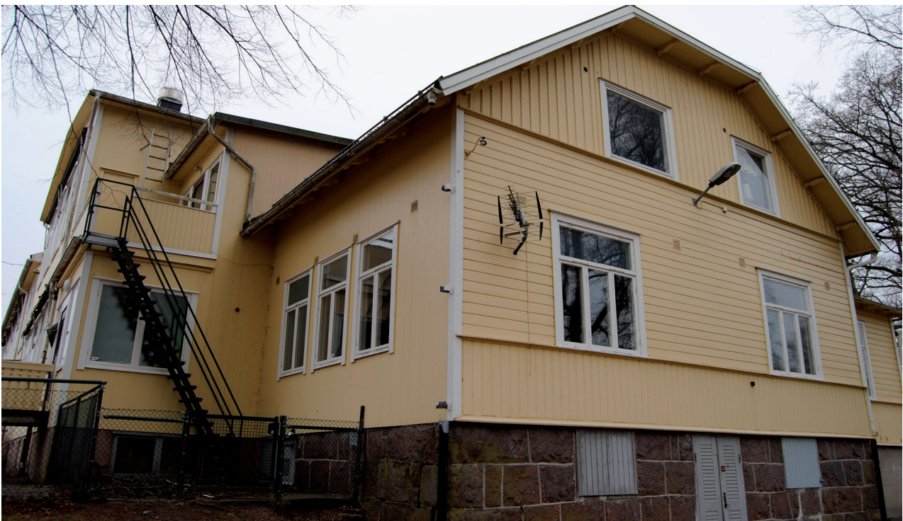
Den norra gaveln med liggande och stående träpanel med dropplist. Grund av kvaderhuggen sten.
