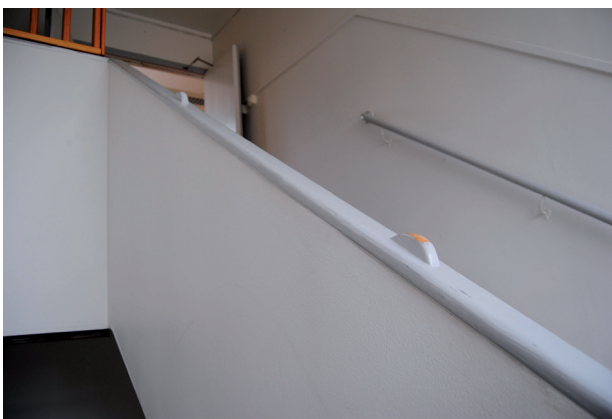
Det enkla men dekorativa räcket i trapphuset.
