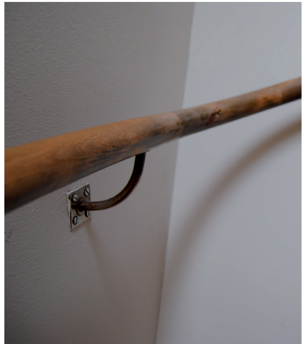
Räcke med rund handledare och metallinfästningar.
