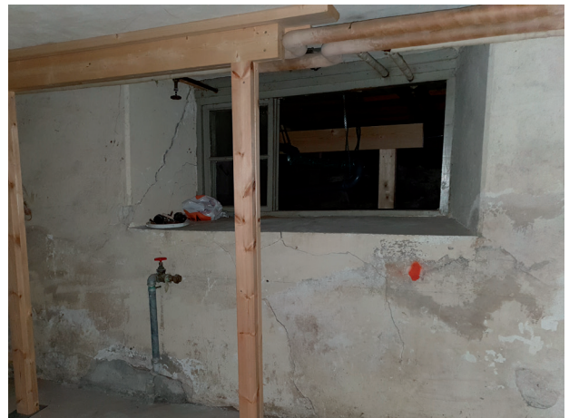
Gammalt fönster i tvättstugan som vittnar om att bakomliggande del är tillbyggd.
