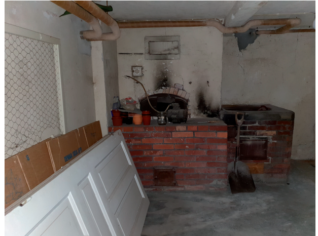
Bevarat inbyggt tvättkar med eldstad i den gamla tvättstugan i källaren. Här ligger även en gammal spegeldörr.
