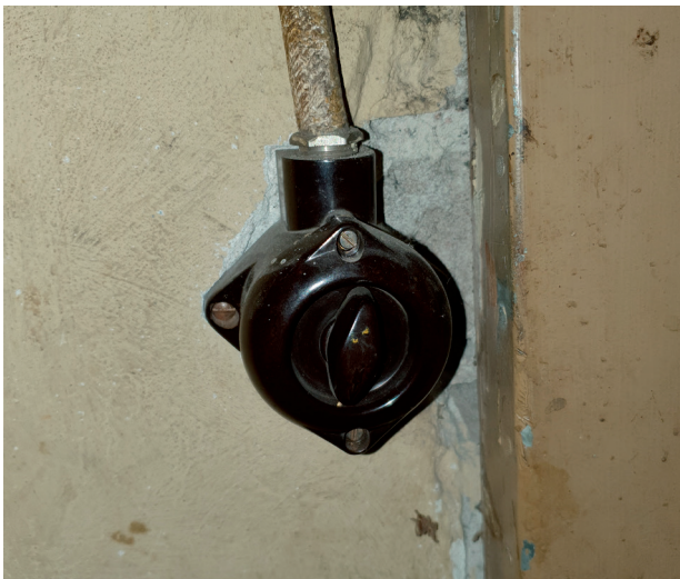
Gammal lysknapp av bakelit i källaren.
