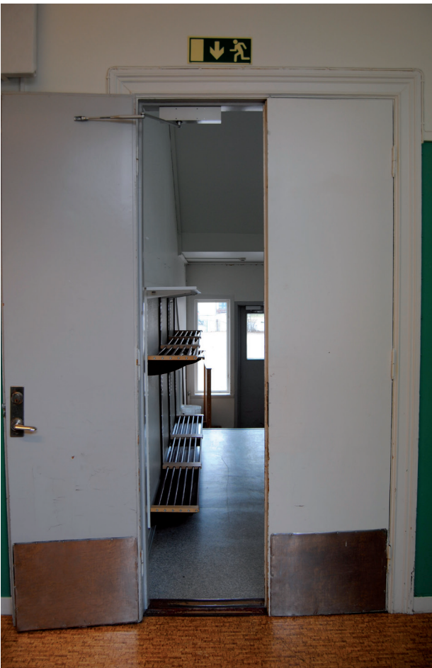
Överst: Räcke i trappa i den äldre delen av skolan. Ovan: Två äldre dörrhandtag som vittnar om husets ålder. T.v: Dubbeldörrar med sparkplåt från trapphus till korridor/ kapprum på bottenplan. Har skymtar även de äldre profilerade dörrfodren.
