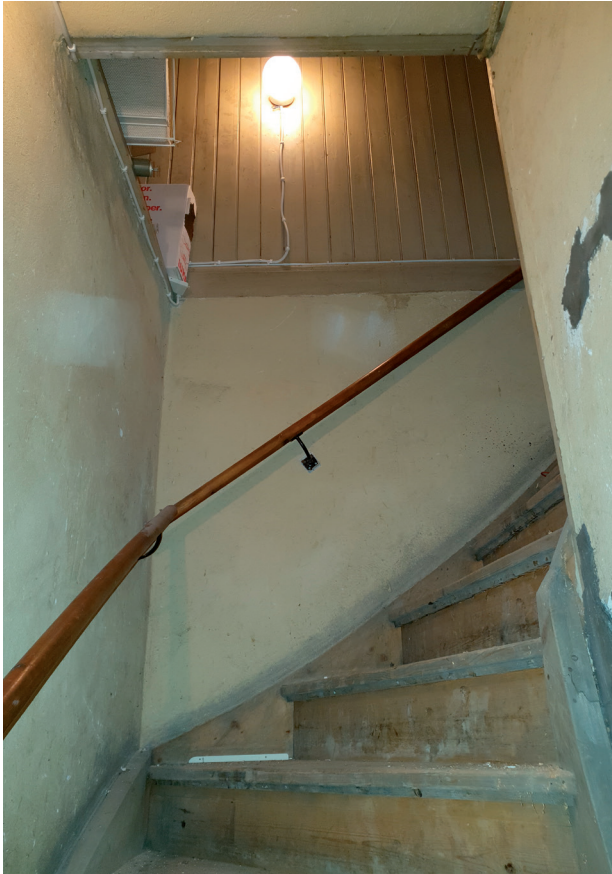
Trappan ner till källaren. Denna del av huset är mer eller mindre intakt sedan uppförandetiden. Trappan är av trä, väggar täckta av pärlspontpanel och dörrfoder är profilerade. Även äldre lysknappar finns bevarade.
