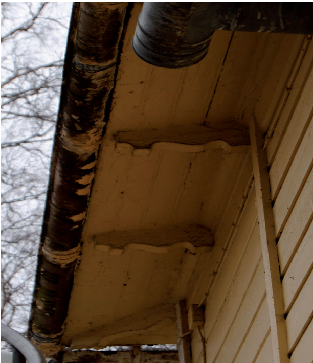
Profilerade taktassar på den äldsta delen av skolan.
