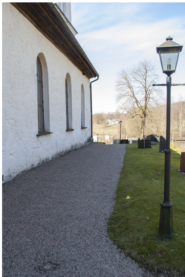
Gräsytan närmast den norra långhusväggen har ersatts med grus för att förhindra fuktvandring i murarna.
