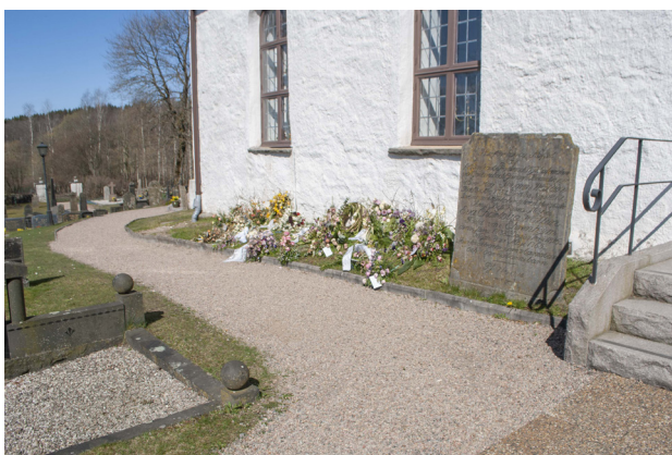
Grusgången längs södra långhussidan.
