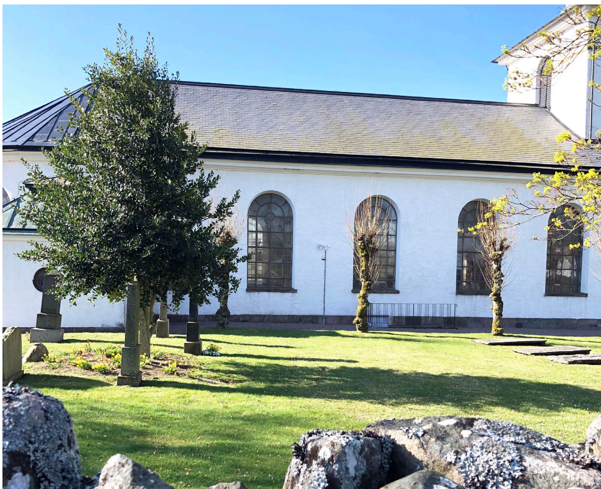
Utomhusgivaren har placerats på långhusets norra vägg, i anslutning till den exteriöra trappan ned till pannrummet i källaren.
