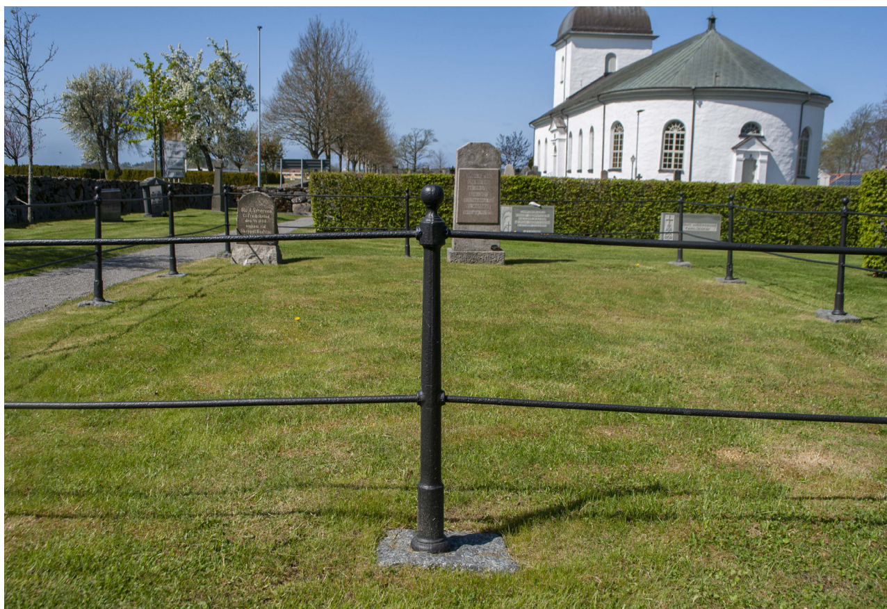
Kvarter D, Grav 175. Staketet har demonterats, reparerats, blästras och målats. Stenarna har rengjorts.
