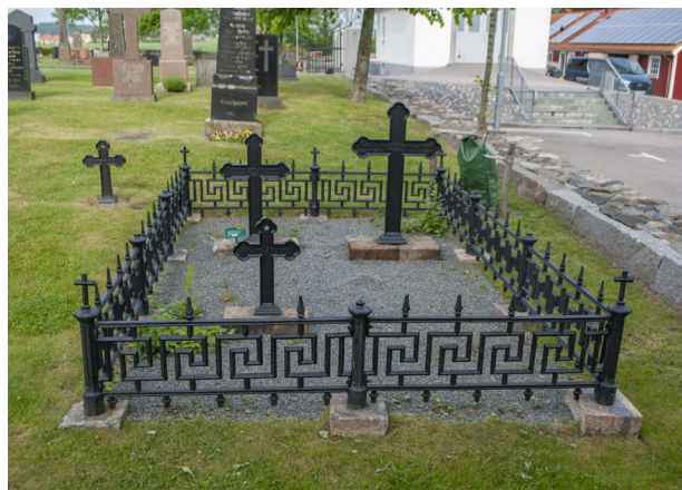
Grav nr 68-69. Korsen och staketet har blästrats, lagats och målats. Staketets lösa delar har svetsats och lagats. Korsens fundament och staketets plintar har lyfts upp så att de står ovan mark, jämnt och stabilt.
