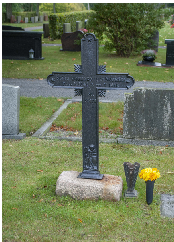
Grav 296-297 Korset har rengjorts och målats. Det har placerats på ett nytt postament.
