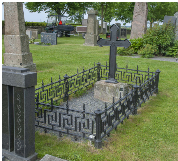
Grav 231: Korset och staketet har blästrats, lagats och målats. Staketets lösa delar har svetsats och lagats. Korsets fundament och staketets plintar har lyfts upp så att de står ovan mark, jämnt och stabilt.
