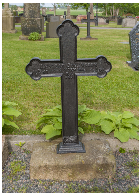
Grav 63-67. Korset står i en större familjegrav med två höga gravvårdar i sten. I detta skede har korset åtgärdats; blästrats och målats.
