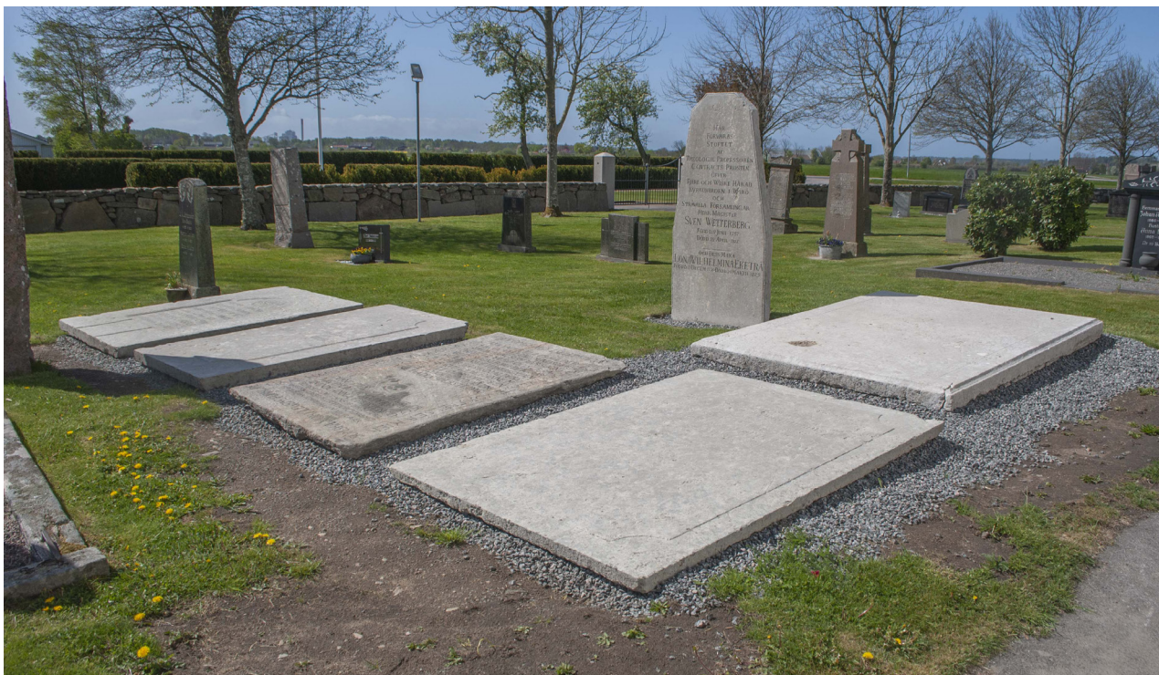
Grav 152 och 305. Marken runt stenen har fyllts med makadam. Stenhällarna har lyfts. Marken har belagts med 30 cm makadam på markduk. Hällarna återplacerades med 40 cm avstånd från varandra med svag lutning. Stenarna har rengjorts och där inskription gick att utläsa har de fyllts i med svart alkydolfärg.
