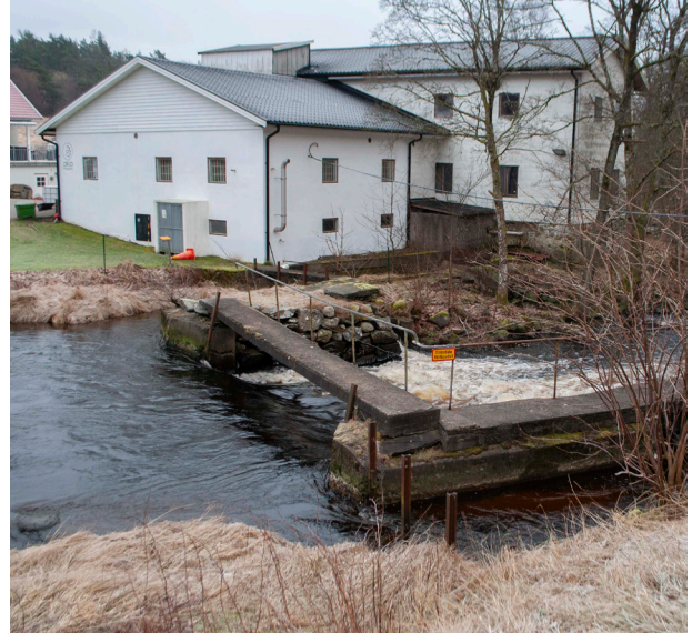
Den östra kvarnen har en mer modernistisk karaktär, till stora delar byggd på 1930-talet.
