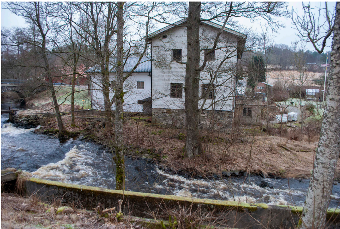
Nedströms efter fallet vid kvarnarna tar ån fart. Ytterligare en tröskel är uppbyggd i ån strax söder om kvarnarna. ytterligare stenar i detta flöde bedöms inte påverka kulturmiljön.
