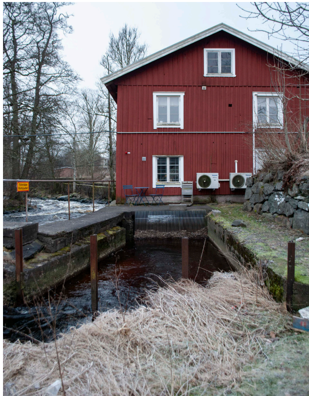
Rännan in till den västra kvarnen. Öppningen till kvarnhjulet under byggnaden är försett med ett galler.
