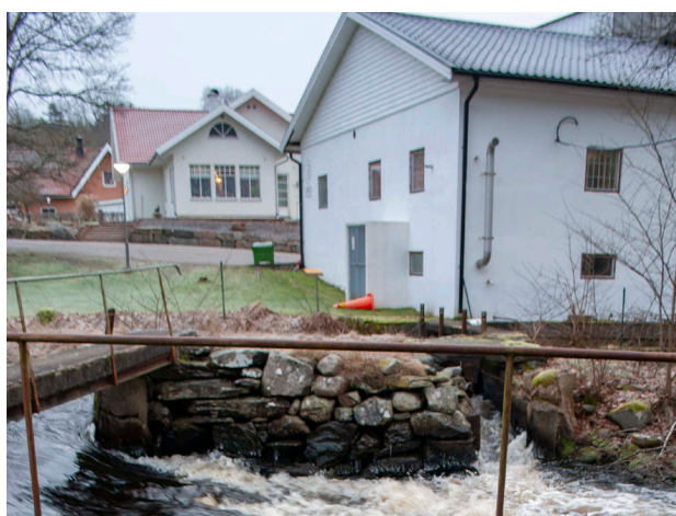
En modern villa strax öster om kvarnen har ersatt en äldre kvarnägarebostad från 1800-talet. Den rödbruna byggnaden i bakgrunden är en av de två banvaktarstugorna som byggdes vid järnvägen genom Alafors.
