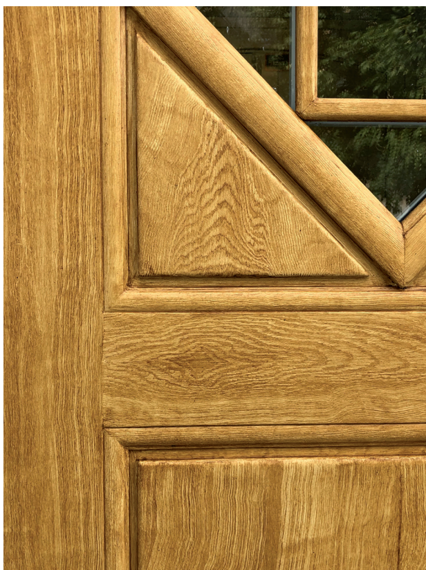
Detalj av dörren på trapphusdelens norra sida vilken ådringsmålades.
