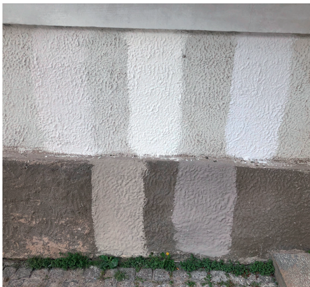
Under arbetets gång gjordes flera kulörprover. De slutgiltiga kulörerna justerades något utifrån de gjorda proverna för att hamna närmre de tidigare nyanserna.
