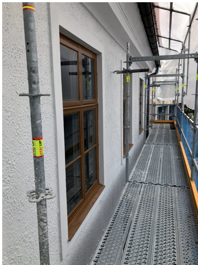
Under arbetets gång. Fasaden är avfärgad och målning av fönster pågår.
