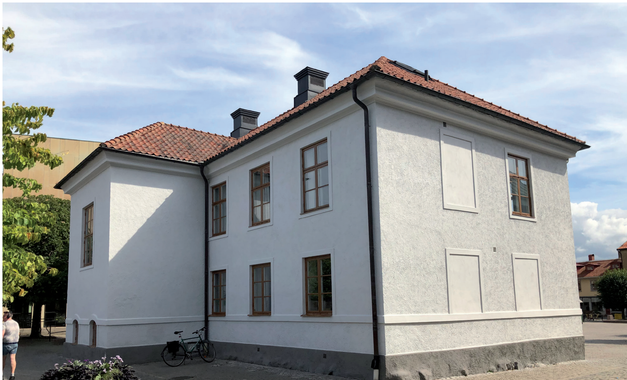
Rådhuset efter renovering. Södra samt västra fasaden.
