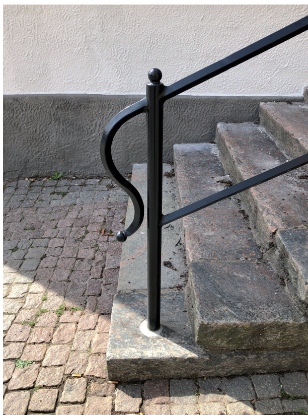
Trappräcke mot norr. Samtliga räcken har skrapats, slipats och målats med Alcro Komplet Grund- & täckfärg metall i en svart kulör.
