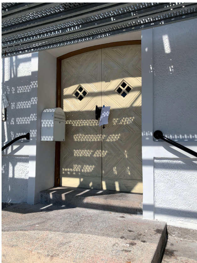
Entrédörren under pågående målning. Bottenfärgen är uppstruken inför den slutgiltiga lasyren.
