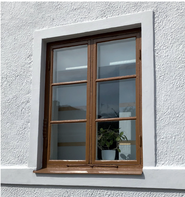
Fönstren har målats om med linoljefärg i en ockrakulör som är snarlik den tidigare kulören.
