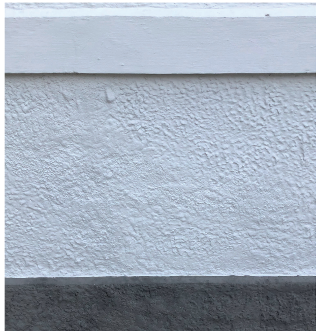
Närbild på den lagade och ommålade putsytan samt sockeln som avfärgats i en grå kulör.
