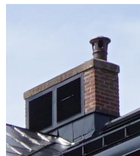
T h: Skorstenspipor i gjutjärn ovanpå skorstenarna.
