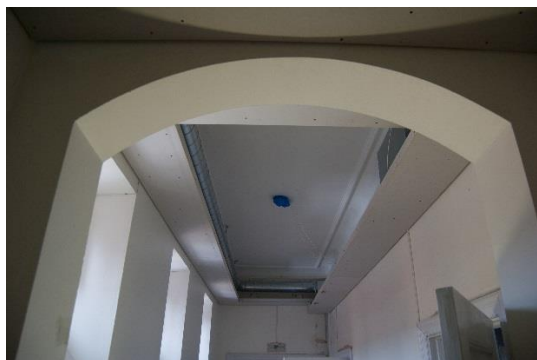
Dolda installationer utan att sänka innertak. Exempel från Halmstads slott.
