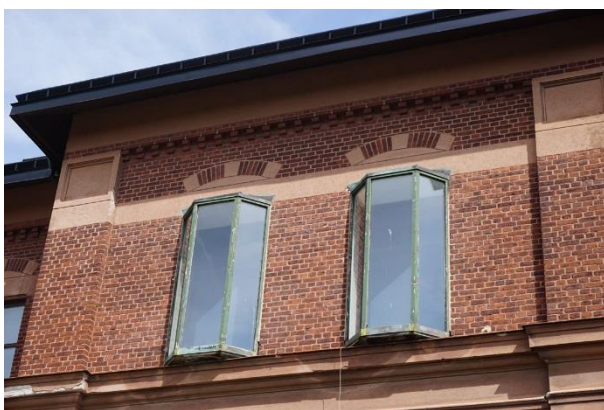
Fönstren i "Laboratoriet" på andra våningen finns med på originalritningarna.
