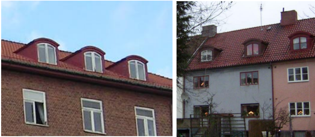
Två exempel på takkupor med segmentformat/väl tak.
