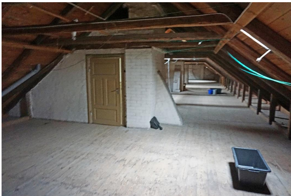
Vindsutrymmet mot öster. Trapphuset är sammanbyggt med murstocken.
