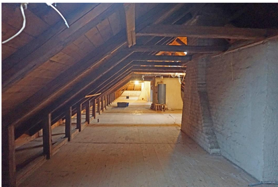
Vindsutrymmet mot väster med snedtak vettande mot söder.
