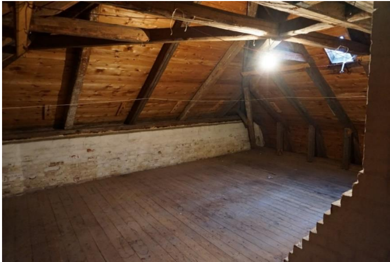
Om delar av takkonstruktionen fortsatt kan vara synlig vid en vindsinredning skapar detta ett mervärde.
