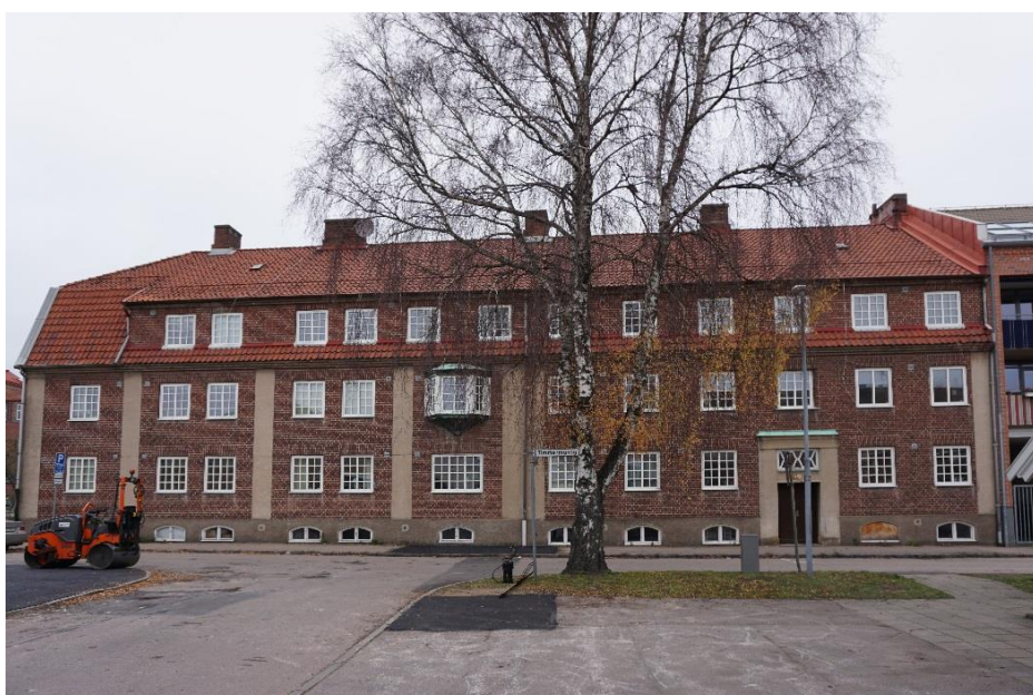
Fasad mot söder. Notera källarfönst- rens segmentbåge- form.
