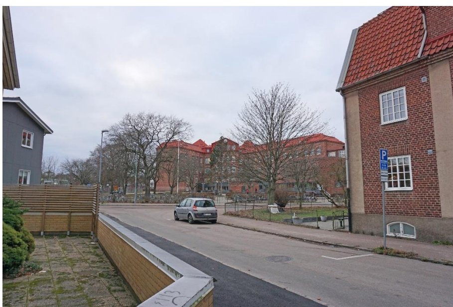
Vy mot nordväst med Brunnbergsskolan i fonden.
