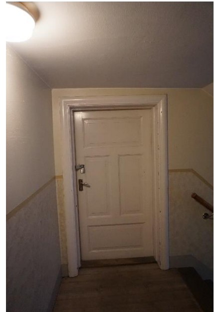
Spegeldörr mot vinden i trapphuset. Takhöjden är lägre än i övriga trapphuset och bör bibehållas intakt.
