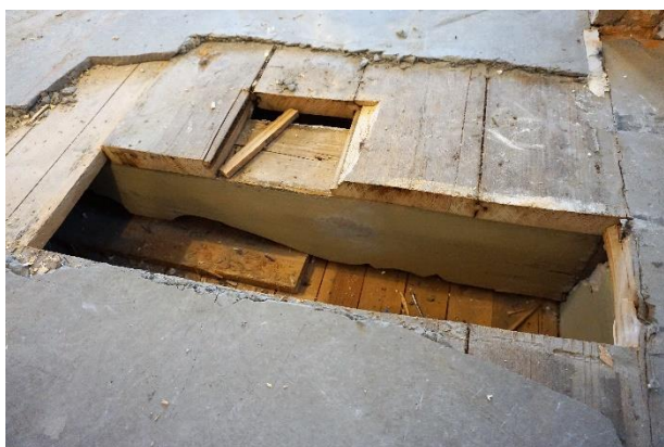
Pågående arbeten på plan 3. Th en profilerad träkonsol i bjälklaget visar den tidigare loftgångens konstruktion.
