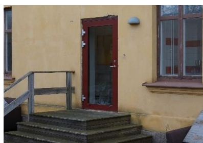
Nyinsatt glasdörr i västra fasaden.
