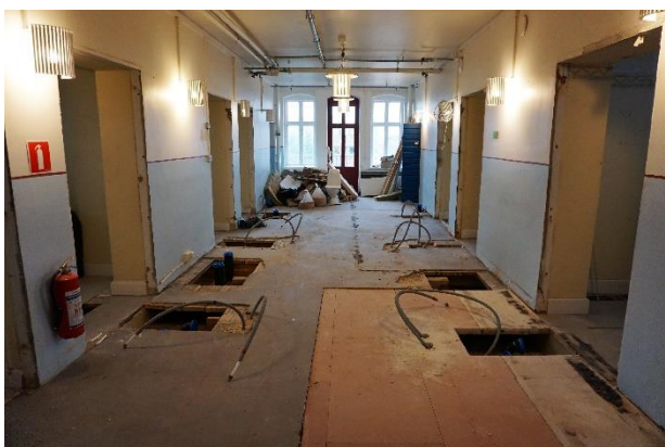
Pågående arbeten på plan 3. Th en profilerad träkonsol i bjälklaget visar den tidigare loftgångens konstruktion.
