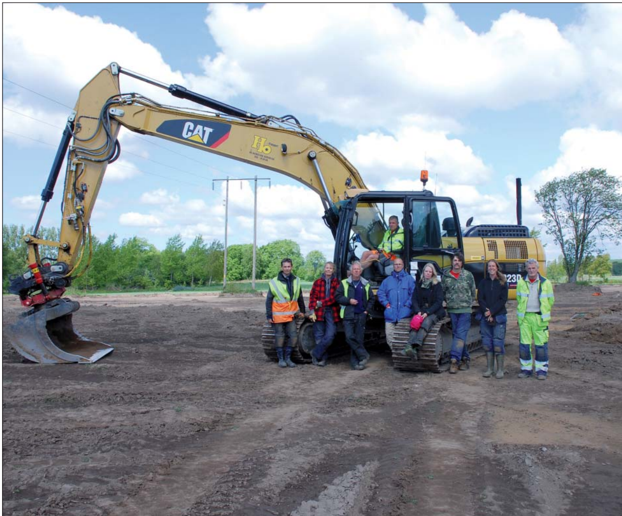
Arbetsbild 1. Arbetsstyrkan samlade framför grävmaskinen. I maskinen sitter Uffe Larsson. Stående från vänster är Per Wranning, Katarina Streiffert Eikland, Lennart Carlie, Carl Persson, Marie Nyström, Mats Nilsson, Stina Tegnhed samt dumperföraren Morgan Johansson. Med på bild finns inte Andreas Jansson och Linn Mattson. Foto: Jonas Paulsson.
