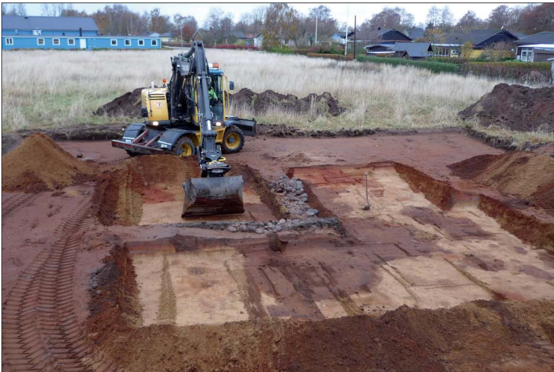
Figur 3 bilaga 1. Foto där nedgrävningarna avtecknar sig vid en andra avbaning. Foto Leif Häggström
