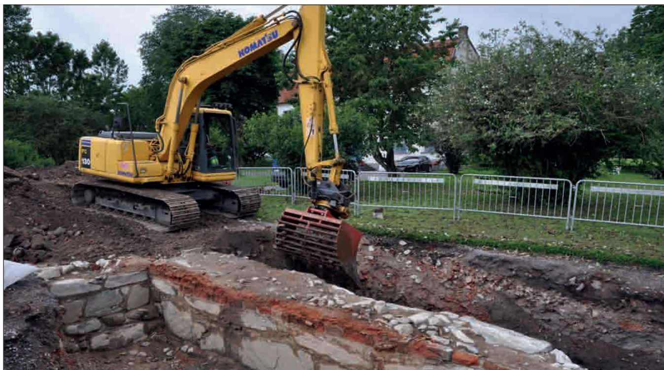
Fig 44 Den 16 juli lades schaktet igen, norr om tillbyggnaden, med de uppgrävda massorna (fotonr 2011-85-154).
