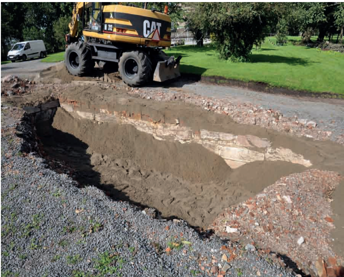
fig 52 Sanden lades upp mot innermuren (fotonr. 2011-85-179).
