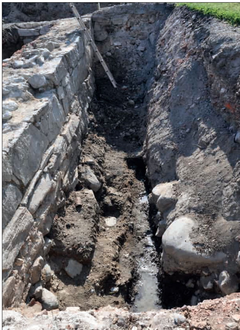
Fig 36. Det tömda diket 3151 – 2793. Man ser här tydligt att de stora markstenarna t. v. ligger i en igenfyllning och inte ursprungligen tillhör muren. Likaså ingår de stora markstenarna t. h. i en fyllning. Sedd mot väster. Foto: Lena Bjuggner (fotonr 2011-85-89).
