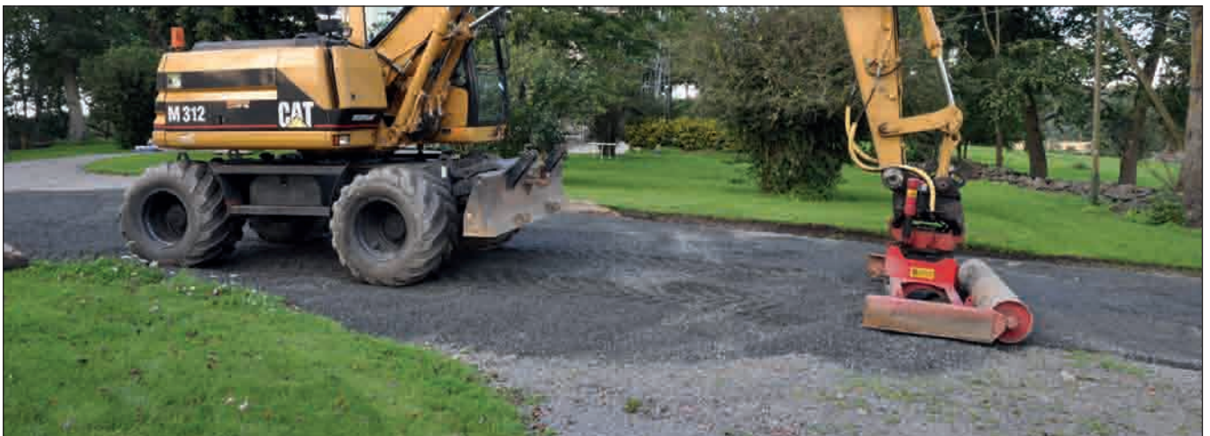
fig 59 Grus lades på och packades (fotonr. 2011-85-197 respektive 2011-85-199).
