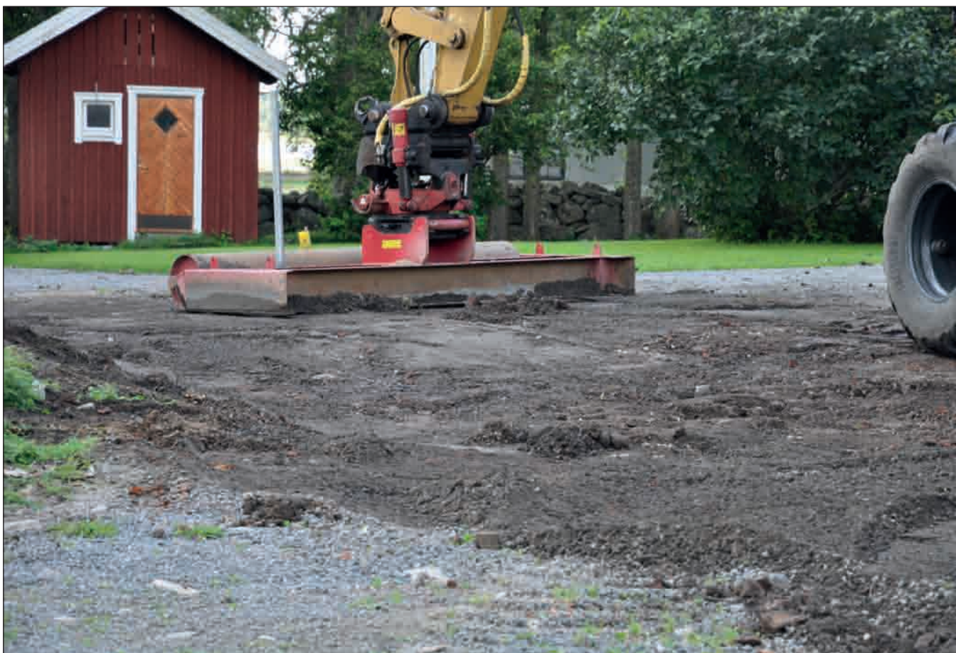
fig 58 Markytan packades med Sven-Olofs specialvält (fotonr. 2011-85-194).
