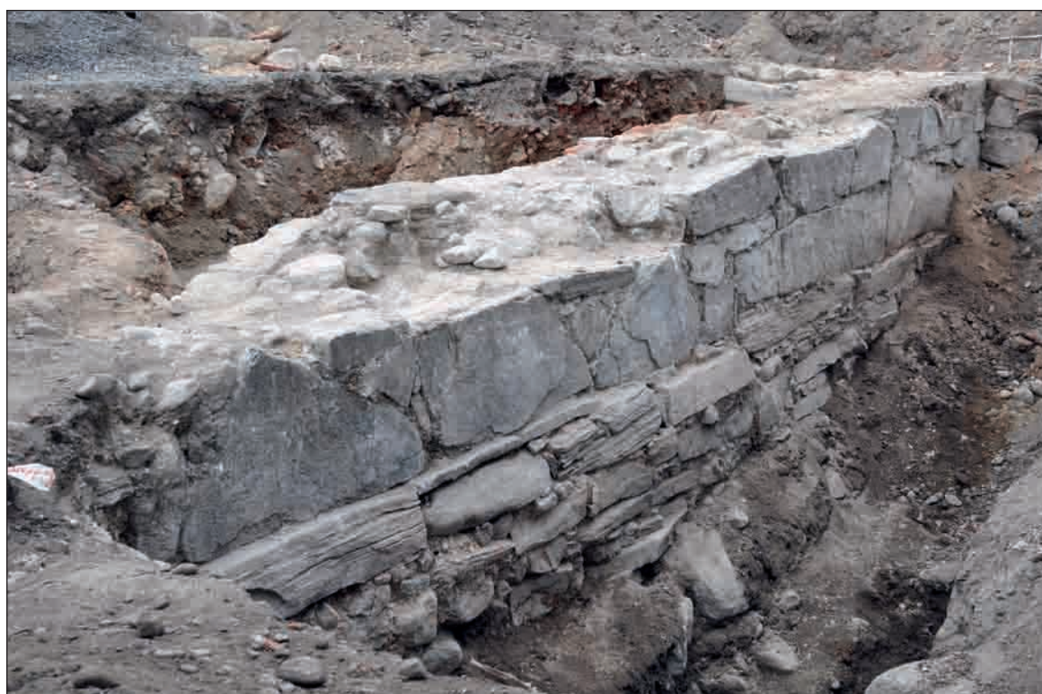
Fig 11. Norra (utvändiga) sidan av tillbyggnadens norra grund och dagermur. Sedd mot VSV. Foto: Lena Bjuggner (fotonr. 2011-85-111).
