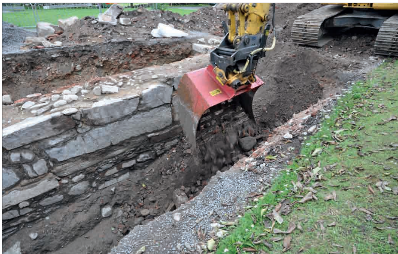
fig 46 Schaktet fylldes upp från väster med finare massor närmast muren. Grövre material placerad i schaktets norra del. (fotonr. 2011-85-159).
