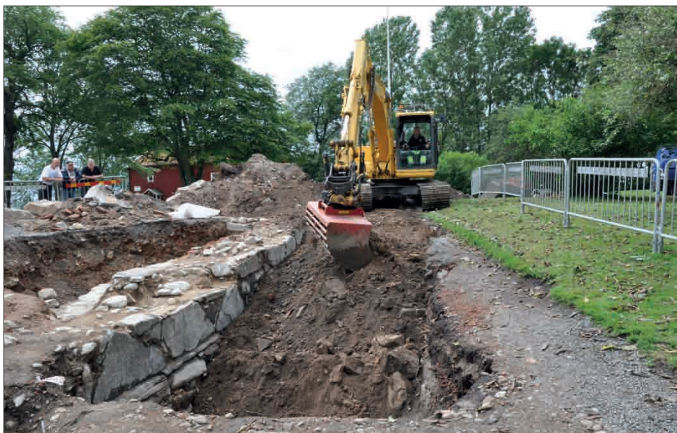
fig 47 Schaktet fylldes successivt (fotonr. 2011-85-161).
