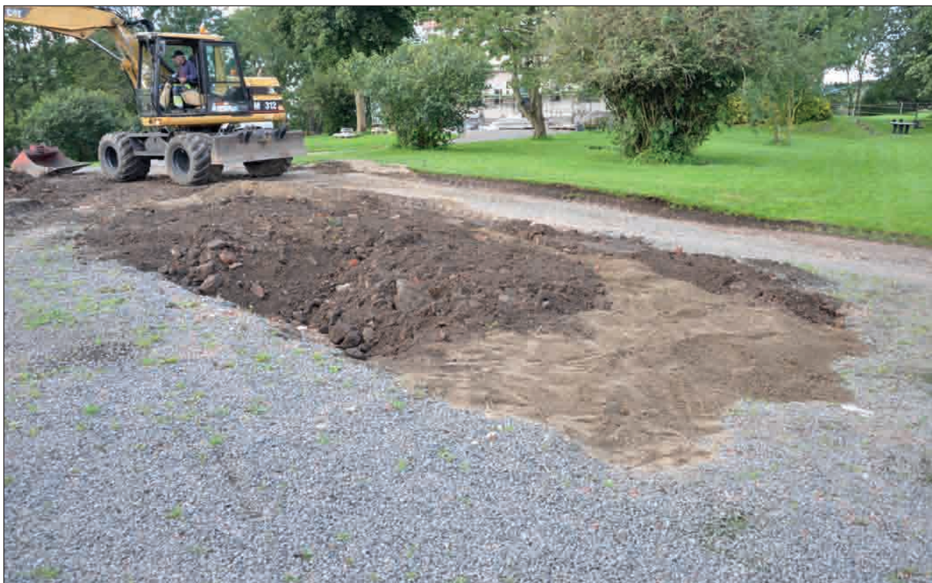
fig 57 Efter några timmar var schaktet igenfyllt (fotonr. 2011-85-191).
