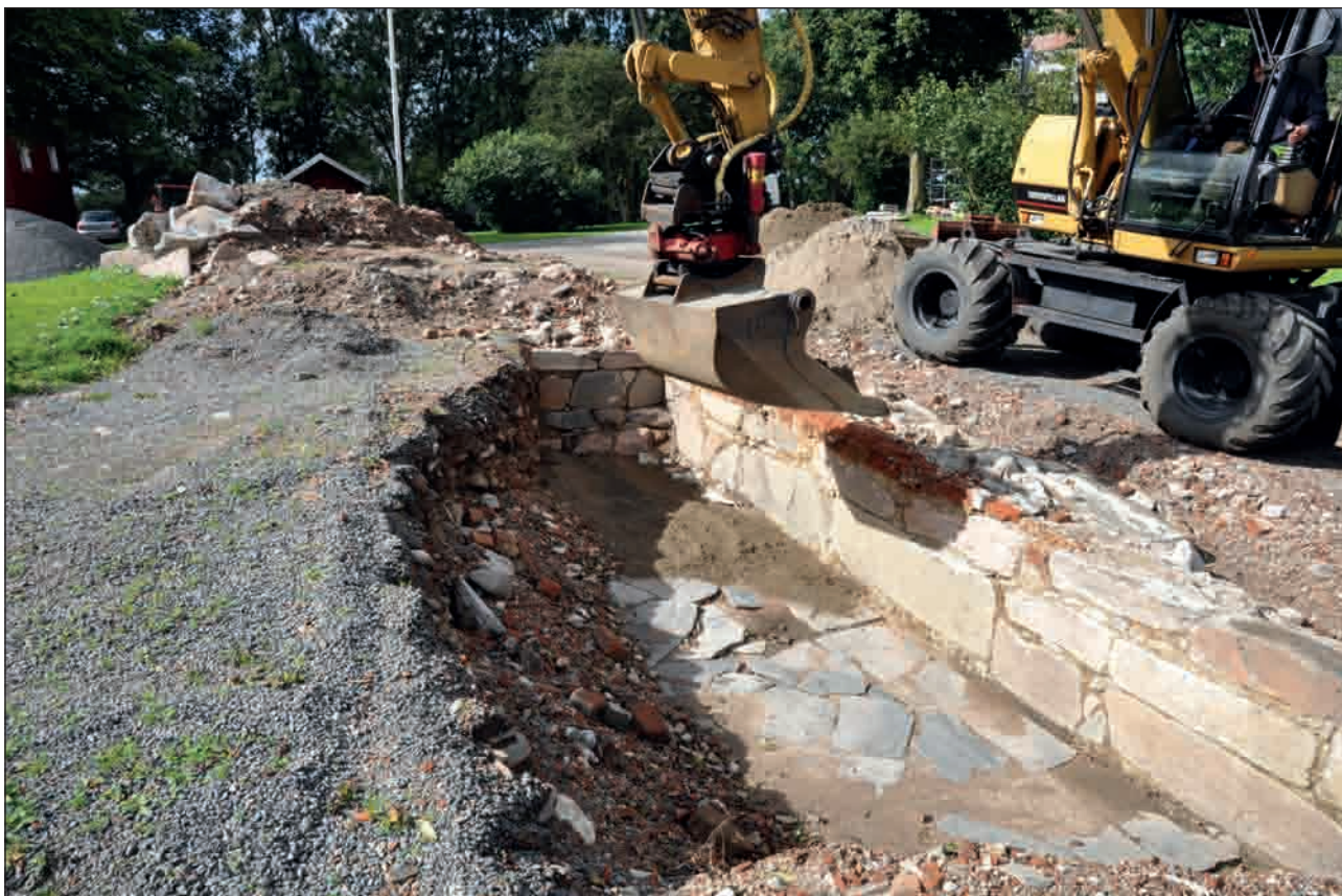
fig 50 Några decimeter sand fylldes på ovanpå golvet och markduken (fotonr. 2011-85-171).
