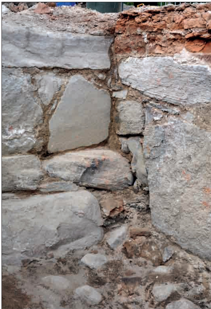
Fig 10. Stötfog mellan tillbyggnad och östra längan. Sedd mot NV (a) och SV (b). Foto: Lena Bjuggner (fotonr. 2011-85-99 och 2011-85-119).
