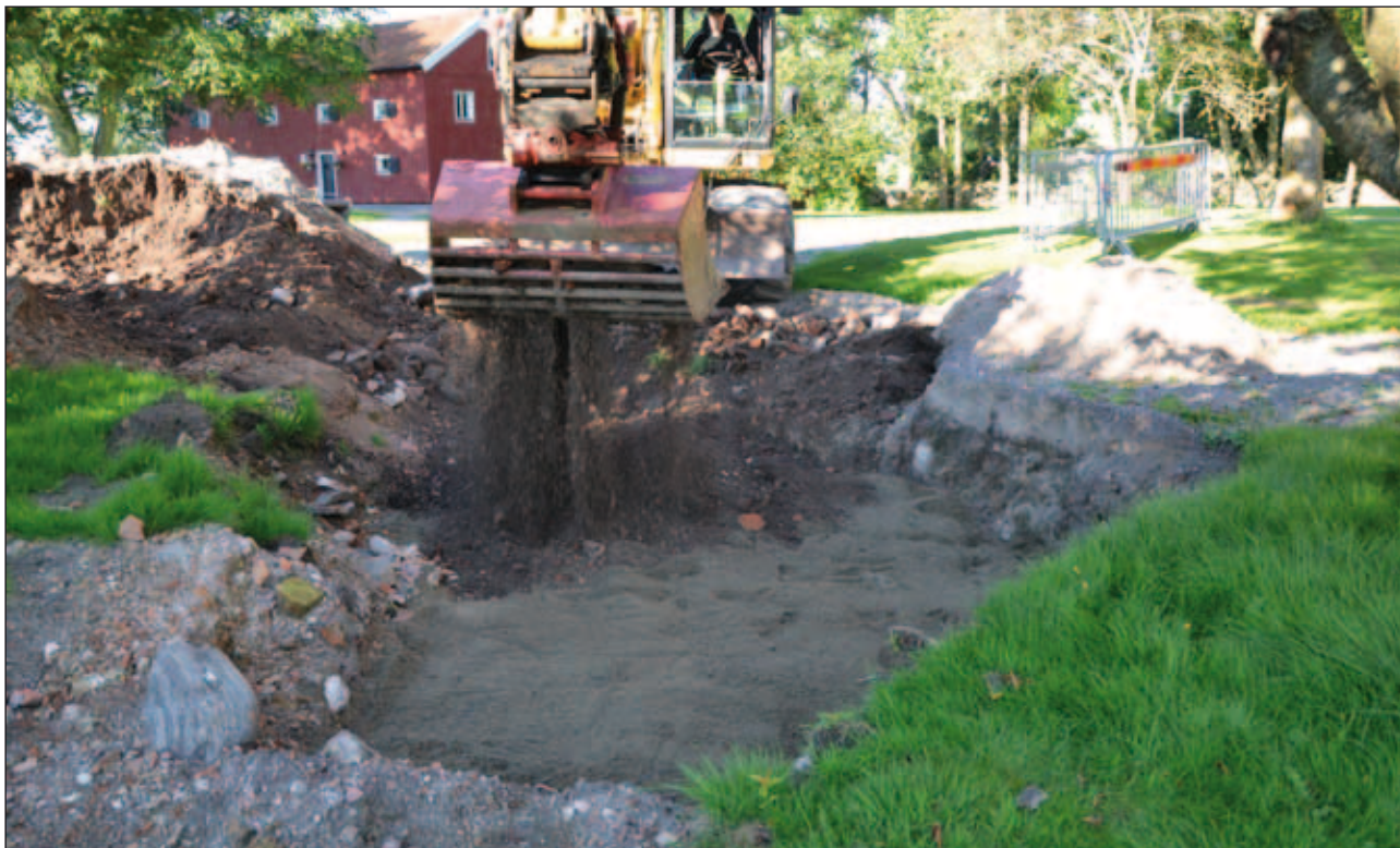
Fig 56. De upprävdade massorna, som harpats, återfylls ovanpå sandlagret. Mot sydväst (fotonr 2013-17-170).
