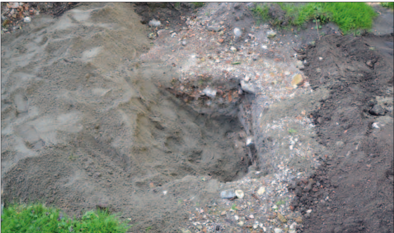
Fig 50. Detalj av återfyllning med sand i grävenheten 7884. Mot söder (fotonr 2013-17-175).
