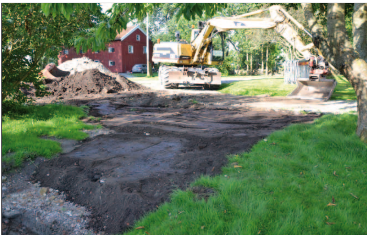
Fig 59. Gammal och ny grus läggs på uppfarten. Massorna har packats inom ytan med grävmaskinen. Mot sydväst (2013-17-173).
