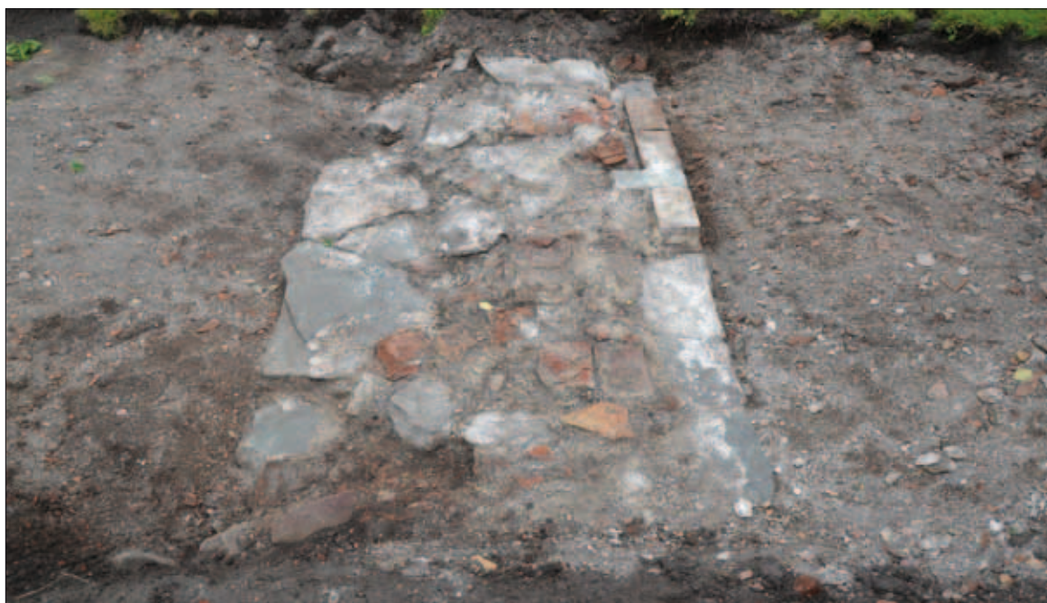
Fig 16. Muren K7571 med bevarat munkförband (K10507), mot norr. Fotograf: Lena Bjuggner (fotonr. 2013-17-10).
