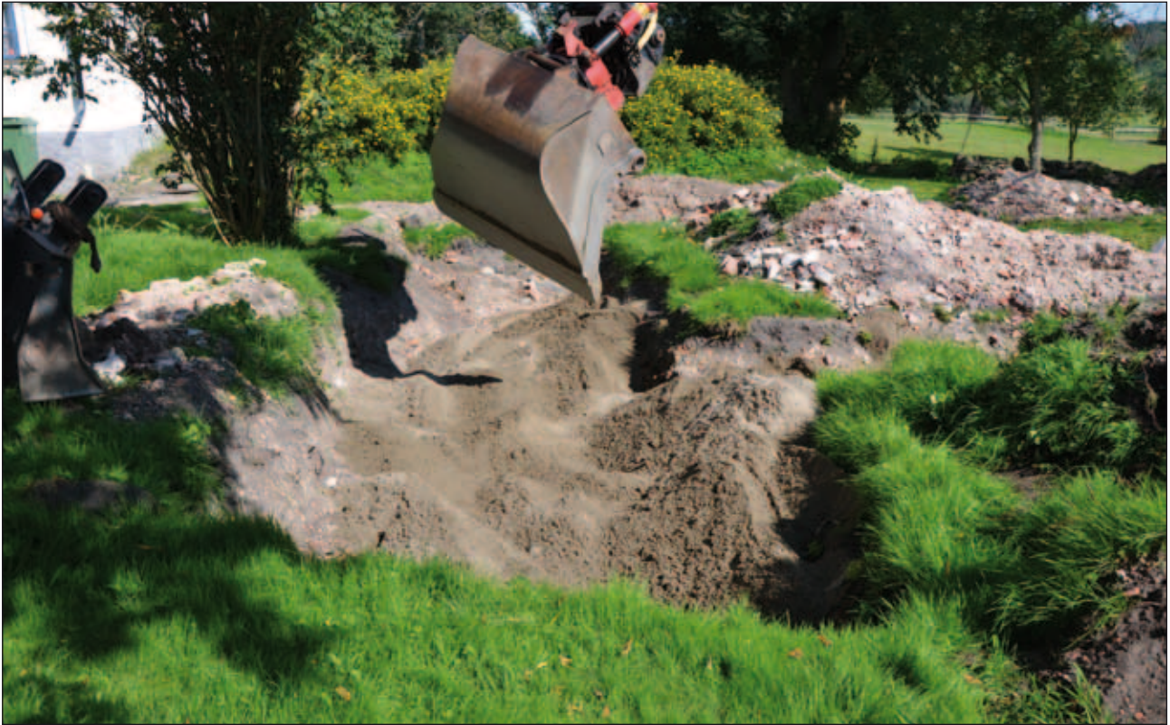
Fig 64. All sandpåfyllnad i schaktet. Mot norr (fotonr 2013-17-182).
