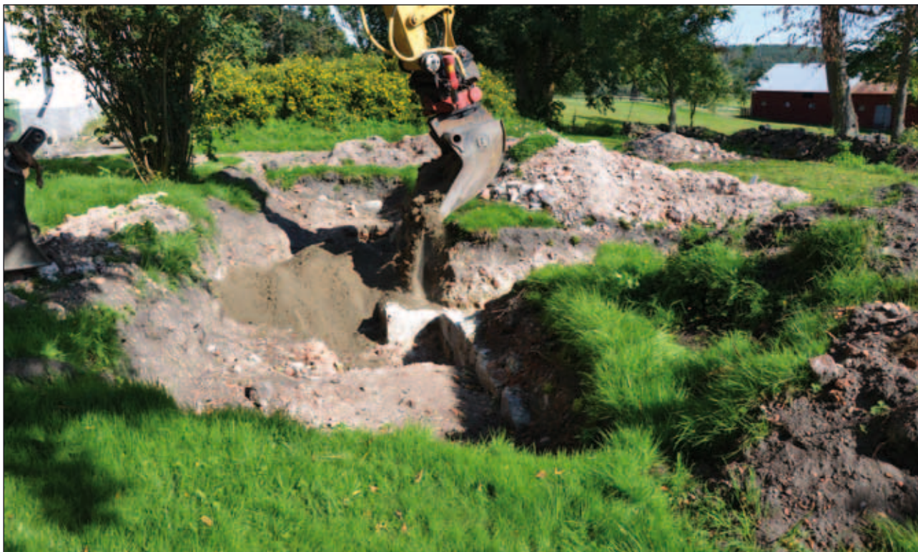
Fig 61. Sand läggs över och mot muren K9394. Mot norr (fotonr 2013-17-179).
