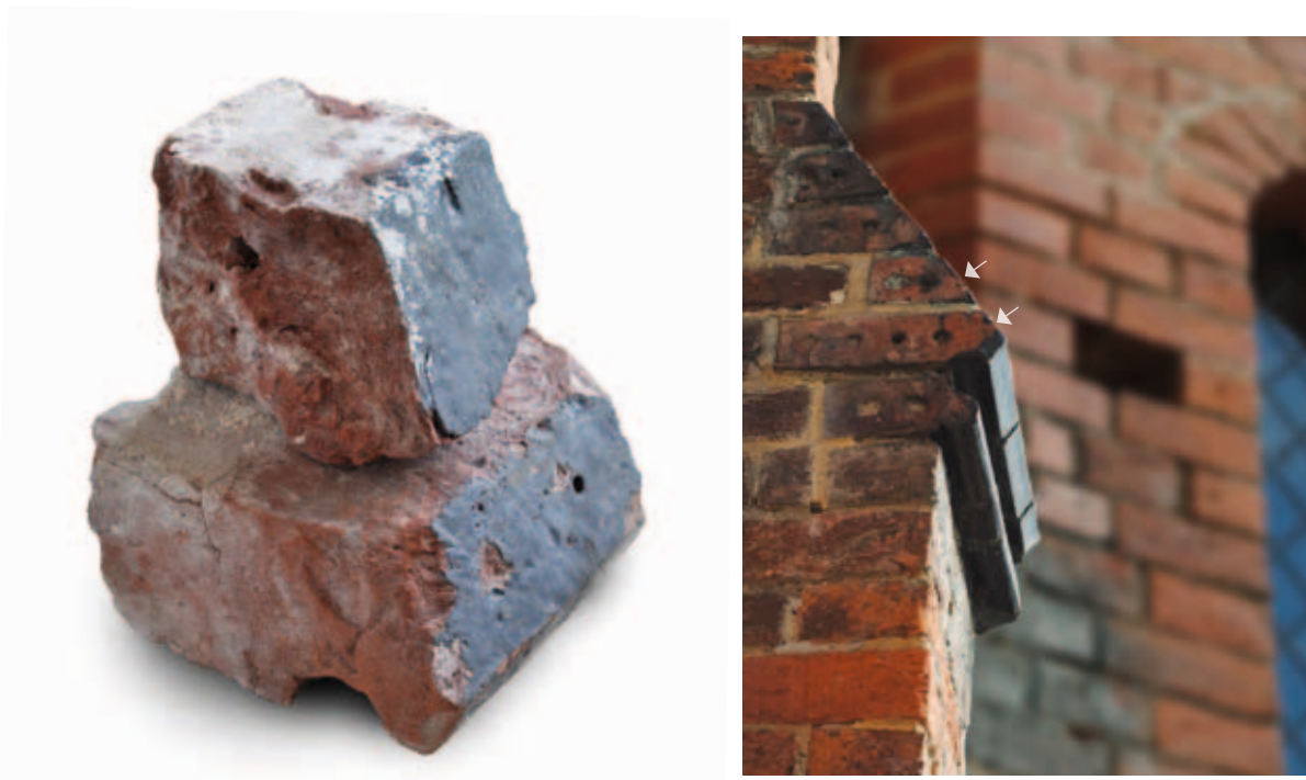
Fig 47. Vänstra bilden: Två svartglaserade tegel där den undre har fungerat som droppnäsa (fnr 266). Foto: Anders Andersson. Bilden till höger, som är från benediktinerklostret i Neukloster, Mecklenburg-Vorpommern, visar för hur tegelstenarna varit murade. Foto: Lena Bjugger.
