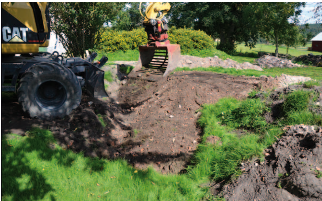
Fig 68. Merparten av de uppgrävda massorna har lagts tillbaka. Mot norr (fotonr 2013-17-186).
