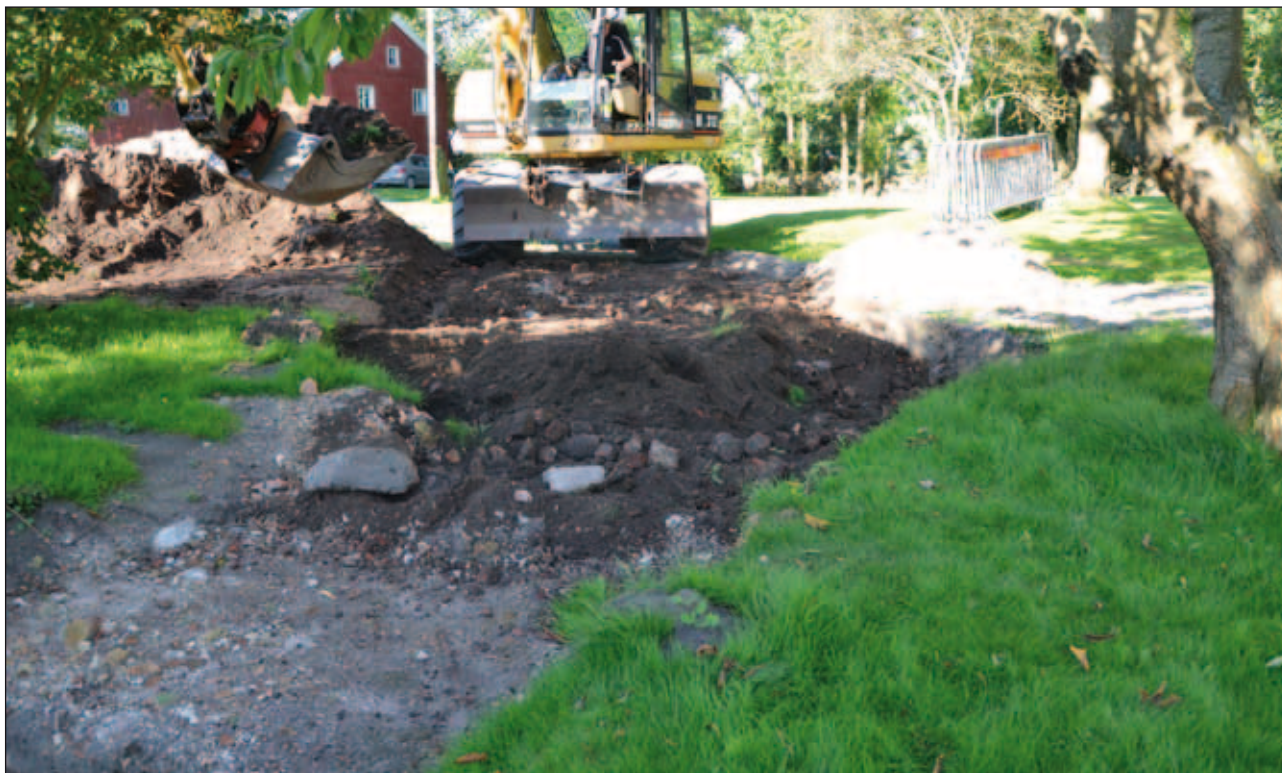
Fig 58. Merparten av schaktet är återfyllt med uppgrävda massor. Mot sydväst (2013-17-172).
