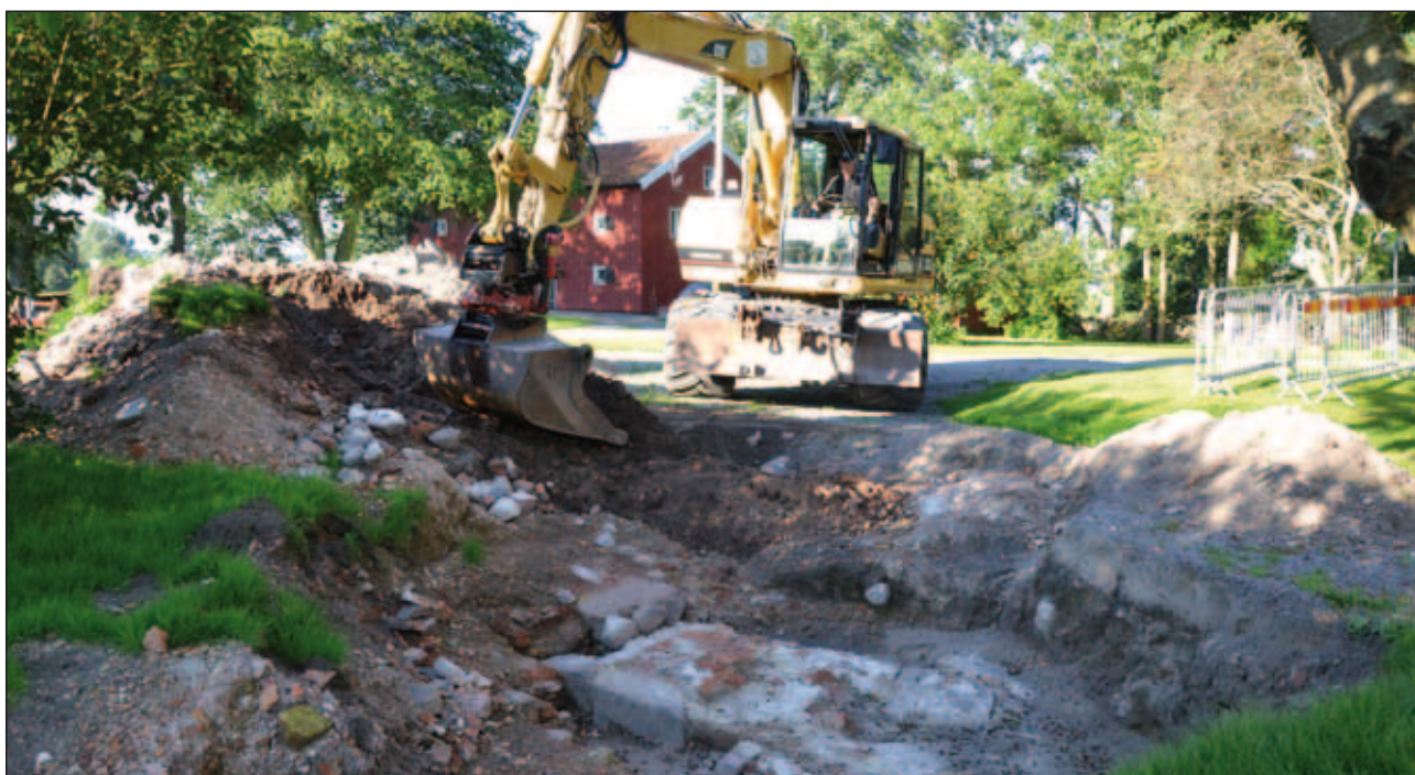
Fig 53. De uppgrävda massorna återfylls i de mindre känsliga delarna och inte direkt mot murarna. Mot sydväst (fotonr 2013-17-167).
