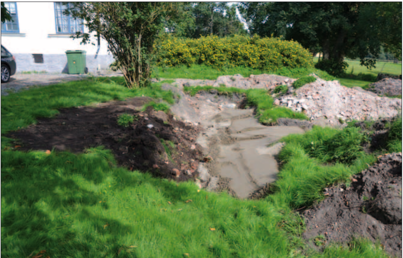
Fig 65. Sandlagret har försiktigt jämnats ut med grävmaskinens skopa. Mot norr (fotonr 2013-17-183).
