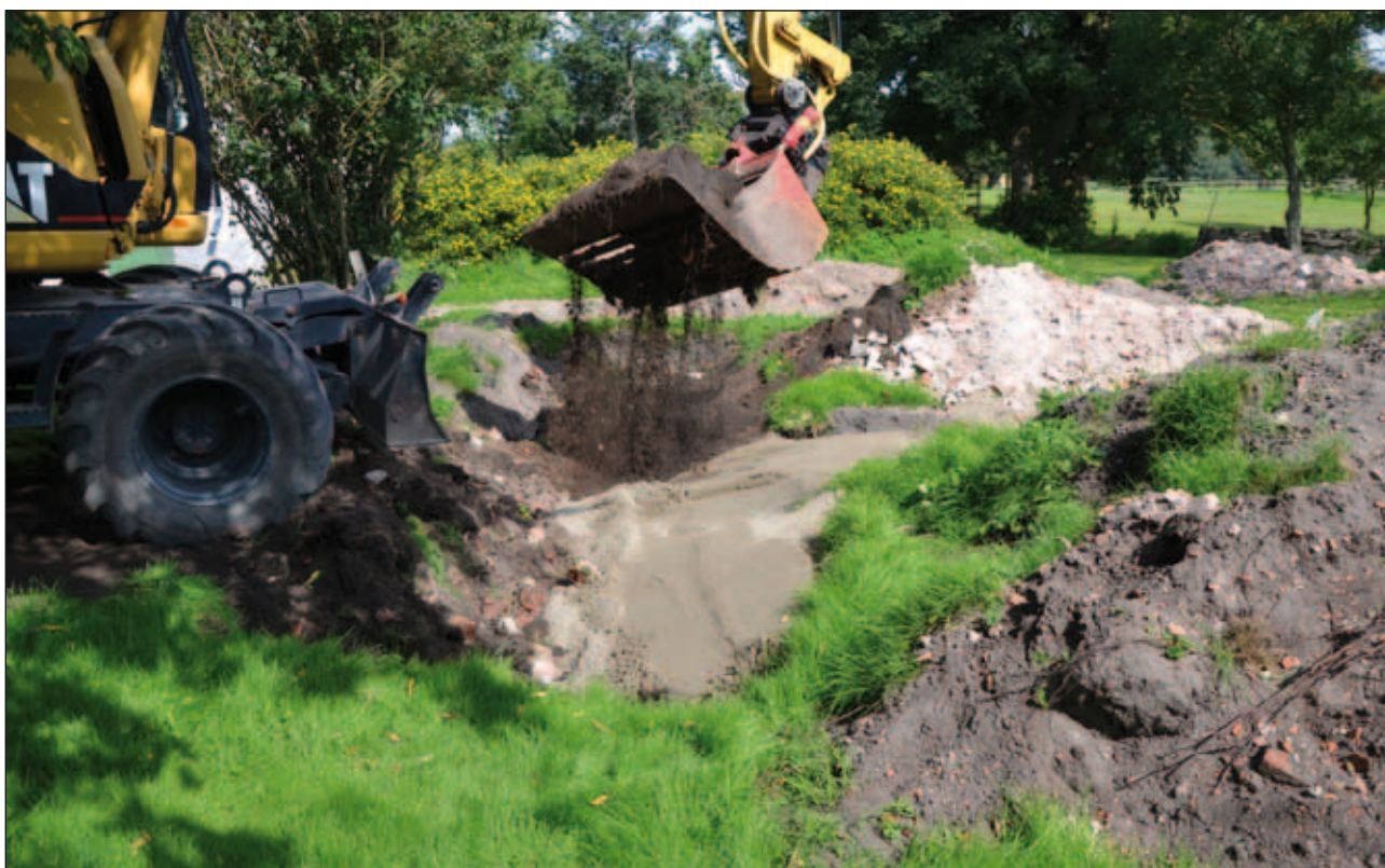
Fig 67. Harpad matjord från de uppgrävda jordmassorna läggs över sanden och sten och tegel läggs i kanten av schaktet. Mot norr (fotonr 2013-17-185).
