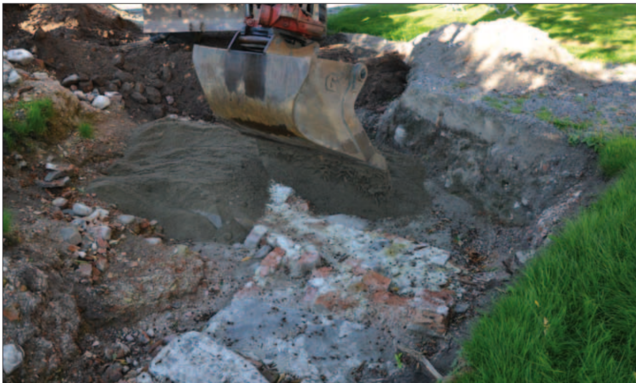
Fig 54. Sand förs ut över de känsliga tegelmurarna. Mot sydväst (fotonr 2013-17-168).
